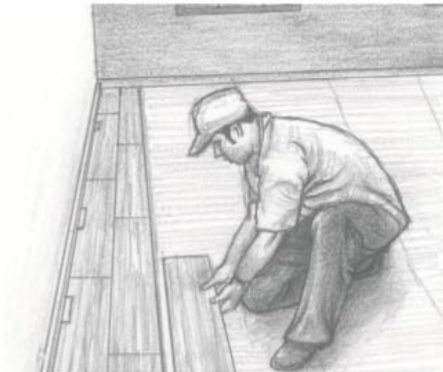
Figura 3 – Instalação do piso laminado melamínico por encaixe.
