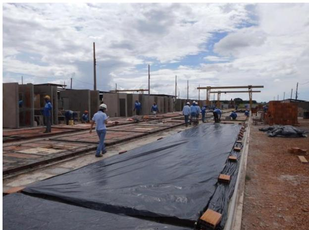
**Figura 24 – Proteção dos painéis com lona plástica durante a cura**
