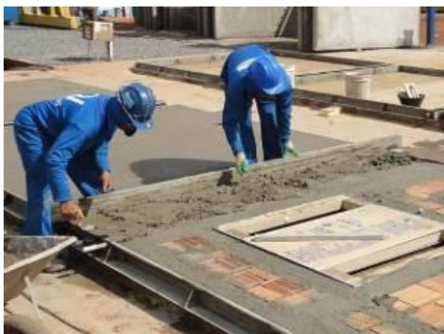
**Figura 22 – Aplicação da argamassa de revestimento sobre o chapisco ainda úmido**
