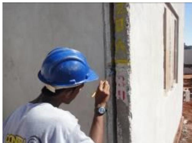
**Figura 30 – Proteção anti-corrosiva aplicada na região das soldas entre painéis**
