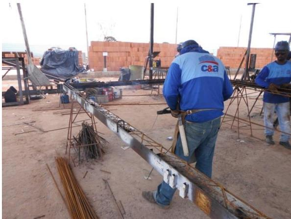
**Figura 11 – Preparação das armaduras na central de armação, com emprego de gabarito**
