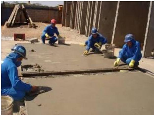
**Figura 23 – Acabamento do revestimento em argamassa em uma das faces do painel (na horizontal)**
