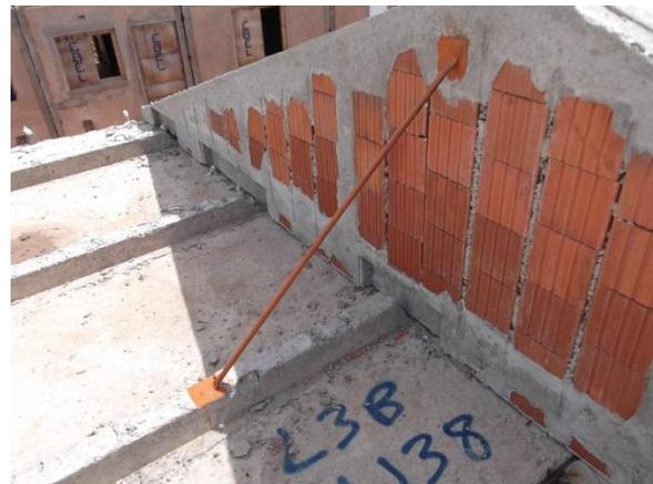
**Figura 34 – Oitão apoiado e fixado à laje**
