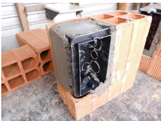
**Figura 15 – Caixa elétrica fixada ao bloco**
