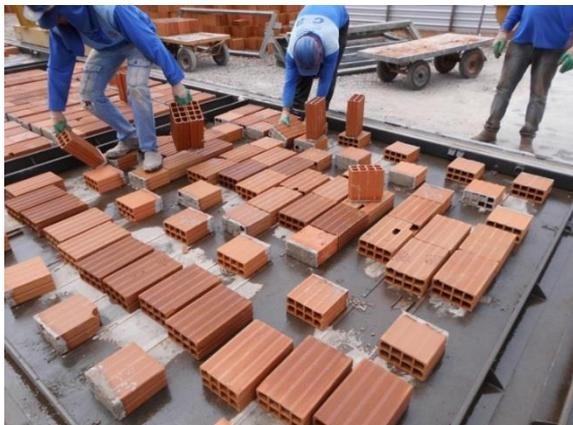
**Figura 13 – Posicionamento dos blocos cerâmicos**
