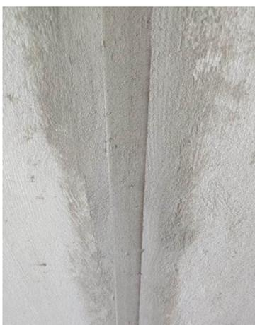
**Figura 31 – Detalhe do rebainho no revestimento para execução das juntas entre painéis**
