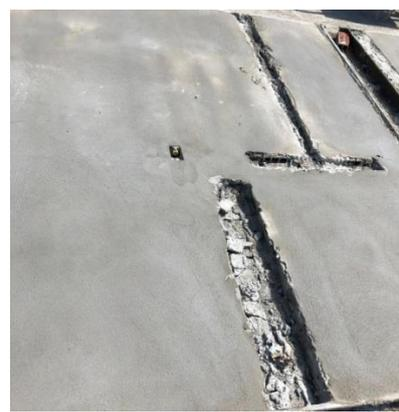
**Figura 16 – Nichos no painel para posicionamento das tubulações hidráulicas**
