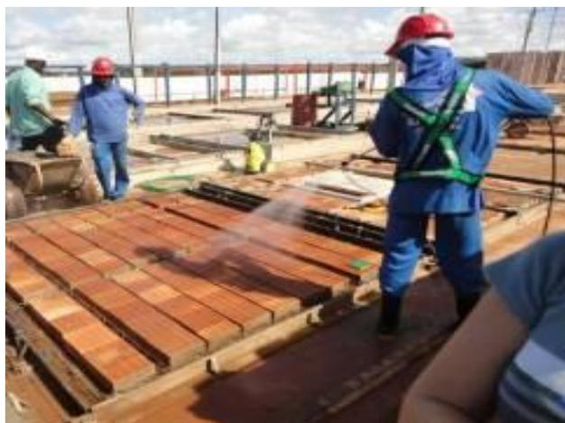
**Figura 19 – Umedecimento do painel antes da concretagem das nervuras e do quadro externo**
