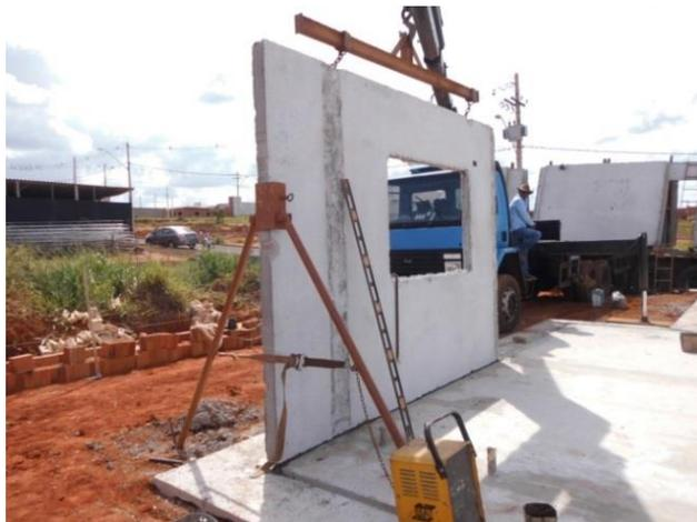
**Figura 28 – Posicionamento dos painéis para montagem em obra**
