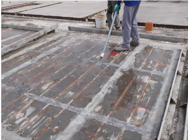
**Figura 9 – Limpeza da superfície da pista de concretagem**
