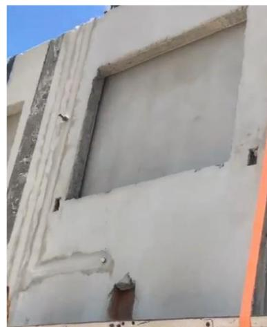
**Figura 18 – Painel já com a tubulação de hidráulica instalada nos seus respectivos nichos de hidráulica**
