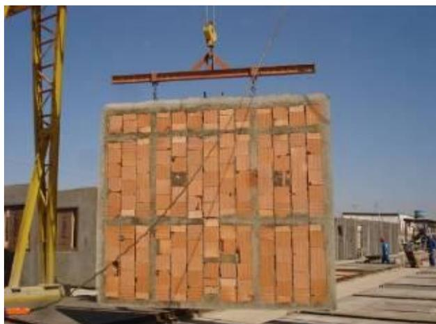
**Figura 25 – Içamento do painel para aplicação do revestimento em argamassa na outra face do painel (na vertical)**
