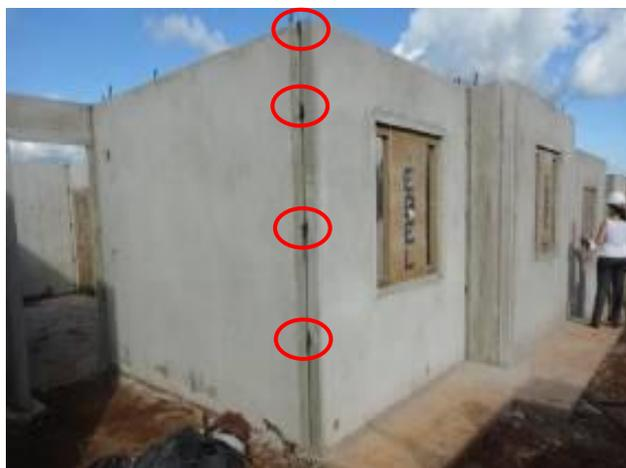
**Figura 29 – Distribuição dos pontos de solda entre os painéis**
