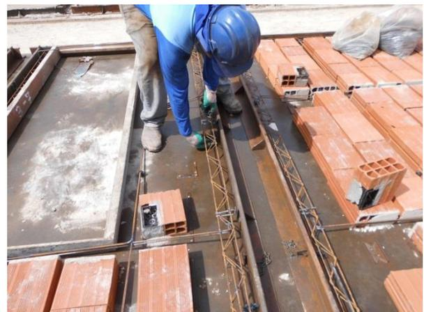
**Figura 12 – Posicionamento das armaduras com os espaçadores plásticos**
