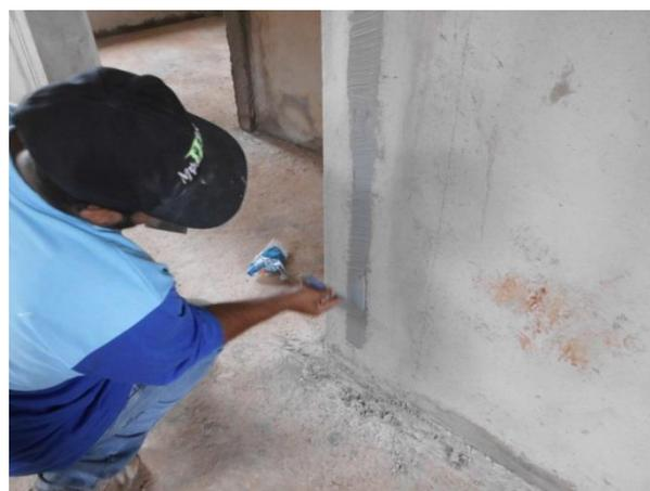
**Figura 32 – Aplicação do selante acrílico na junta entre painéis**
