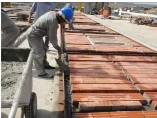
**Figura 20 – Lançamento do concreto nas nervuras**
