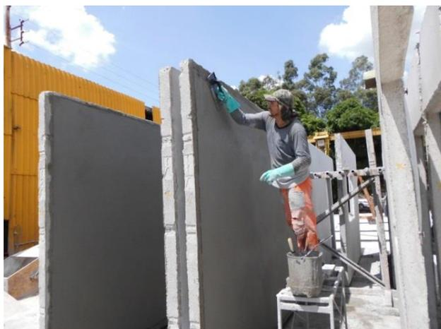
**Figura 26 – Execução do revestimento de argamassa no painel na posição vertical**
