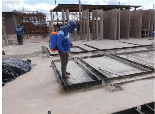
**Figura 10 – Aplicação do desmoldante na pista de concretagem e na forma**
