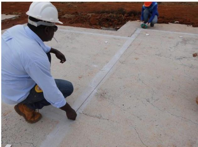
**Figura 27 – Locação das paredes na fundação para apoio dos painéis**
