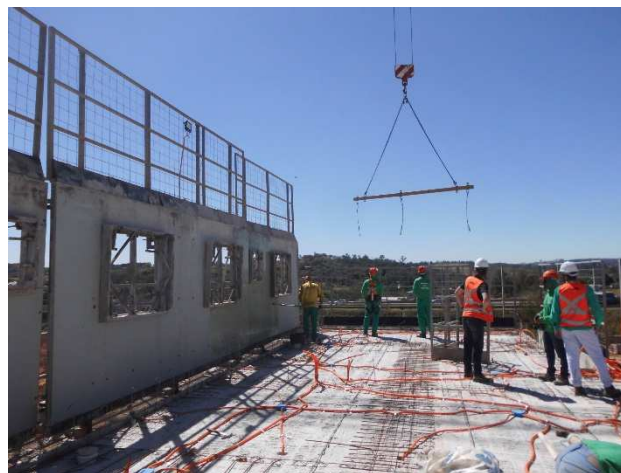
Figura 4 – Montagem da pré-laje
