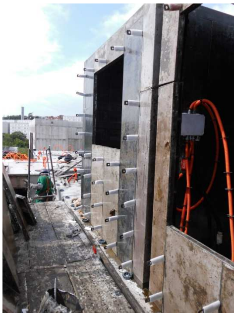
Figura 9 – Montagem das fôrmas e colocação das gravatas
