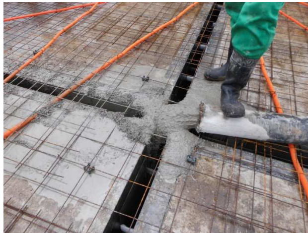
Figura 14 – Concretagem das paredes
