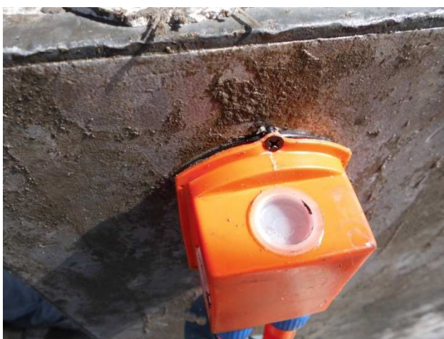
Figura 11 – Caixa elétrica fixada à fôrma com parafuso
