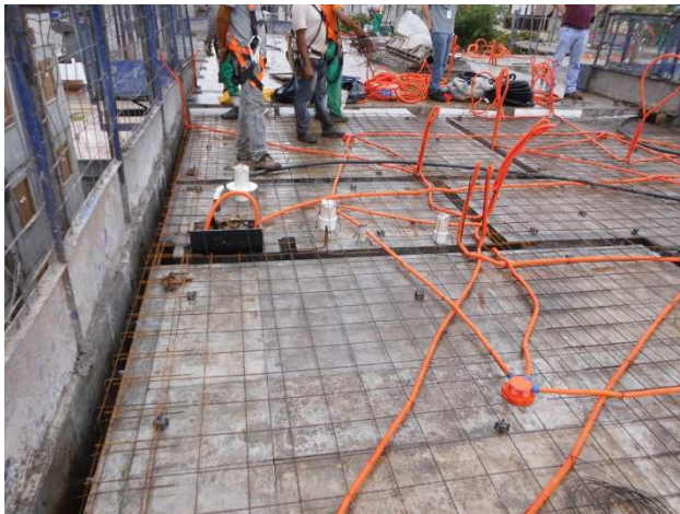
Figura 13 – Montagem da armadura da laje
