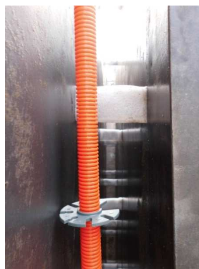
Figura 12 – Espaçador plástico fixado ao eletroduto
