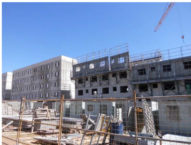
Figura 3 – Montagem das fôrmas das paredes
