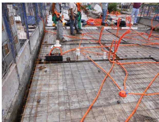
Figura 2 – Montagem das fôrmas e armadura das lajes
