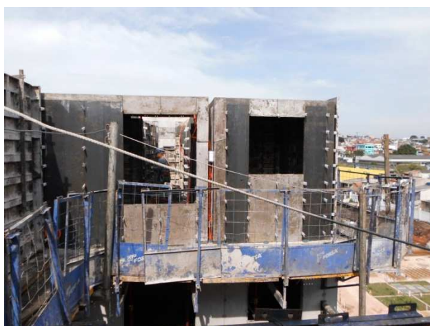
Figura 1 – Montagem das fôrmas das paredes
