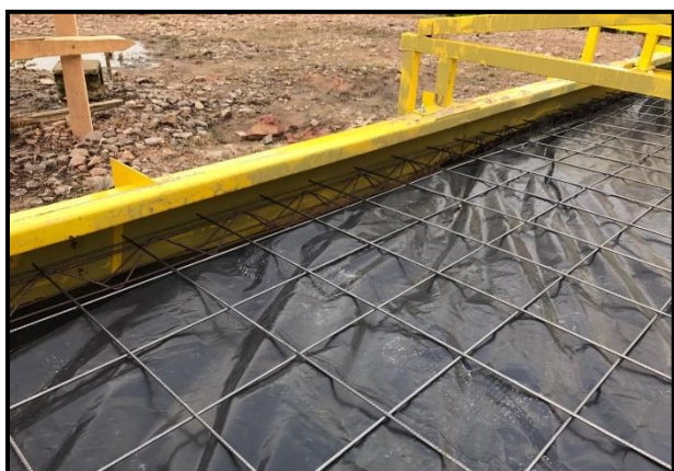
Figura 74 – Armadura do radier (treliça e tela soldada)
