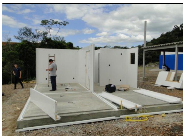
Figura 78- Início da montagem dos painéis de parede.
