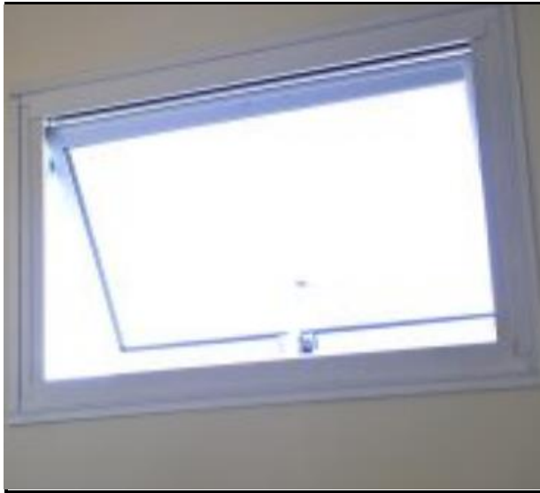
Figura 44– Janela do banheiro
