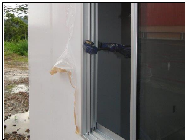
Figura 49 – Encaixe do quadro da janela.
