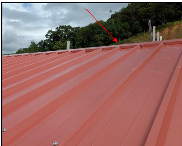
Figura 83 – Instalação da cumeeira.
