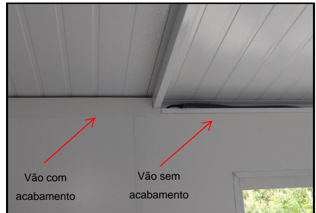
Figura 59 – Vão para tubulação elétrica.
