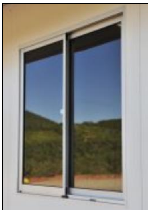
Figura 43- Janela da sala e dos quartos
