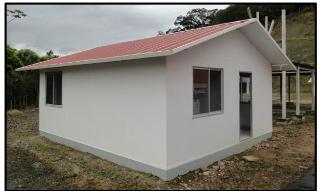
Figura 2- Casa em construção.
