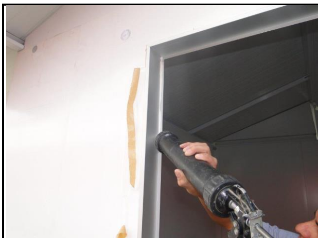
Figura 48 – Aplicação de selante na parte interna do batente.
