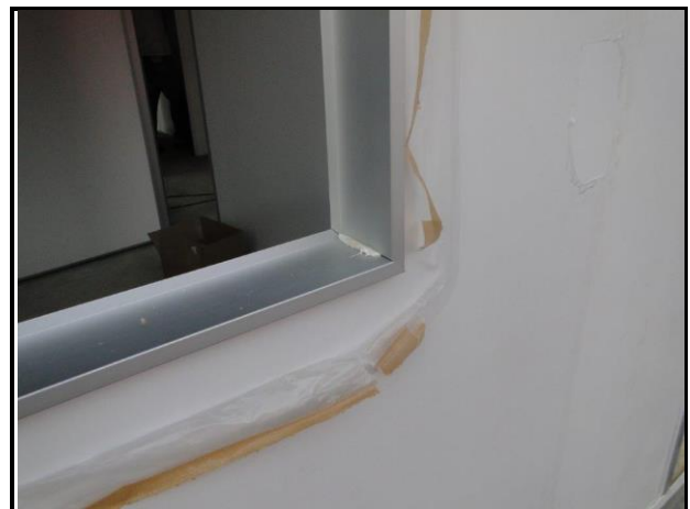
Figura 47 – Encaixe dos contramarcos.
