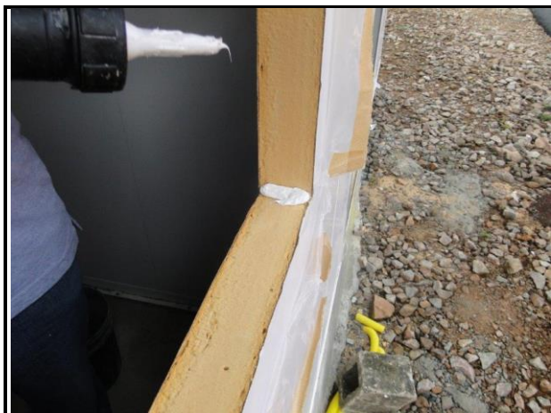
Figura 46 – Aplicação de selante no canto do recorte para a janela.
