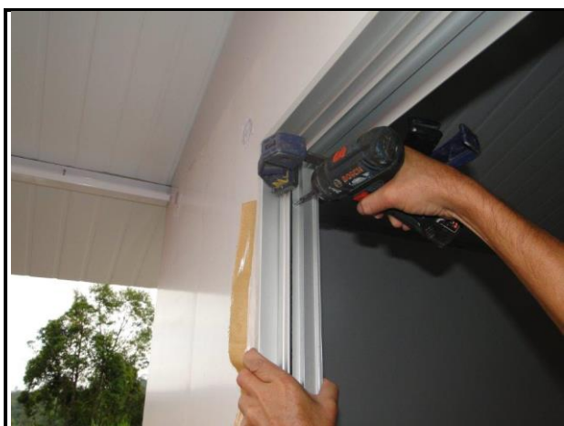
Figura 50 – Fixação da janela com parafuso.
