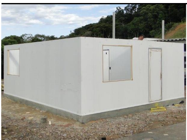
Figura 81 – Fim da montagem das paredes e esquadrejamento final.
