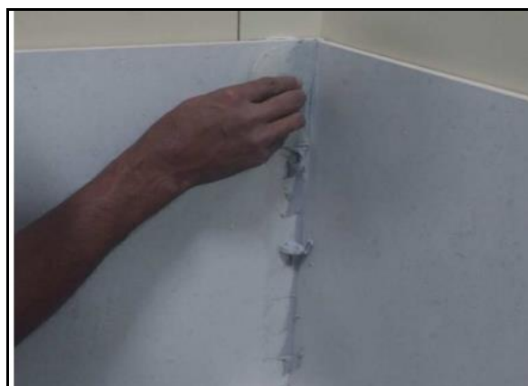
Figura 13- Rejunte epóxi entre as cerâmicas.
