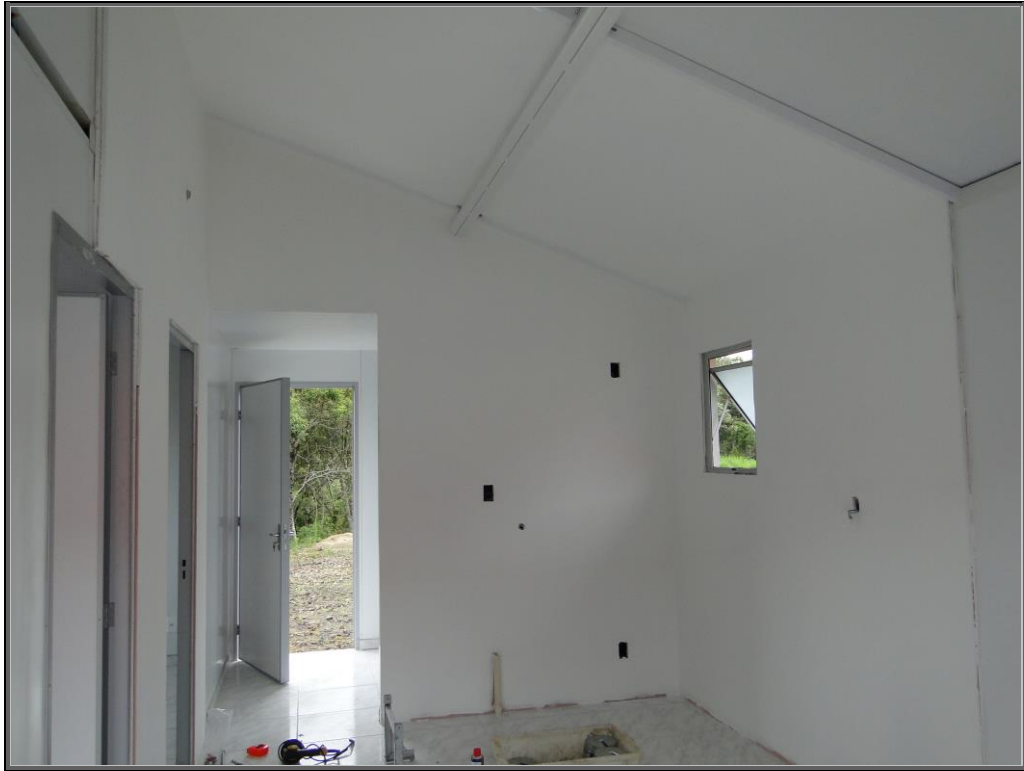
Figura 85 – Vista geral do revestimento em chapas de gesso acartonado (protótipo em fábrica).
