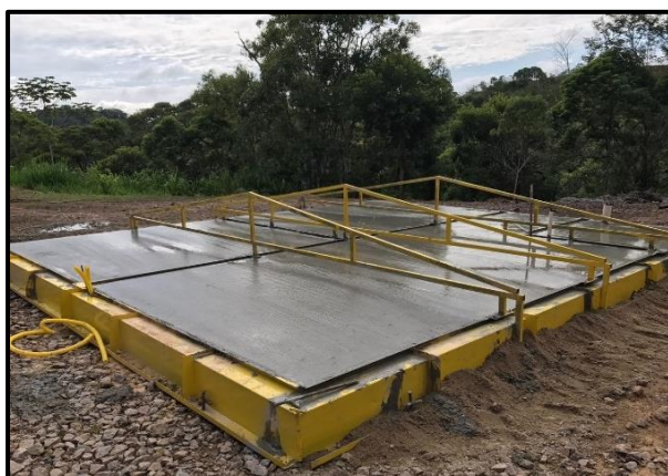
Figura 75 – Radier após concretagem e superfície acabada.
