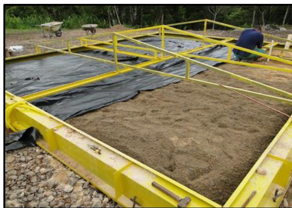
Figura 73 – Aterro no interior da forma e colocação da lona plástica.
