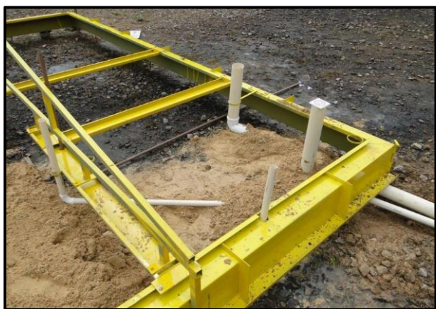
Figura 72 – Posicionamento das tubulações hidrossanitárias.
