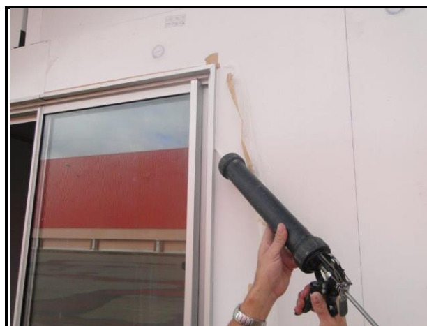
Figura 51 – Vedação com selante das extremidades da janela.
