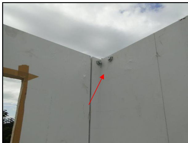
Figura 80- Pinos para blocagem (painel “L”).
