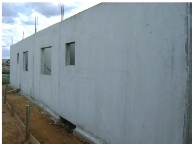
Figura 19 – Posicionamento do painel sobre baldrame
