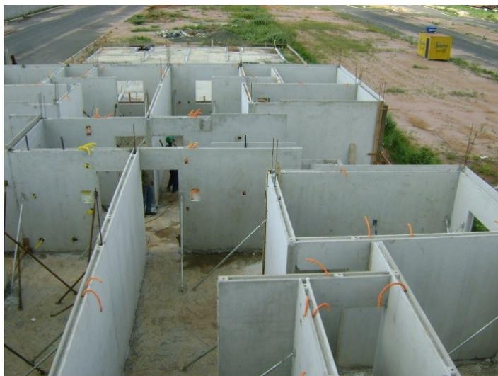
Figura 10 – Vista geral da montagem dos painéis na obra
