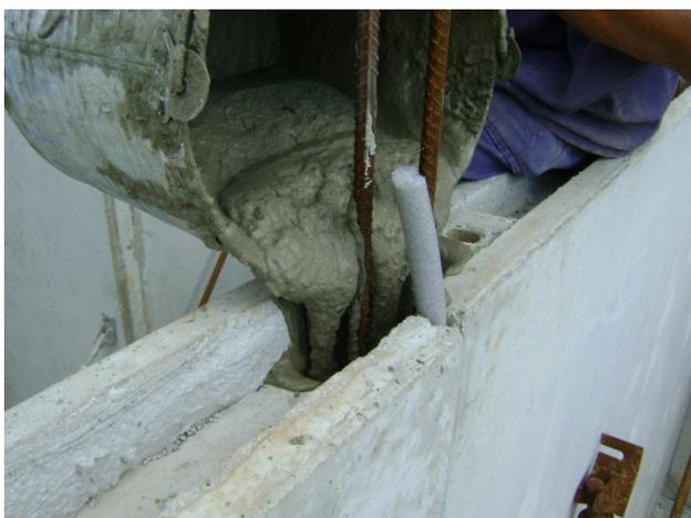
Figura 23 – Grauteamento da ligação entre os painéis, uso de fundo de junta
