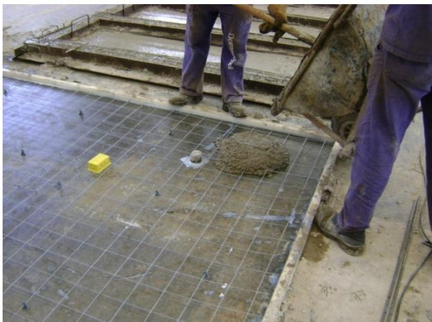
**Figura 13 – Concretagem da face do painel**
