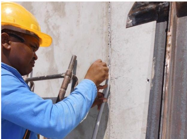
Figura 21 – Colocação do delimitador de fundo de junta
