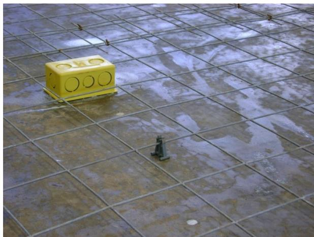
Figura 12 – Utilização de espaçador para posicionamento da tela
