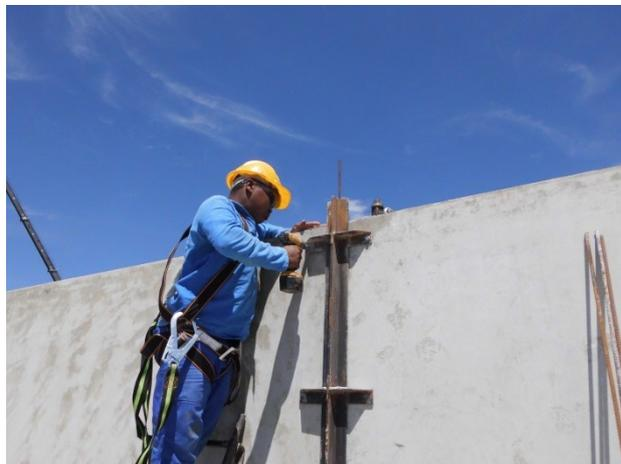
Figura 22 – Fixação do perfil metálico ao painel
