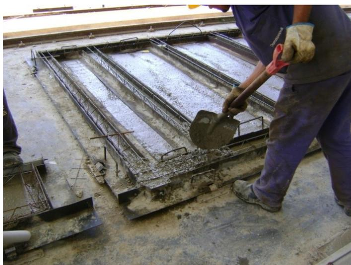
**Figura 15 – Concretagem das nervuras e do quadro externo da primeira placa**
