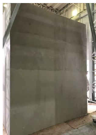
Figura 34 – Aplicação do basecoat sobre as placas de fibrocimento.
