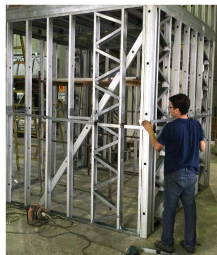
Figura 30 – Contraventamento com a fita de 40 mm x 0,95 mm, na horizontal, a meia altura da parede, e da fita de 70 mm x 0,95 mm na diagonal do quadro.
