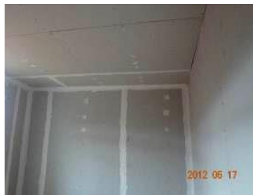
Figura 32 - Acabamento das juntas entre chapas de gesso para drywall.
