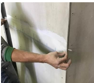
Figura 10 – Aplicação da telas de fibra de vidro de 100mm.
