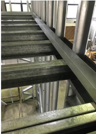
Figura 4 – Vista da estrutura do entrepiso formada por vigas de perfis tipo U enrijecido, guias de perfis tipo U simples (viga de borda) e bloqueadores formados por guias de perfis tipo U simples.
