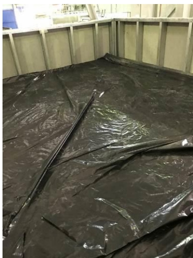
Figura 39 - Colocação da lona de polietileno sobre as placas de fibrocimento.
