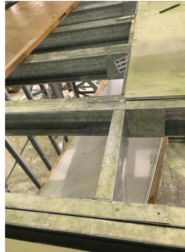
Figura 4 – Vista da estrutura do entrepiso formada por vigas de perfis tipo U enrijecido, guias de perfis tipo U simples (viga de borda) e bloqueadores formados por guias de perfis tipo U simples.
