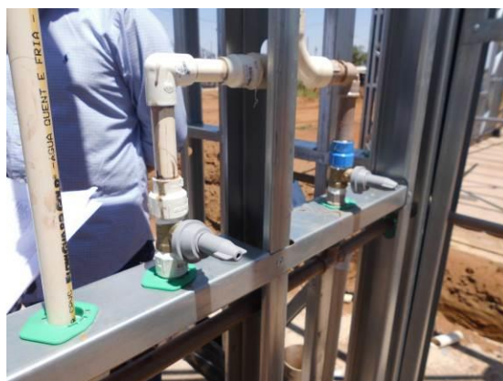
Figura 22 - Arruelas plásticas utilizadas na junção entre instalações hidráulicas e perfis de aço.
