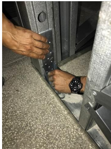
Figura 28 - Suporte de ancoragem posicionado no interior dos quadros estruturais.
