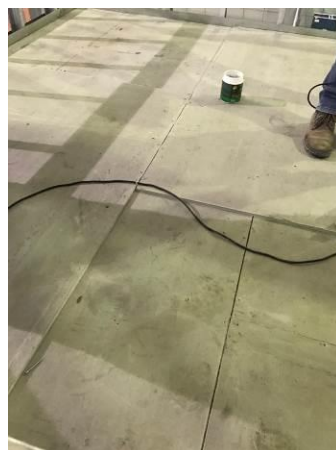
Figura 38 - Fixação da segunda camada de placas de fibrocimento com as juntas desalinhadas.
