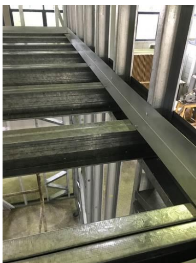
Figura 35 - Cantoneira "L" fixada nos montantes e vigas.
