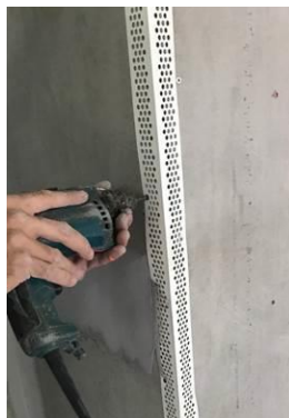
Figura 12 – Fixação da cantoneira de PVC perfurada no canto externo entre placas de fibrocimento.
