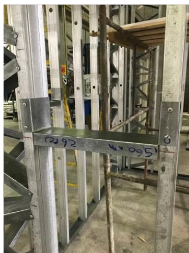
Figura 29 – Bloqueador a meia altura da parede.
