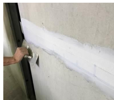
Figura 11 – Aplicação da segunda camada de massa para junta.
