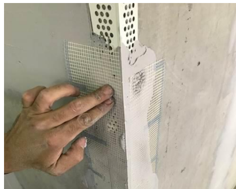
Figura 13 – Aplicação da tela de fibra de vidro e da massa de tratamento de junta, sobre cantoneira de PVC.
