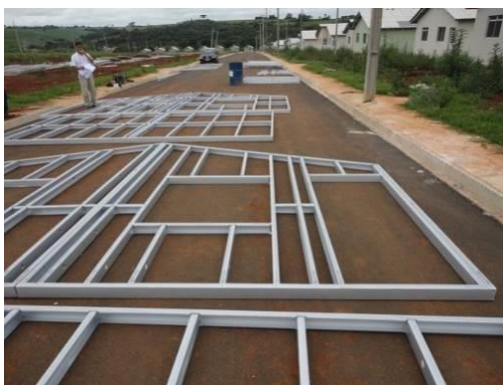
Figura 24 - Montagem dos quadros estruturais fora do seu local definitivo.
