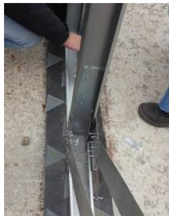
Figura 25 - Fixação dos quadros estruturais à fundação.
