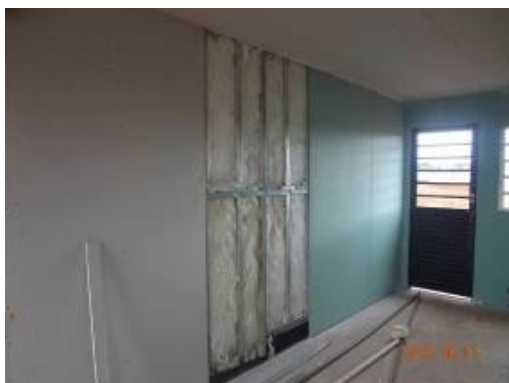
Figura 31 - Manta de lã de vidro no interior da parede.
