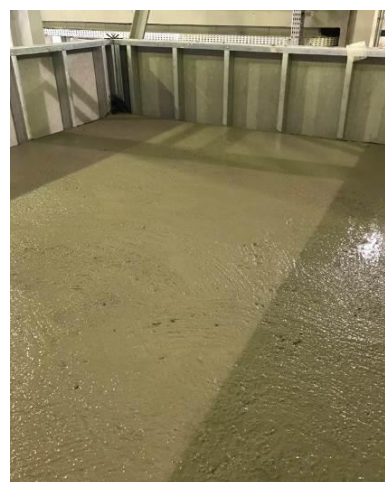
Figura 42 - Entrepiso com camada de contrapiso finalizada.
