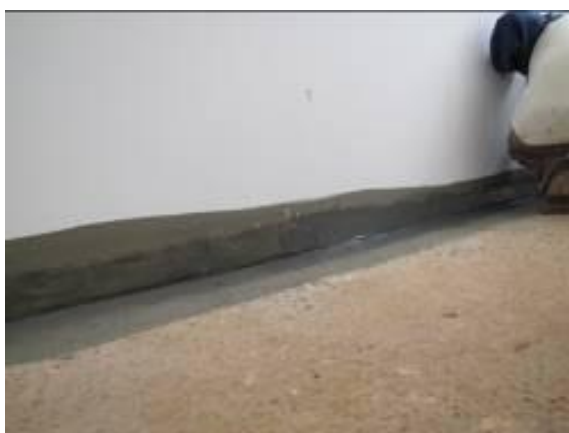
Figura 33 - Impermeabilização da base da parede da cozinha.
