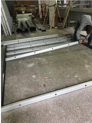
Figura 26 – Fixação dos montantes intermediários.
