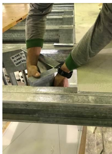
Figura 36 - Fixação dos bloqueadores formados por perfis tipo U simples nas vigas.
