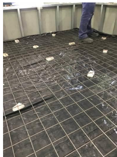
Figura 40 - Colocação da tela de aço e dos espaçadores para garantir o posicionamento e cobertura da tela
