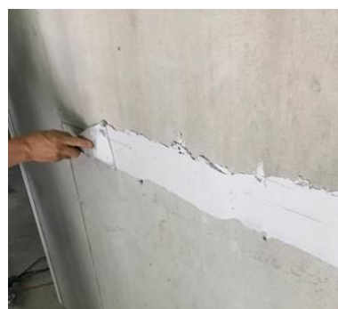
Figura 9 – Aplicação da primeira camada de massa para junta.
