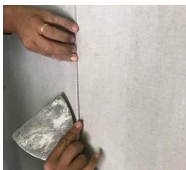
Figura 8 – Colocação do cordão de polietileno expandido (fundo de junta).
