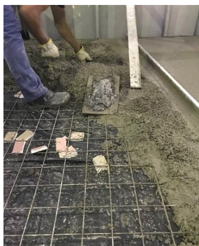
Figura 41 - Lançamento do concreto do contrapiso.
