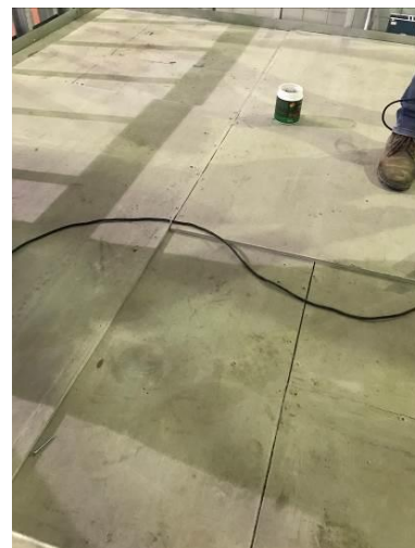
Figura 6 – Vista típica do fechamento superior do entrepiso com 2 camadas de placas de fibrocimento de espessura de 10 mm com juntas desencontradas.
