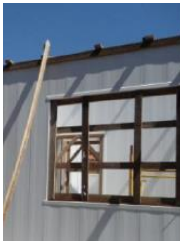
Figura 65 – Exemplo de escoramento dos vãos de janelas.
