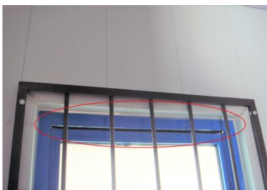
Figura 88 – Vista interna do caixilho do banheiro (área de ventilação permanente = 55 cm²).
