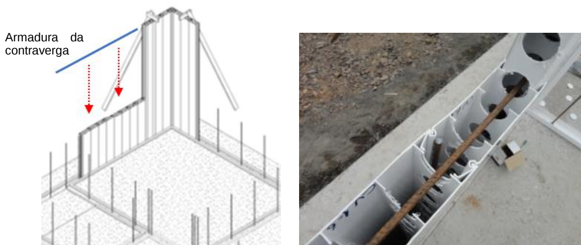
Figura 18 – Posicionamento da barra da armadura horizontal da região da contraverga nos furos das nervuras dos perfis (topo dos peitoris).
