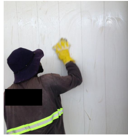
Figura 77 – Limpeza dos perfis de PVC com água e esponja macia após o término da concretagem.
