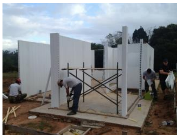
Figura 59 – Início da montagem das paredes externas.
