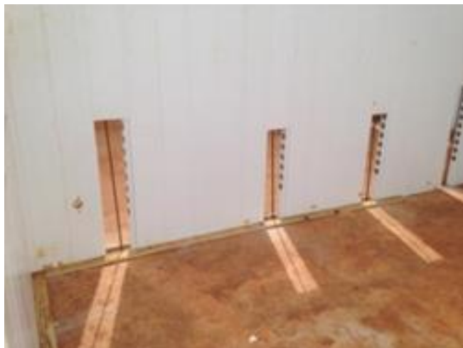
Figura 16 – Imagem da elevação dos perfis “BC200” através para amarração da barra de armadura vertical (a ser inserida) à armadura de ancoragem parede-fundação.
