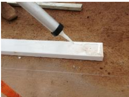
Figura 56 – “Perfil BC 90” (guia de piso) fixado à superfície do elemento de fundação.
