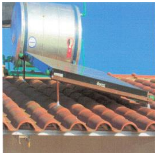
Figura 83 – Exemplo de sistema de aquecimento solar instalado.
