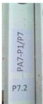
Figura 94 – Exemplo de identificação dos perfis de PVC rígido do Sistema Construtivo Bazze PVC.
