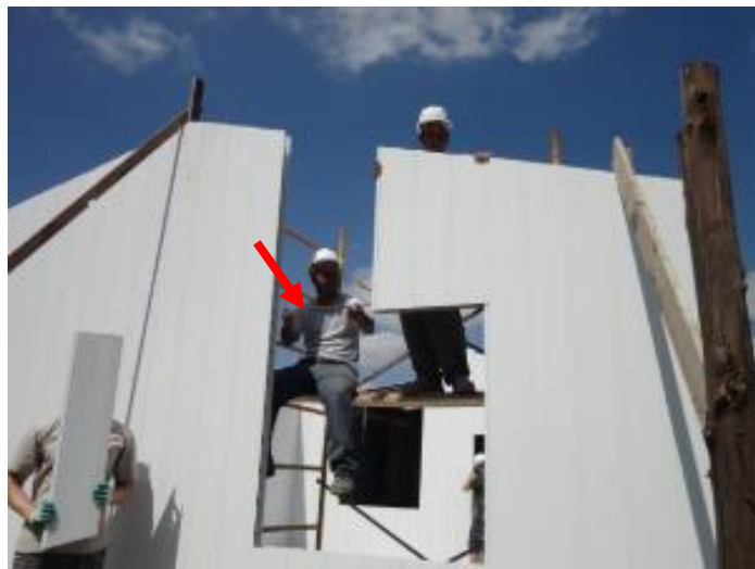
Figura 61 – Inserção da barra de armadura horizontal na região da verga.
