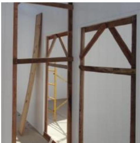
Figura 64 – Exemplo de escoramento dos vãos de portas.
