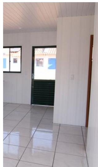
Figura 85 – Revestimento de piso interno instalado.
