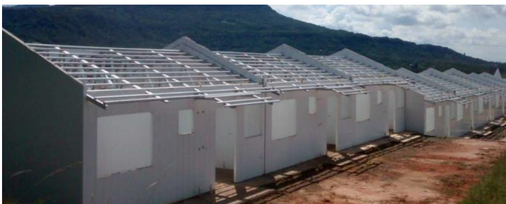
Figura 46 – Execução da estrutura metálica que compõe o sistema de cobertura sobre as paredes que utilizam o Sistema Construtivo Bazze PVC.
