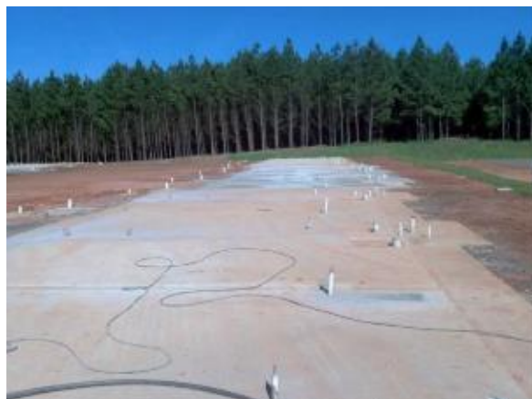
Figura 55 - Fundação das unidades concluída, com as saídas das tubulações conforme projeto.
