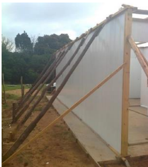
Figura 63 – Exemplo de escoramento das paredes.
