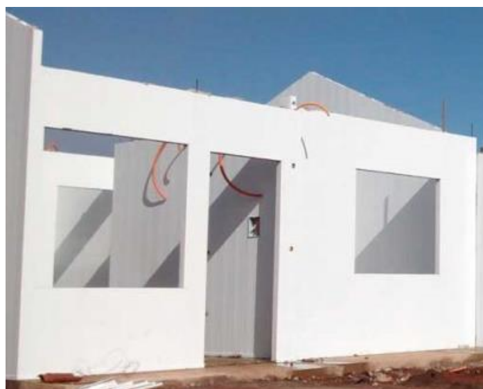
Figura 62 – Unidades habitacionais com as instalações elétricas e hidráulicas embutidas nos painéis de PVC rígido (paredes sem função estrutural no caso das tubulações hidráulicas).
