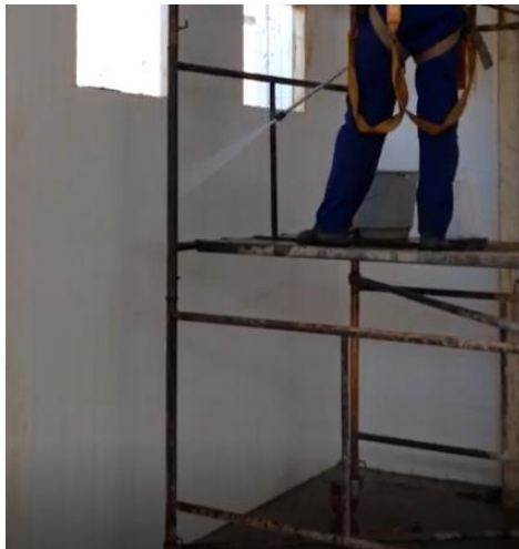
Figura 78 – Limpeza dos perfis de PVC rígido com jato de água após o término da concretagem.
