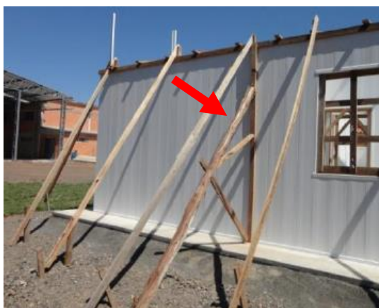
Figura 71 – Exemplo de escoramento no encontro de parede interna perpendicular à fachada.
