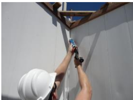
Figura 73 – Preenchimento das juntas entre as paredes perpendiculares com selante poliuretano monocomponente.
