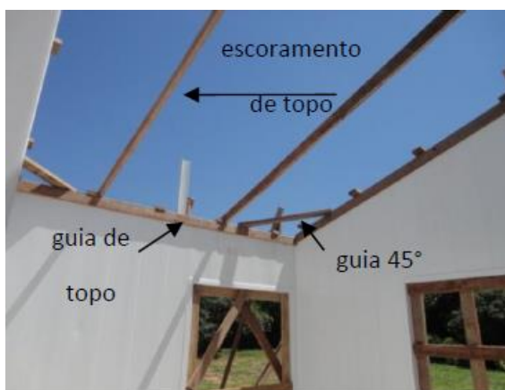
Figura 70 – Exemplo de escoramento de topo.
