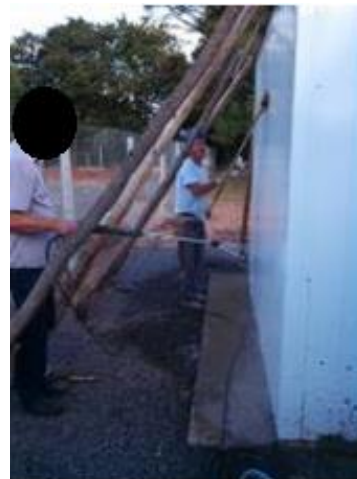
Figura 78 – Limpeza dos perfis de PVC rígido com jato de água após o término da concretagem.
