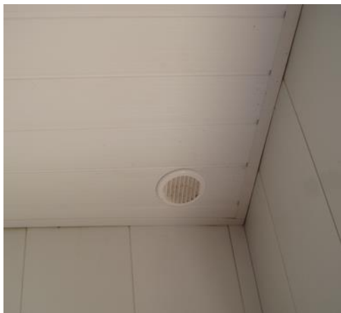
Figura 90 – Elemento de ventilação instalado no forro de PVC dos ambientes (diâmetro = 10 cm).
