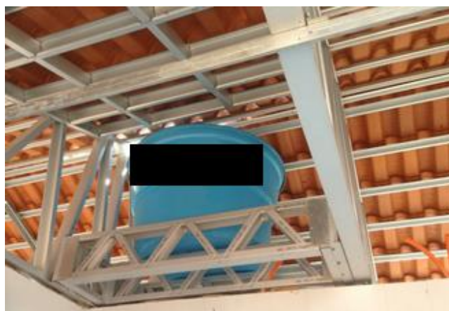
Figura 41 – Exemplo de localização do reservatório para água potável sob a estrutura de cobertura.
