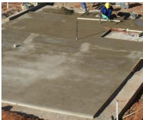
Figura 25 – Imagem da regularização da superfície do elemento de fundação, nesse caso do tipo radier .
