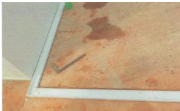
Figura 56 – “Perfil BC 90” (guia de piso) fixado à superfície do elemento de fundação.
