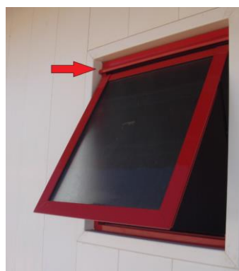
Figura 89 – Vista externa do caixilho do banheiro (área de ventilação permanente = 55 cm²).
