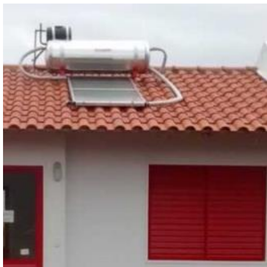
Figura 83 – Exemplo de sistema de aquecimento solar instalado.
