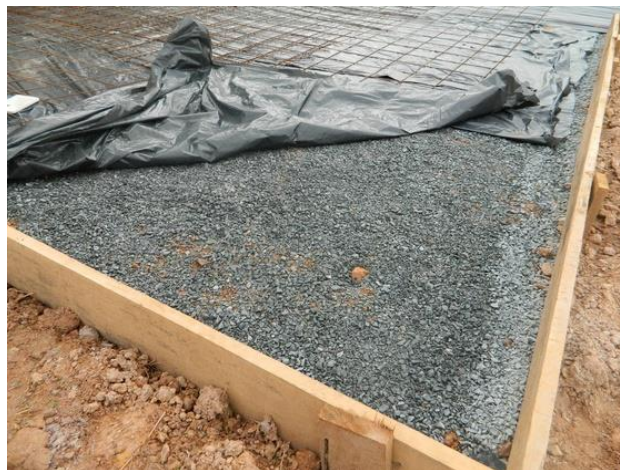
Figura 52 – Lastro de brita nº 1 e colocação de lona entre o solo e o concreto da fundação.
