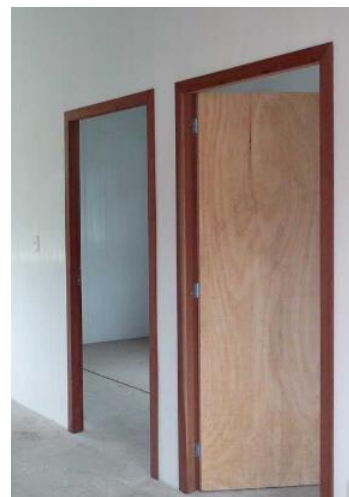
Figura 81 – Esquadrias internas de madeira instaladas.
