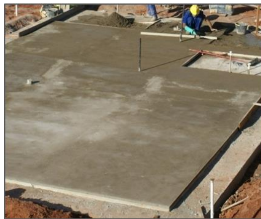
Figura 54 – Execução da fundação tipo radier , com acabamento sarrafeado, rebaxos e caimentos conforme projeto, e planicidade adequada para montagem dos painéis.
