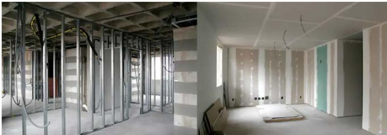
**Figura 1 – Exemplos de sistema de vedação vertical interna em chapas de gesso para *drywall* (fonte: Associação Brasileira do Drywall)**
