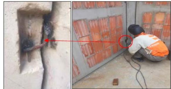
Figura 31 – Vista da ligação do painel, com solda elétrica.
