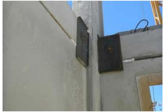
Figura 33 – Solidarização das vigas ao pilar.
