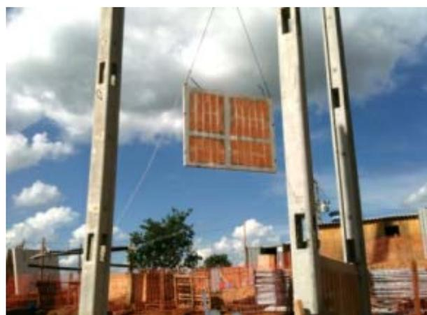
Figura 20 – Montagem dos painéis.
