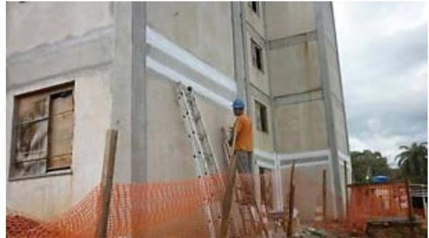
Figura 25 - Membrana acrílica sobre a tela de poliéster.
