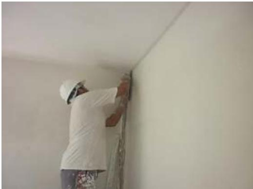
Figura 26 - Aplicação de gesso liso na face interna do painel.
