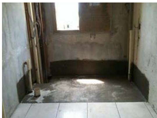
Figura 38 – Impermeabilização laje de concreto e barrado de 300mm na parede.
