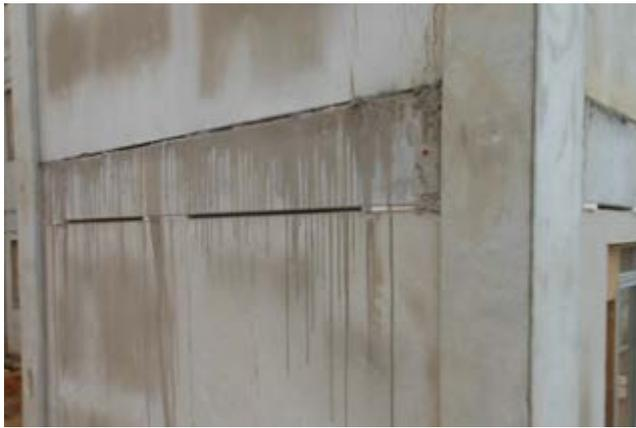
Figura 34 – Montagem final da viga, previamente ao preenchimento do vão.
