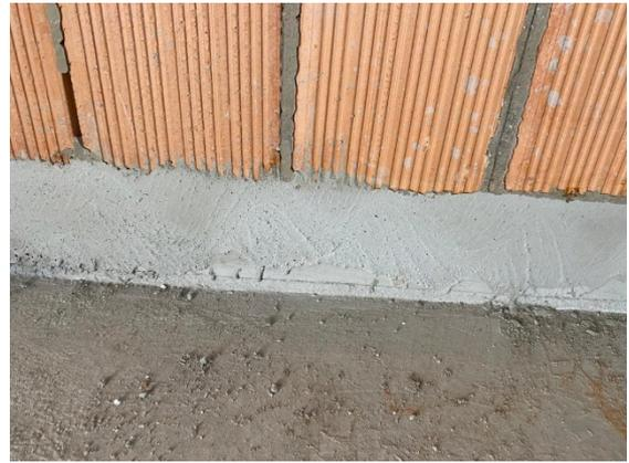
Figura 37 – Preenchimento do vão entre base do painel e laje de piso.
