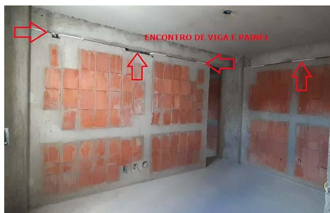
Figura 21 – Posicionamento da placa de EPS sobre a face superior do painel.
