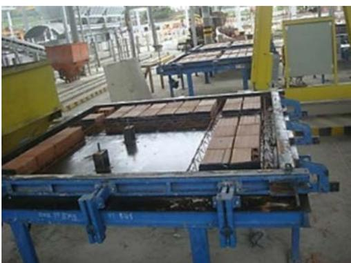
Figura 10 – Distribuição dos blocos cerâmicos.
