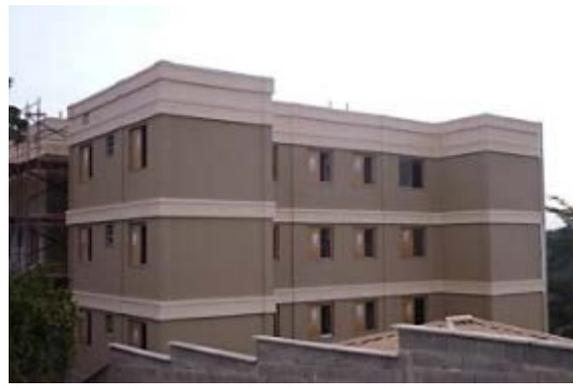
Figura 27 – Aplicação de pintura acrílica texturizada na fachada.
