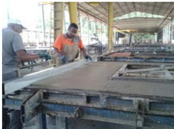
Figura 14 - Regularização com régua metálica.
