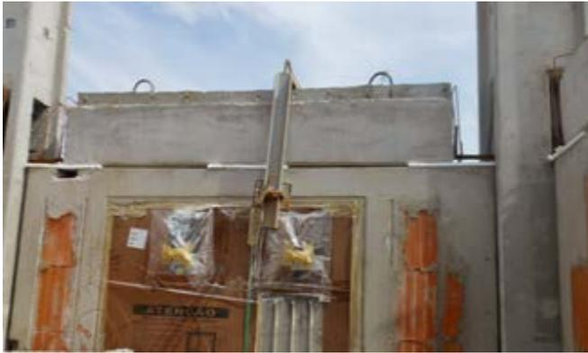
Figura 32 – Montagem da viga sobre as placas de EPS.
