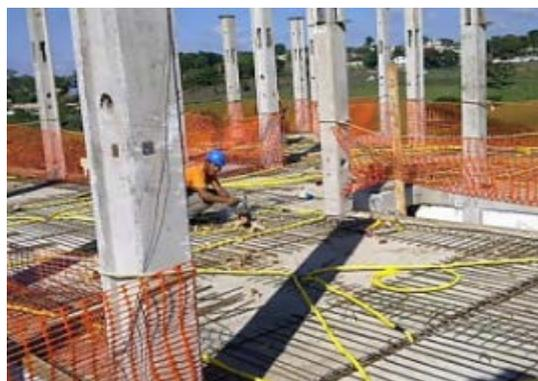
Figura 23 – Distribuição da armadura negativa e eletrodutos
