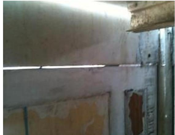
Figura 35 – Vista do vão entre a viga e o painel após a montagem.
