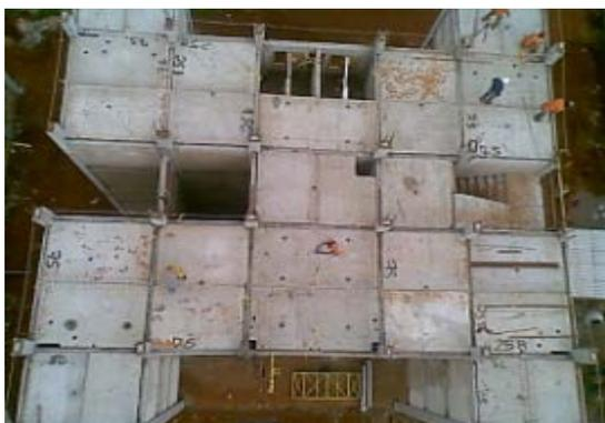
Figura 22 – Montagem das pré-lajes sobre escoramento metálico
