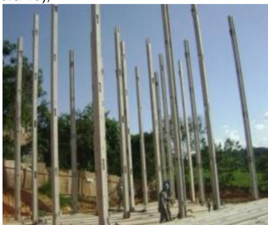
Figura 19 – Montagem dos pilares na fundação.
