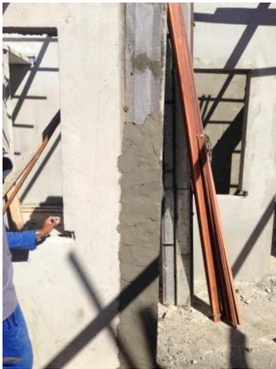
Figura 38 – Aplicação de tela de poliéster e argamassa nas juntas.
