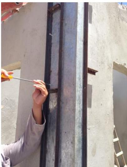
Figura 36 – Preparação da forma metálica para grauteamento.
