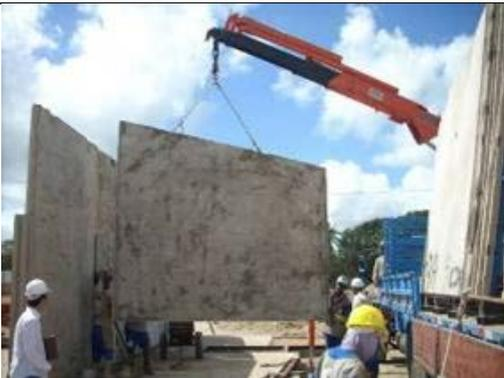
Figura 30– Içamento para transporte do painel.
