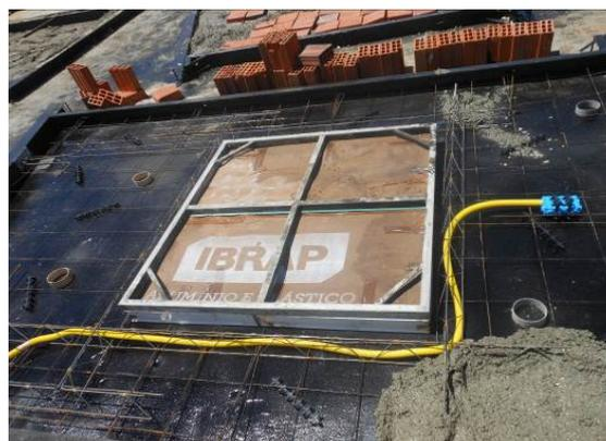
Figura 5 - Detalhes das fôrmas metálicas nos painéis durante procedimento de moldagem.
