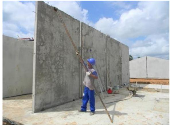
Figura 33 – Detalhe do escoramento do painel.
