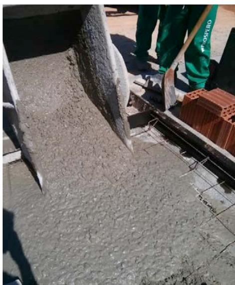
Figura 23 – Lançamento do concreto.
