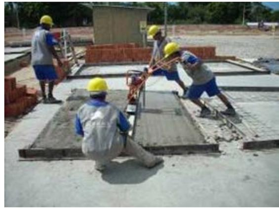
Figura 27 – Vibração da argamassa.
