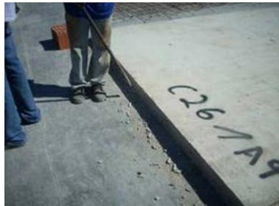
Figura 28– Proteção dos painéis com lona plástica. Figura 29 – Identificação e desenforma dos painéis.
