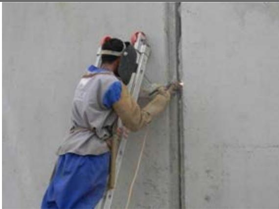
Figura 34 – Soldagem entre painéis.
