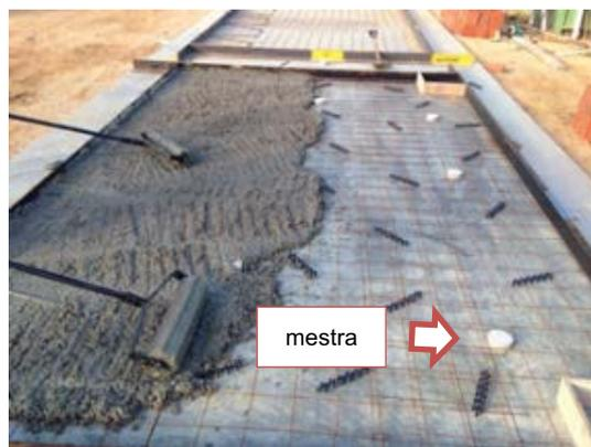
Figura 22 – Detalhes do posicionamento da tela eletrossoldada sobre espaçadores plásticos e das mestras
