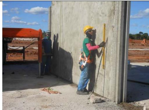
Figura 31 – Montagem do painel no local definitivo.
