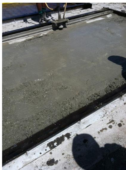
Figura 24 – Adensamento do concreto com régua vibratória.
