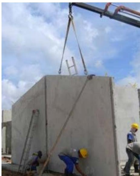
Figura 18 – Posicionamento do painel sobre argamassa.
