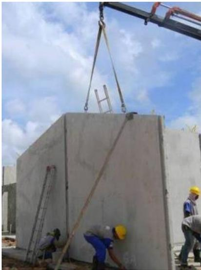
Figura 32 – Detalhe do assentamento da parede.
