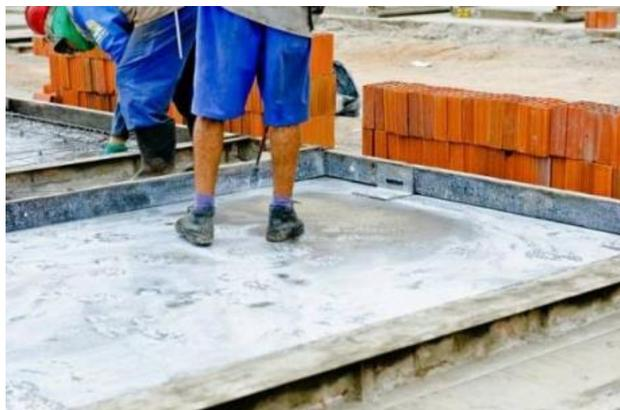
Figura 4 – Aplicação do desmoldante.
