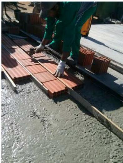
Figura 25 – Distribuição dos blocos cerâmicos.
