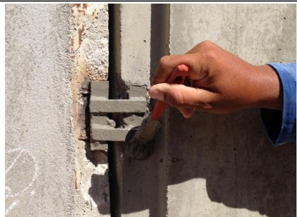
Figura 35 – Detalhe de produto primer epóxi rico em zinco.
