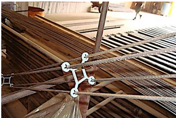
Figura 26 – Fios de aço CA-60 de \varnothing 5 mm e espaçador plástico do tipo estribo.
