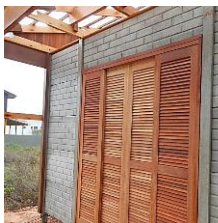
Figura 51 – Porta instalada entre pilares pré-fabricados.
