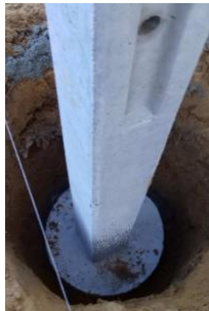
Figura 45 – Pilar apoiado sobre peça circular pré-fabricada de concreto
