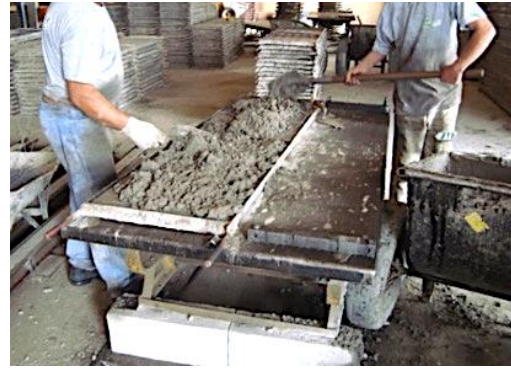
Figura 17 – Lançamento manual da segunda camada de concreto.
