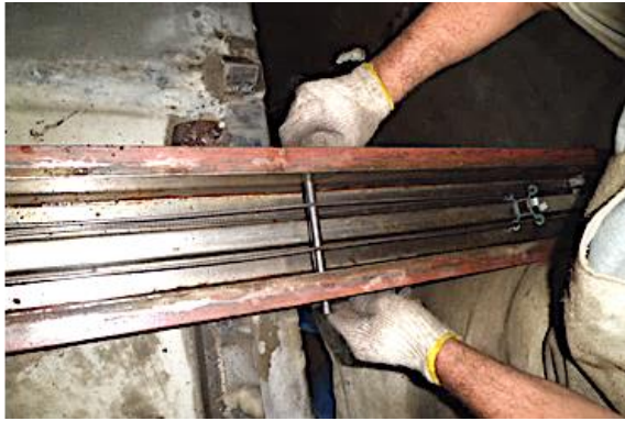
Figura 22 – Fôrma metálica para pilares pré-fabricados em concreto armado.
