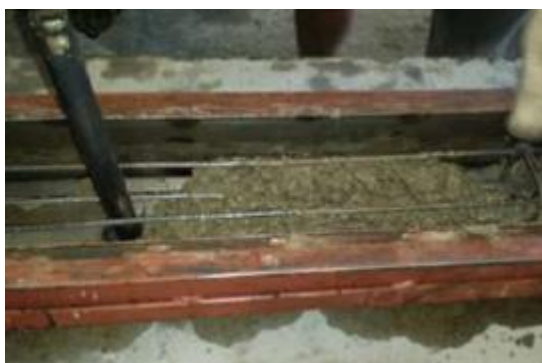
Figura 41 – Lançamento da primeira camada de concreto na forma metálica.
