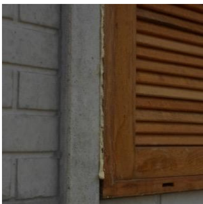
Figura 55 – Vão entre pilar e janela preenchido com espuma expansiva a base de poliuretano.
