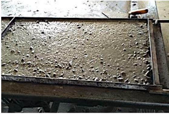
Figura 16 – Forma com a primeira camada de concreto.
