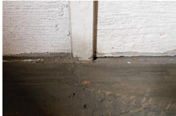
Figura 72 – Vão entre painel de vedação e viga baldrame preenchido com argamassa AC III.
