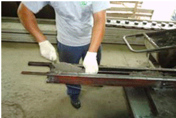
Figura 30 – Lançamento da primeira camada de concreto na forma metálica.
