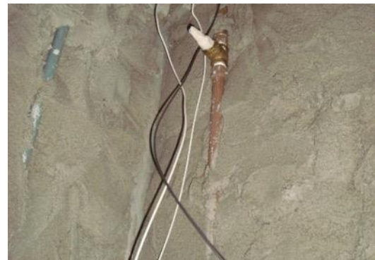
Figura 79 – Execução do embutimento da tubulação de hidráulica no emboço.
