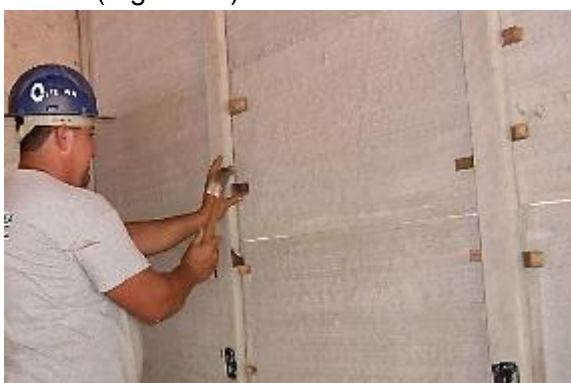
Figura 69– Fixação temporária dos painéis por meio de cunhas de madeira.
