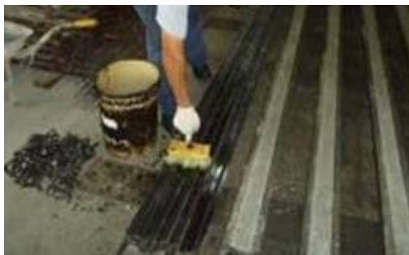
Figura 37 – Aplicação do desmoldante.
