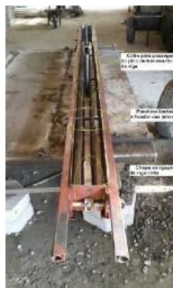
Figura 40 – Posicionamento da armadura na forma metálica.
