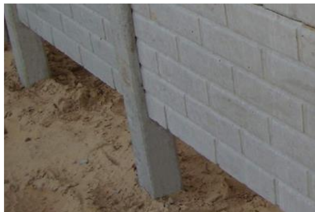
Figura 46 – Pilares pré-fabricados aterrados.
