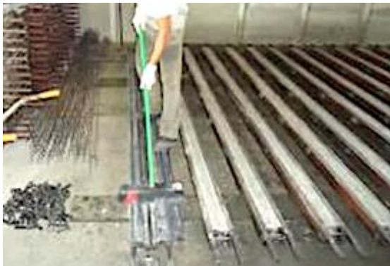
Figura 24 – Limpeza das formas metálicas.
