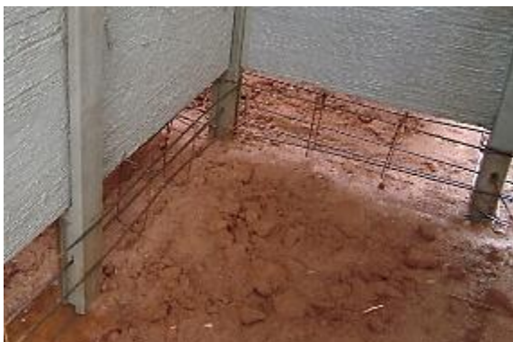
Figura 65 – Armação da viga baldrame.
