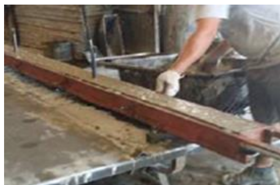
Figura 42 – Lançamento da segunda camada de concreto na forma metálica.
