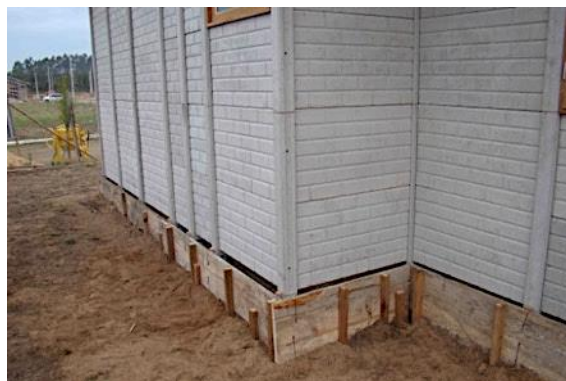
Figura 66 – Fôrmas em madeira para concretagem da viga baldrame.
