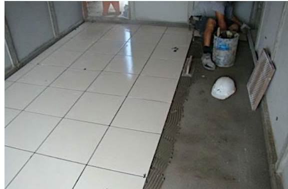
Figura 83 – Assentamento do revestimento cerâmico.
