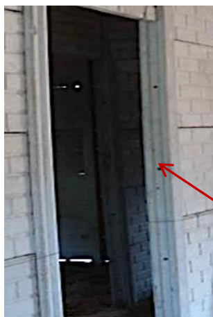
Figura 50 – Orifícios no pilar pré-fabricado para fixação do marco da porta.
