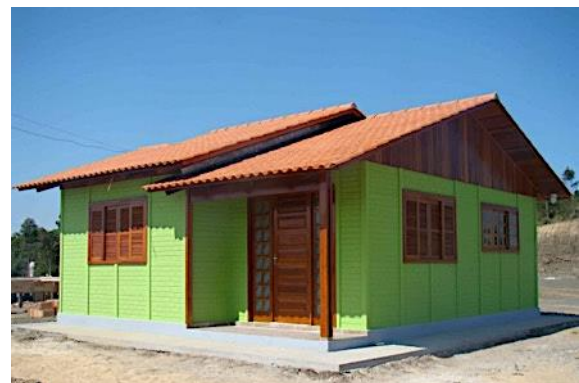
Figura 81 – Acabamento externo dos painéis de vedação em pintura acrílica.
