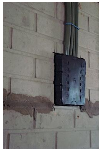
Figura 75 – Caixa de instalações elétricas fixada no painel de vedação.
