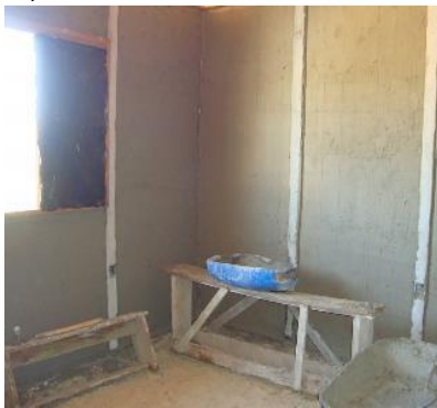
Figura 78 – Chapisco e emboço na face interna dos painéis de vedação.
