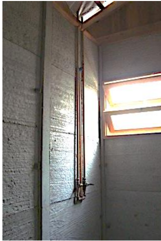
Figura 76 – Tubulação de hidráulica do box fixada externamente ao painel de vedação.
