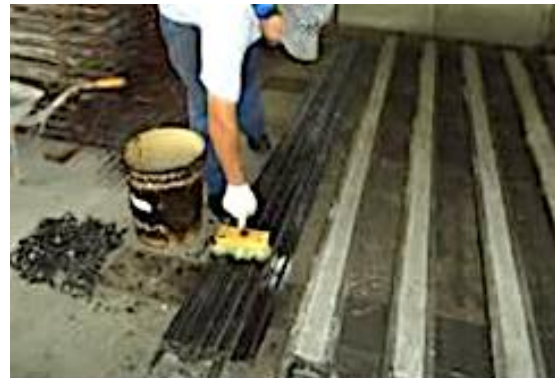
Figura 25 – Aplicação do desmoldante.
