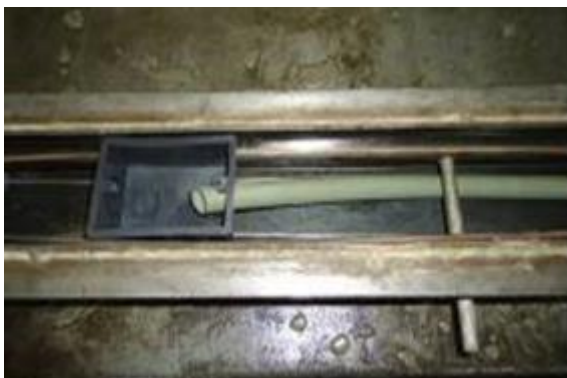
Figura 32 – Posicionamento do conduíte elétrico e caixa de passagem na fôrma metálica.
