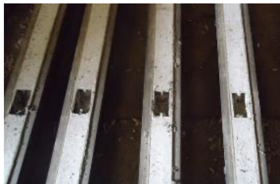
Figura 33 – Pilar concretado com caixa de passagem para instalação elétrica.
