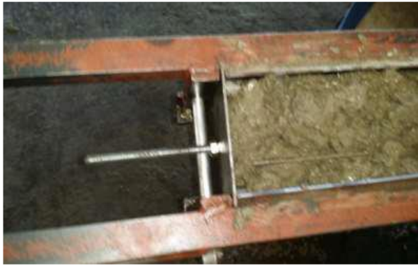
Figura 28 – Parafuso de aço galvanizado posicionado na extremidade superior do pilar.
