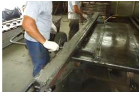
Figura 31 – Lançamento da segunda camada de concreto na forma metálica.
