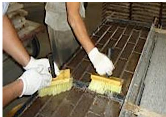
Figura 13 – Aplicação do desmoldante.
