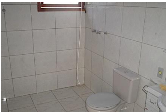
Figura 80 – Banheiro com revestimento interno em cerâmica.
