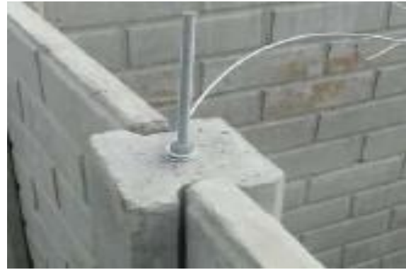
Figura 29 – Parafuso de aço galvanizado no pilar concretado.
