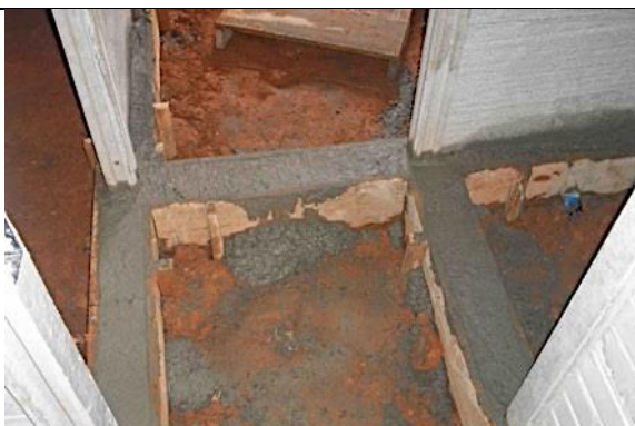
Figura 67 – Concretagem das vigas baldrame.
