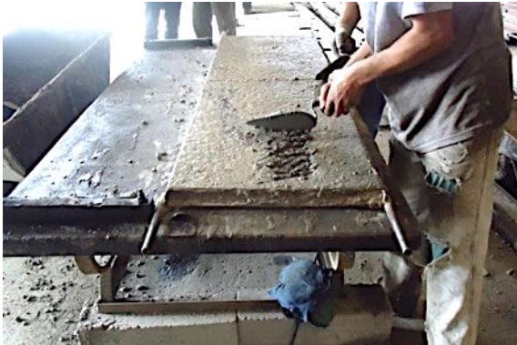
Figura 18 – Painel de vedação após vibração da segunda camada de concreto.
