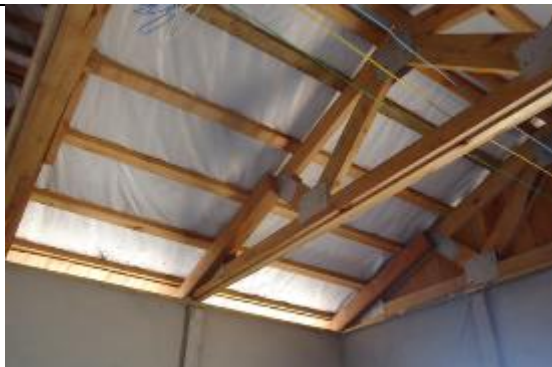
Figura 60 – Sistema de cobertura com estrutura em madeira e manta aluminizada.
