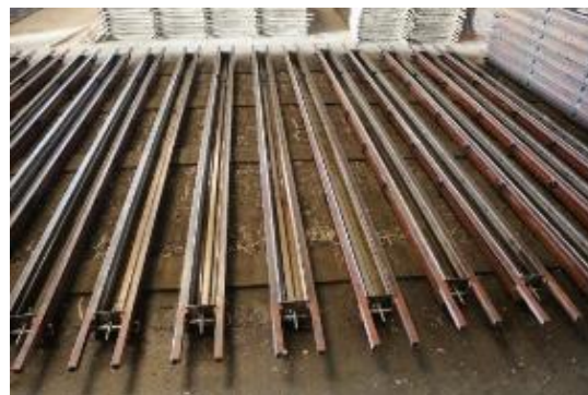
Figura 38 – Fôrmas limpas, montadas e com o desmoldante aplicado.
