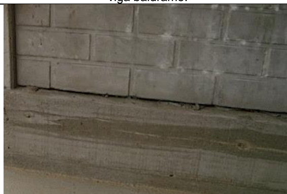
Figura 68 – Viga baldrame após desforma.
