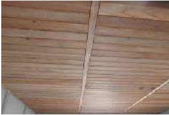
Figura 62 – Forro em réguas de madeira.
