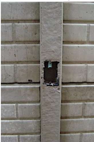
Figura 74 – Eletroduto e caixa de luz embutida no pilar pré-fabricado.
