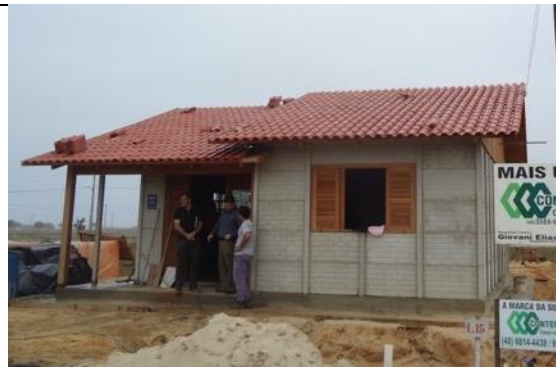
Figura 61 – Sistema de cobertura com telhas cerâmicas.
