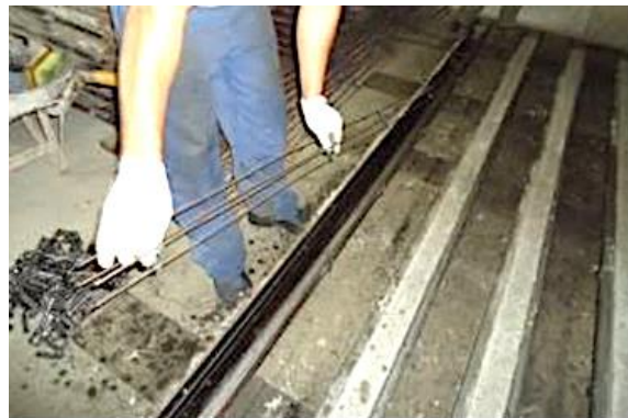
Figura 27 – Posicionamento da armadura na fôrma metálica.
