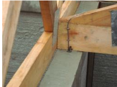
Figura 58 – Fixação do fio de aço galvanizado junto a tesoura do sistema de cobertura.
