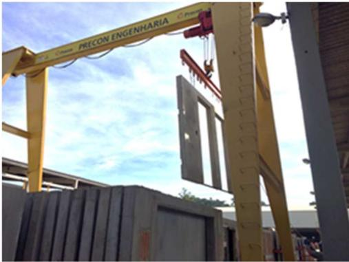
Figura 17 - Movimentação dos painéis para transporte
