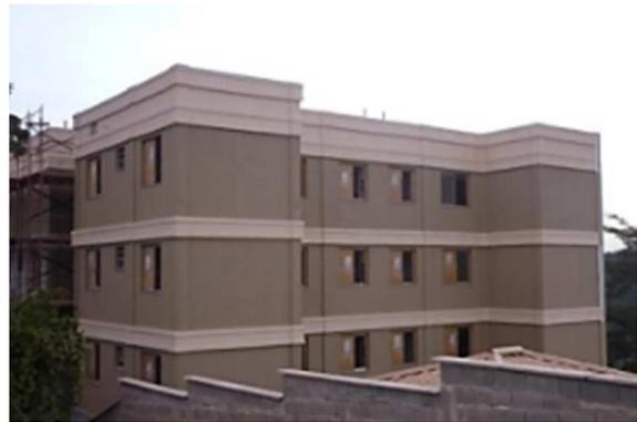
Figura 26 – Aplicação de pintura acrílica texturizada na fachada
