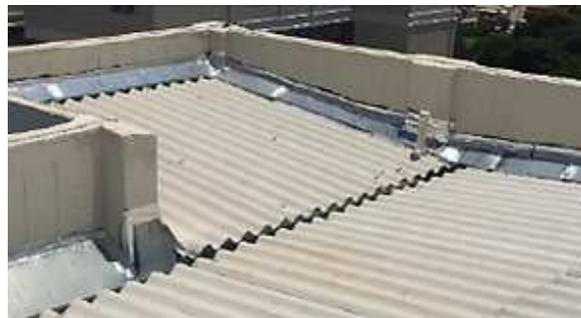
Figura 36 – Impermeabilização na interface dos rufos do telhado
