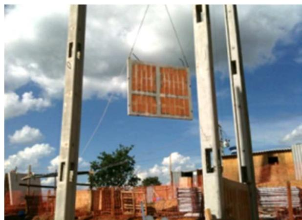
Figura 20 - Montagem dos painéis
