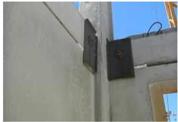
Figura 32 – Solidarização das vigas ao pilar
