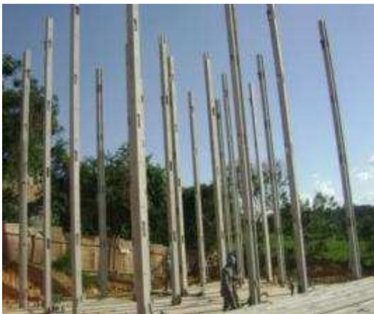
Figura 19 - Montagem dos pilares na fundação
