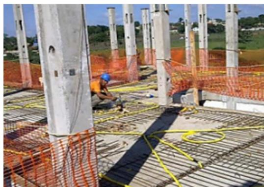
Figura 22 – Distribuição da armadura negativa e eletrodutos
