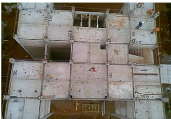
Figura 21 – Montagem das pré-lajes sobre escoramento metálico
