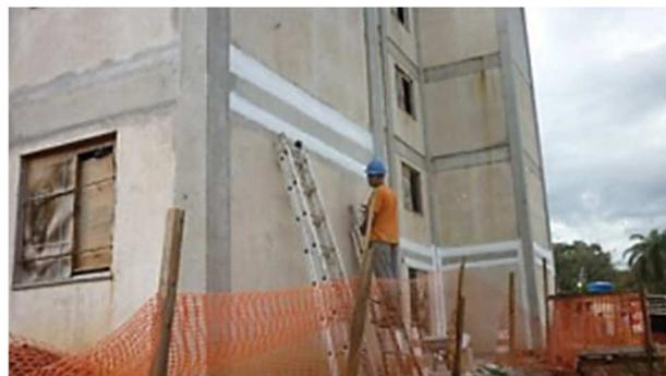
Figura 24 - Membrana acrílica sobre a tela de poliéster
