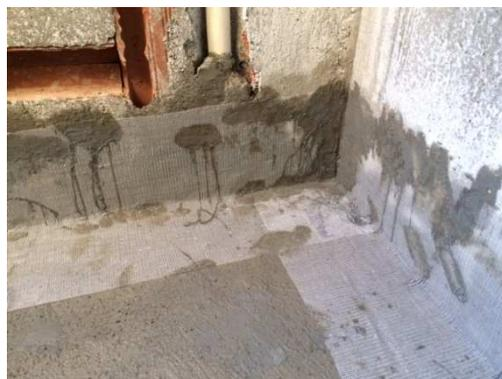
Figura 38 – Aplicação de tela poliéster sobre contrapiso impermeabilizado com argamassa polimérica (1ª demão).
