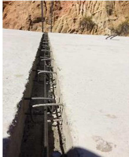
Figura 34 – Detalhes das ligações entre lajes.
