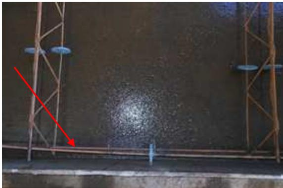
Figura 11 – Posicionamento das barras de aço de reforço na porção inferior do painel.
