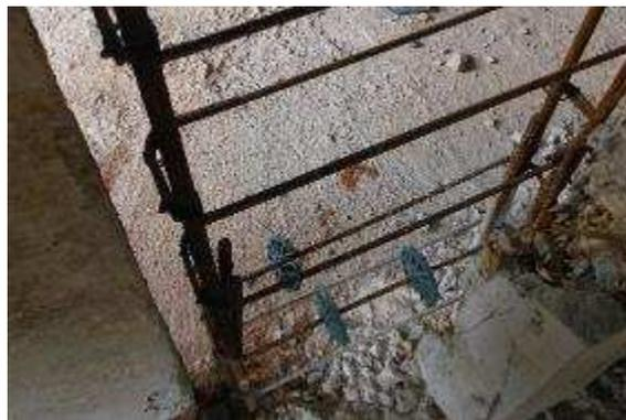
Figura 29 – Posicionamento dos espaçadores pl sticos circulares.
