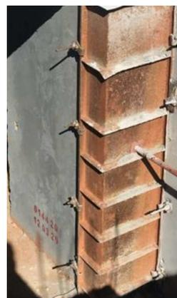
Figura 30 – Fixa o da f rma para concretagem do pilar
