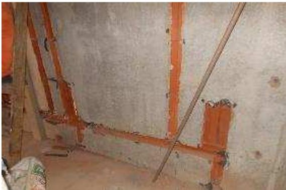
Figura 35 – Remoção dos blocos cerâmicos para a instalação das tubulações de hidráulica.
