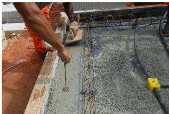
Figura 18 – Conferência da espessura da primeira camada de concreto com o auxílio de galga.
