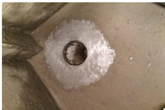
Figura 40 – Tratamento da interface da tubulação de esgoto e contrapiso com aplicação de tela poliéster e argamassa polimérica.
