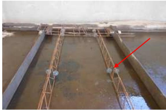
Figura 10 – Posicionamento dos espaçadores plásticos.
