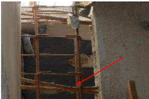
Figura 28 – Ligaç o das esperas da viga junto   armadura do pilar.
