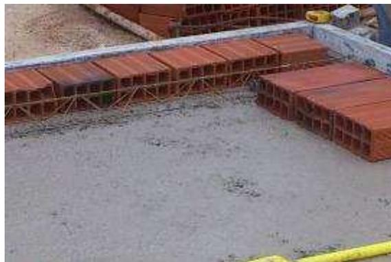
Figura 20 – Posicionamento dos blocos cerâmicos de extremidade com furos no sentido horizontal.
