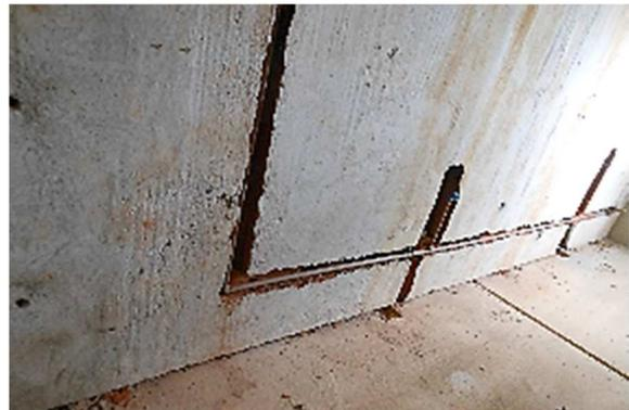
Figura 36 – Instalação das tubulações de hidráulica.
