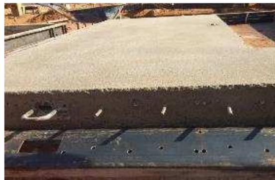
Figura 21 – Detalhe da desenforma da porção superior do painel (pinos de cisalhamento).
