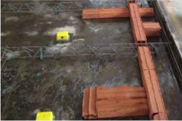
Figura 13 – Posicionamento dos blocos cerâmicos destinados à instalação de tubulações hidráulicas.
