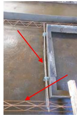
Figura 12 – Posicionamento das barras de aço de reforço na borda inferior do vão de janela e das treliças nas bordas laterais do vão de janela.
