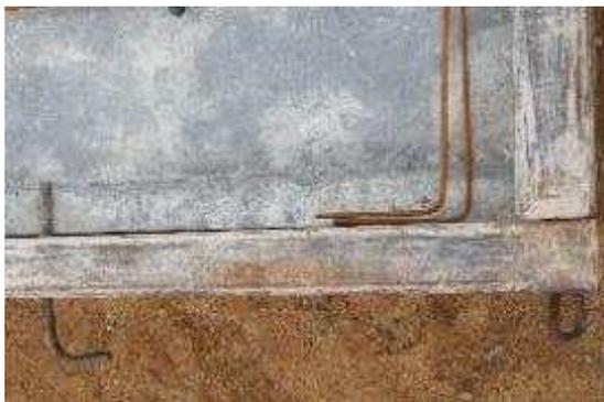
Figura 24 – Fôrmas metálicas acomodadas com auxílio de pinos metálicos.
