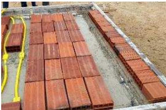
Figura 19 – Posicionamento dos blocos cerâmicos.
