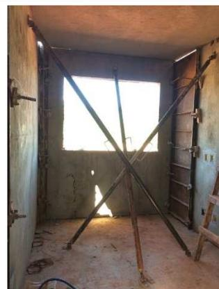
Figura 27 – Painel apoiado sobre barras metálicas com fixação provisória por meio de escoras.
