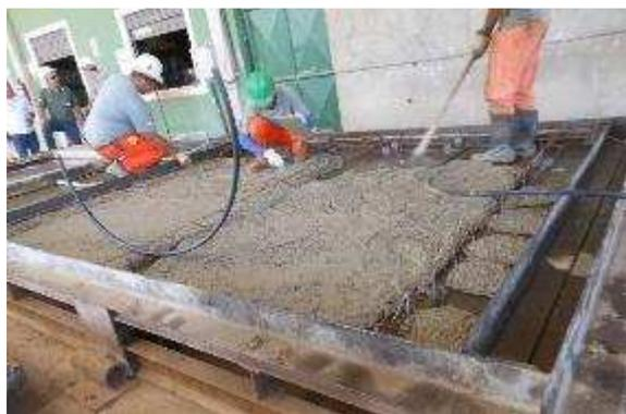
Figura 17 – Lançamento da primeira camada de concreto.
