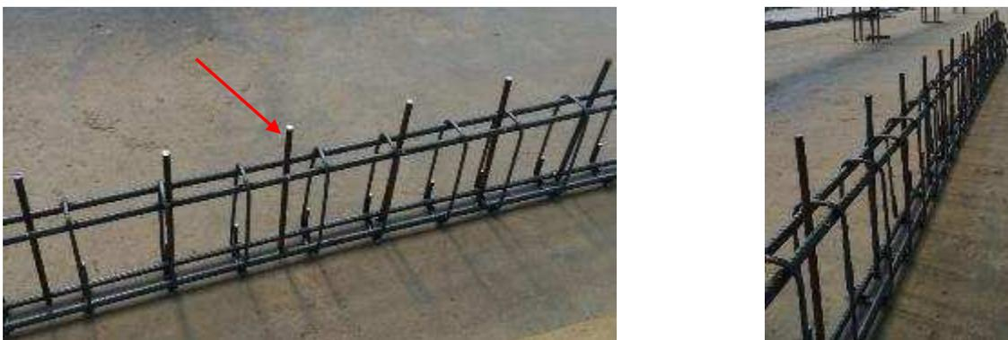
Figura 07 – Armadura da viga com pinos de cisalhamento.
