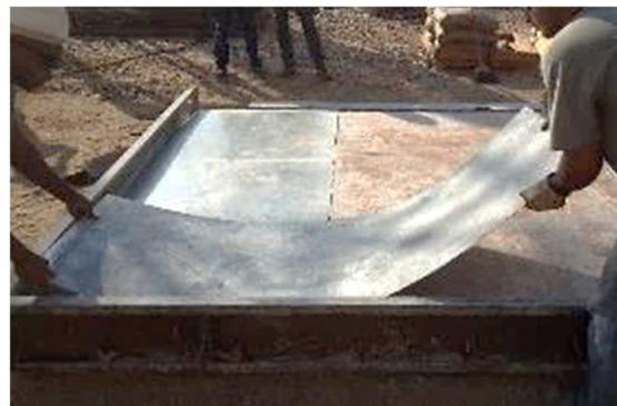
Figura 25 – Posicionamento das chapas de aço galvanizadas.
