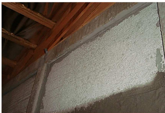
Figura 71 – Vão entre painel de vedação e viga de concreto preenchido com argamassa AC III.
