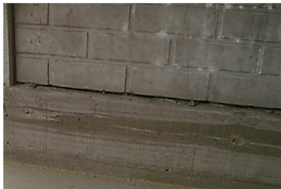
Figura 68 – Viga baldrame após desenforma.
