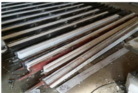
Figura 35 – Desenforma dos pilares em concreto armado.
