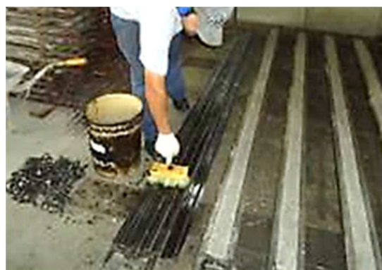
Figura 26 – Aplicação do desmoldante.
