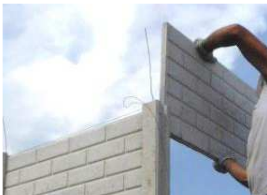
Figura 49 – Painéis sobrepostos.
