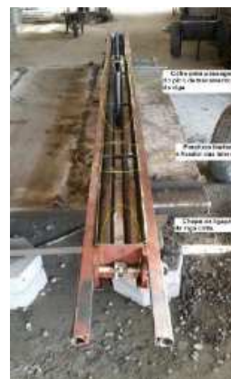
Figura 41 – Posicionamento da armadura na forma metálica.
