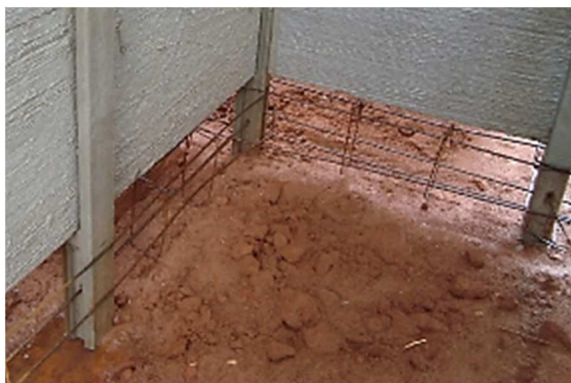
Figura 65 – Armação da viga baldrame.
