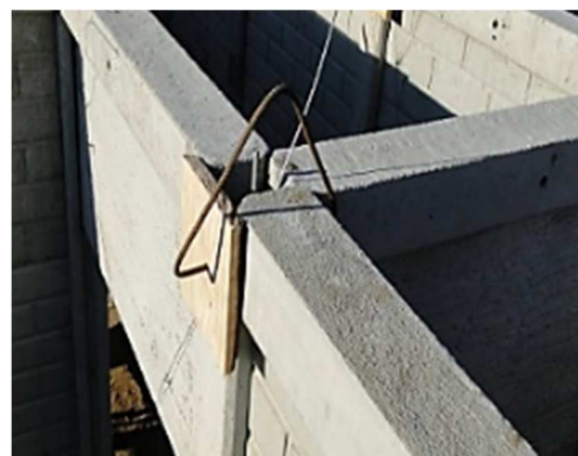
Figura 08 – Detalhe – vão entre pilar e vigas posteriormente concretado.
