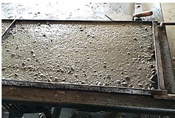
Figura 17 – Forma com a primeira camada de concreto.
