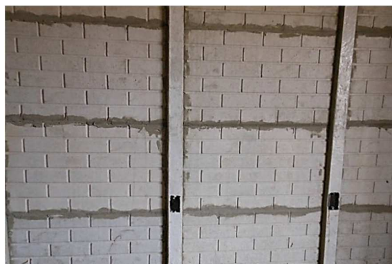
Figura 70 – Rejunte em argamassa AC III entre painéis e entre painéis e pilares.
