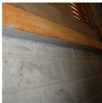
Figura 57 – Acabamento da interface entre painel e janela com selante elástico a base de poliuretano.
