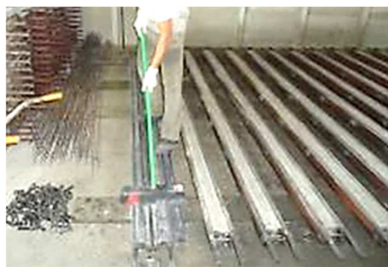
Figura 25 – Limpeza das formas metálicas.
