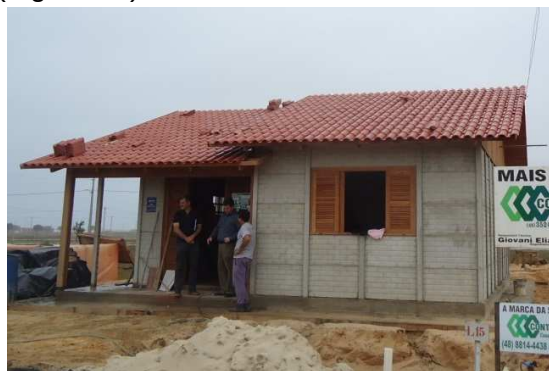
Figura 61 – Sistema de cobertura com telhas cerâmicas.
