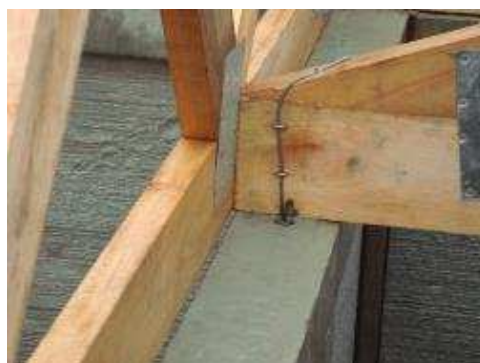
Figura 59 – Fixação do fio de aço galvanizado junto a tesoura do sistema de cobertura.
