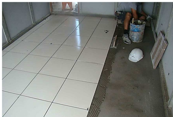
Figura 83 – Assentamento do revestimento cerâmico.
