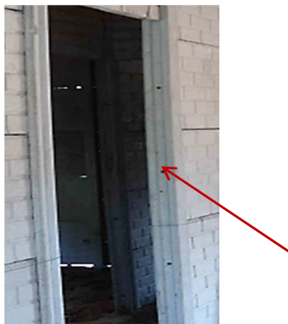
Figura 51 – Orifícios no pilar pré-fabricado para fixação do marco da porta.
