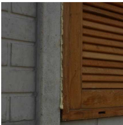
Figura 56 – Vão entre pilar e janela preenchido com espuma expansiva a base de poliuretano.
