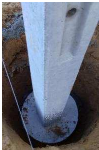
Figura 46 – Pilar apoiado sobre peça circular pré-fabricada de concreto
