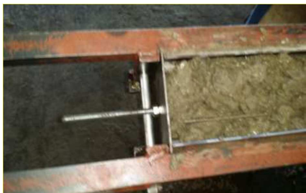
Figura 29 – Parafuso de aço galvanizado posicionado na extremidade superior do pilar.
