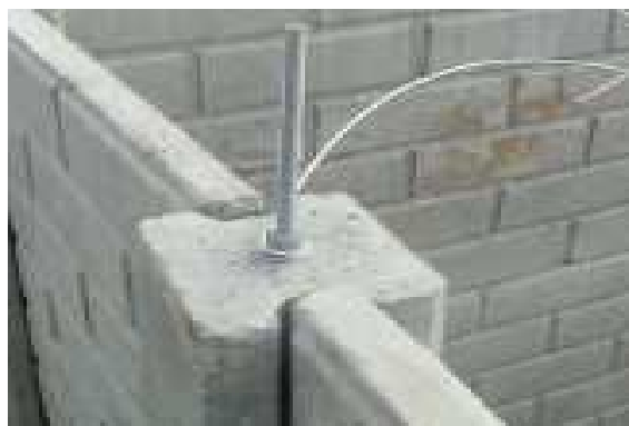
Figura 30 – Parafuso de aço galvanizado no pilar concretado.
