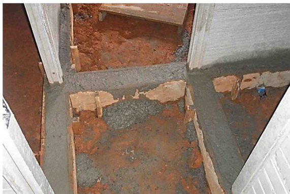
Figura 67 – Concretagem das vigas baldrame.
