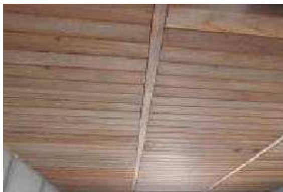
Figura 62 – Forro em réguas de madeira.
