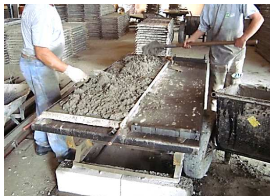
Figura 18 – Lançamento manual da segunda camada de concreto.
