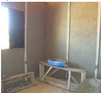
Figura 78 – Chapisco e emboço na face interna dos painéis de vedação.
