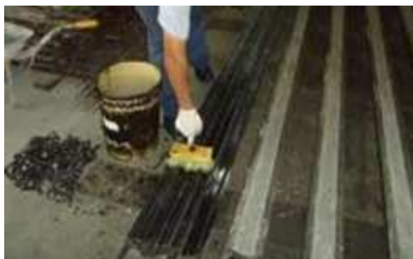
Figura 38 – Aplicação do desmoldante.
