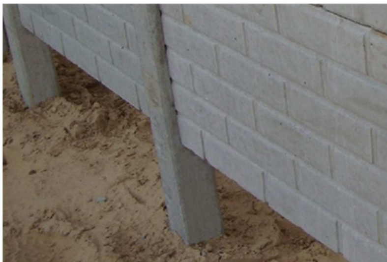
Figura 47 – Pilares pré-fabricados aterrados.
