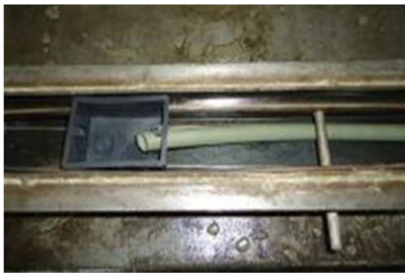
Figura 33 – Posicionamento do conduíte elétrico e caixa de passagem na forma metálica.
