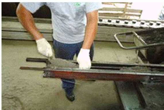
Figura 31 – Lançamento da primeira camada de concreto na forma metálica.
