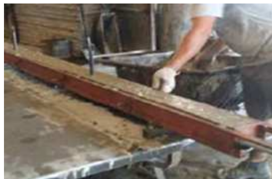
Figura 43 – Lançamento da segunda camada de concreto na forma metálica.
