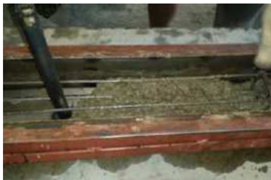
Figura 42 – Lançamento da primeira camada de concreto na forma metálica.
