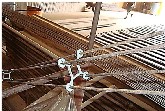
Figura 27 – Fios de aço CA-60 de Ø 5mm e espaçador plástico do tipo estribo.
