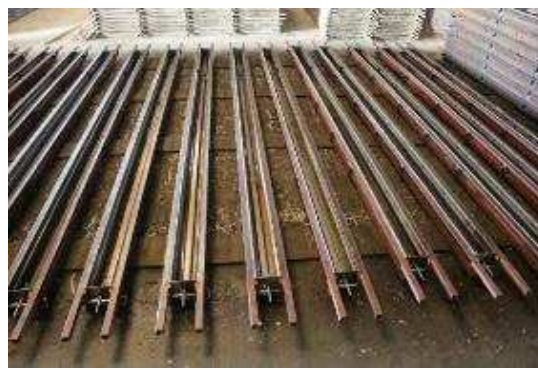
Figura 39 – Formas limpas, montadas e com o desmoldante aplicado.
