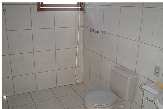
Figura 80 – Banheiro com revestimento interno em cerâmica.
