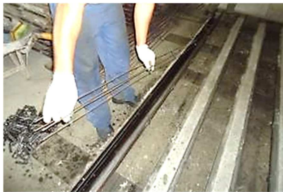
Figura 28 – Posicionamento da armadura na forma metálica.
