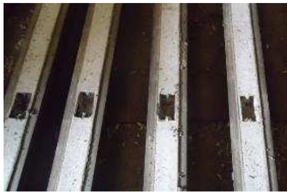
Figura 34 – Pilar concretado com caixa de passagem para instalação elétrica.
