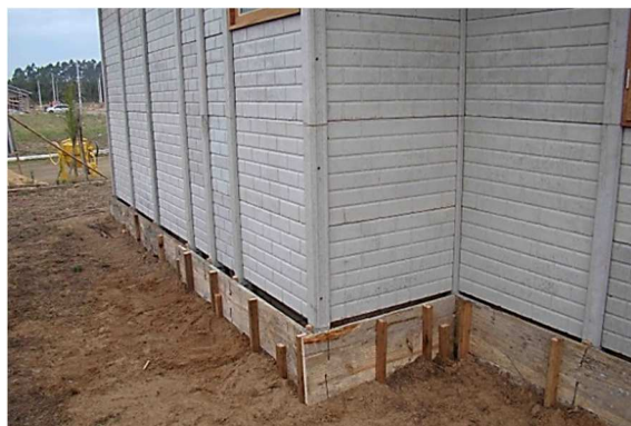
Figura 66 – Formas em madeira para concretagem da viga baldrame.
