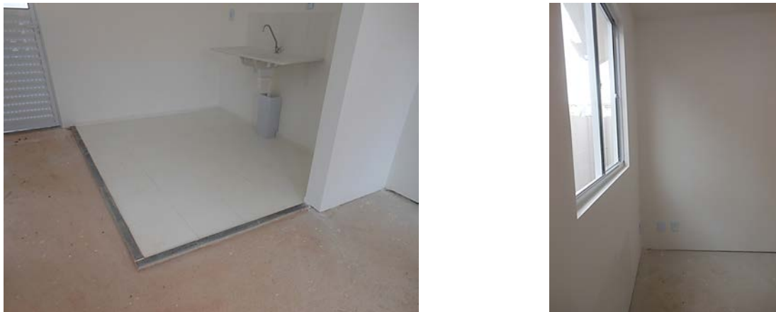
Figura 12 – Interface entre quadros estruturais e piso das áreas secas.
