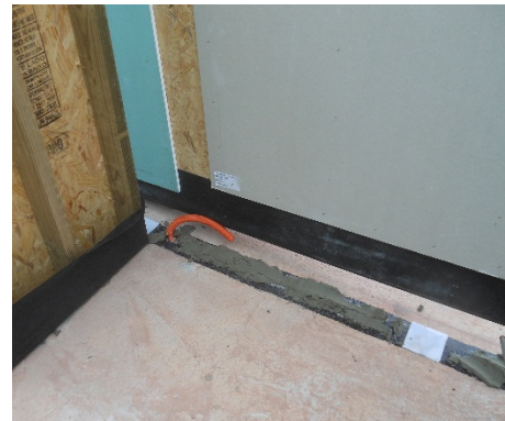
Figura 09 – Niveladores plásticos e argamassa.
