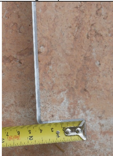
Figura 27 – Fixação do quadro estrutural de entepiso na fundação.
