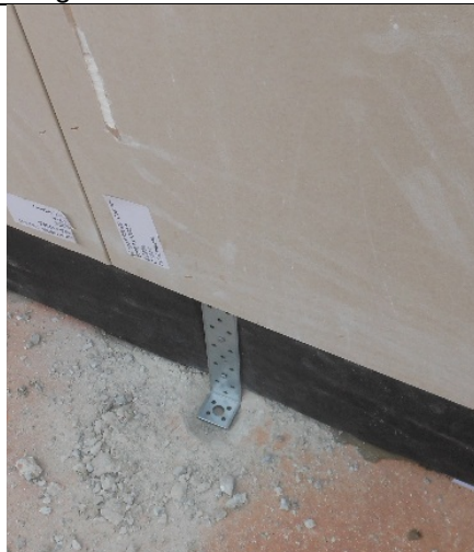
Figura 27 – Fixação do quadro estrutural de entepiso na fundação.
