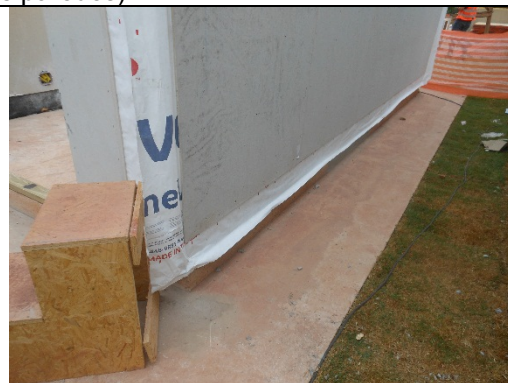
Figura 26 – Detalhe da barreira impermeável a água e permeável ao vapor sob a placa cimentícia.
