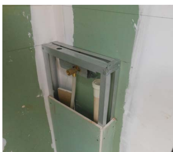
Figura 23 – Detalhe das tubulações sanitárias.
