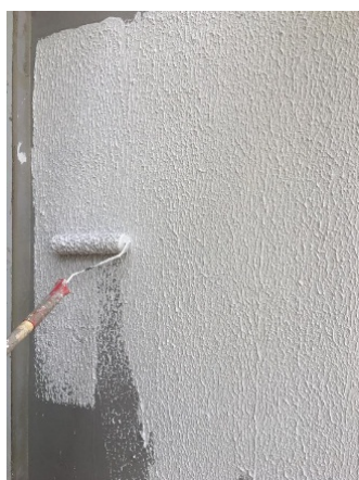
Figura 32 – Pintura texturizada acrílica sobre selante acrílico.
