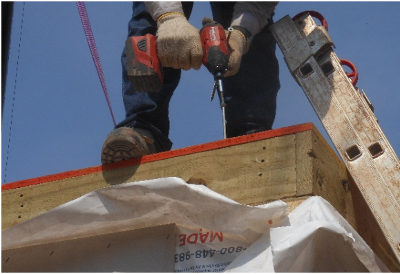
Figura 28 – Fixação do entrepiso sobre paredes do pavimento inferior – sobrado.
