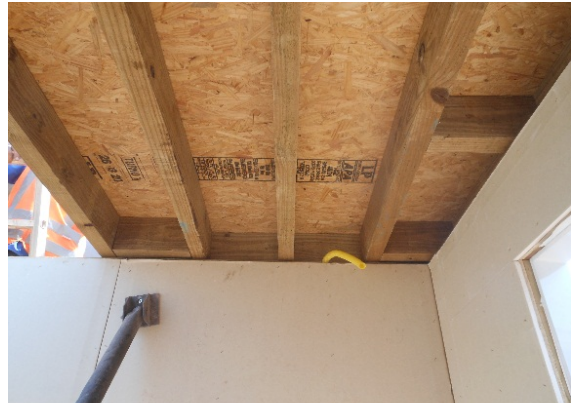
Figura 28 – Fixação do entrepiso sobre paredes do pavimento inferior – sobrado.
