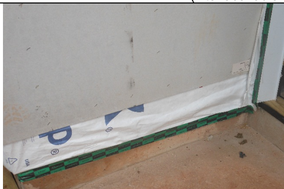
Figura 26 – Detalhe da barreira impermeável a água e permeável ao vapor sob a placa cimentícia.
