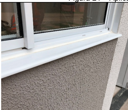
Figura 22 - Detalhe das esquadrias metálicas (peitoral e selagem em PU).
