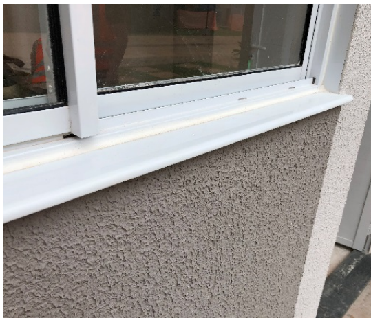
Figura 30 - Detalhe das esquadrias metálicas (peitoril e selagem em PU).
