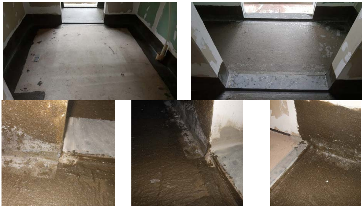
Figura 06– Impermeabilização da cozinha e área de serviço com argamassa polimérica flexível de base acrílica (sobrado).
