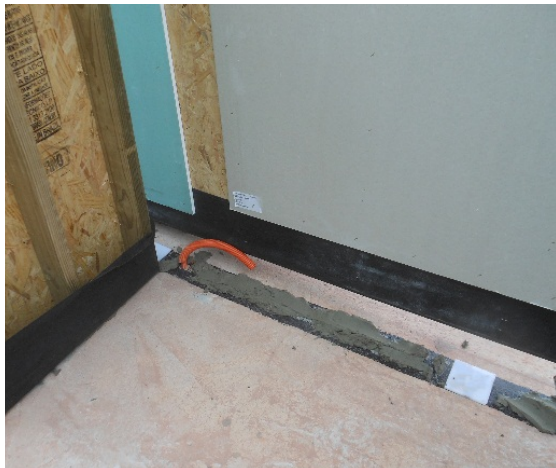
Figura 25 – Posicionamento dos painéis sobre impermeabilizante de base betuminosa e niveladores (interface radier e base das paredes).
