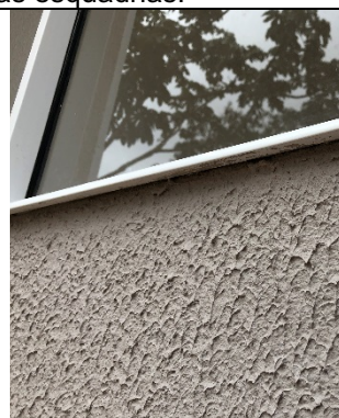
Figura 22 - Detalhe das esquadrias metálicas (peitoral e selagem em PU).
