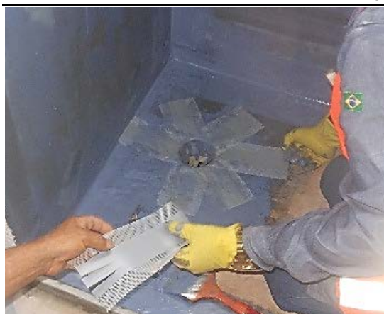
Figura 15 – Aplicação de telas de reforço na região do ralo.
