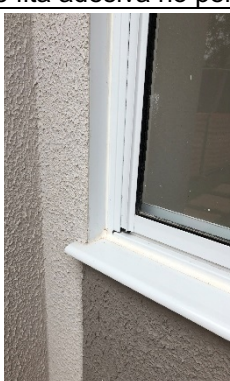
Figura 22 - Detalhe das esquadrias metálicas (peitoral e selagem em PU).
