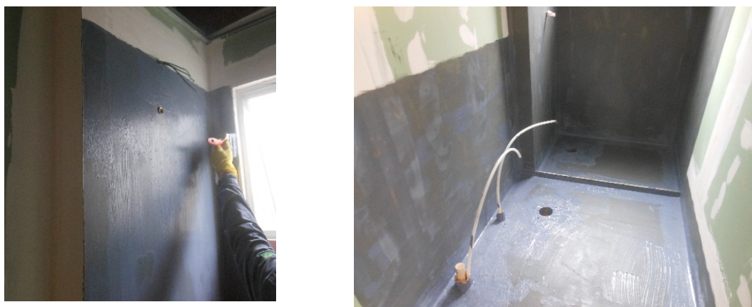
Figura 05– Aplicação da membrana impermeável nas paredes e piso do banheiro (sobrado).
