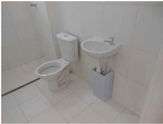
Figura 24 – Banheiro - Tubulação hidráulica externa, shaft e chapa de gesso para drywall tipo RU.
