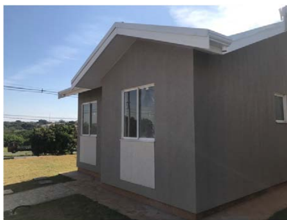
Figura 32 – Pintura texturizada acrílica sobre selante acrílico.
