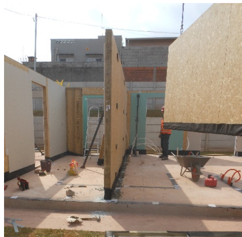
Figura 25 – Posicionamento dos painéis sobre impermeabilizante de base betuminosa e niveladores (interface radier e base das paredes).
