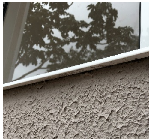
Figura 30 - Detalhe das esquadrias metálicas (peitoril e selagem em PU).
