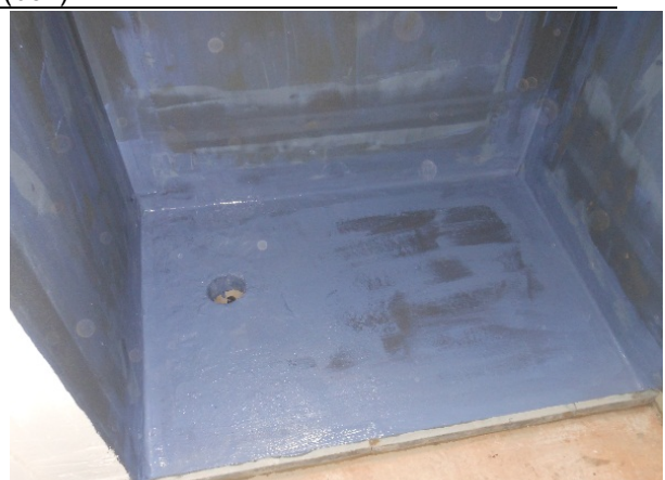
Figura 16 – Aplicação de manta líquida de copolímero acrílica – região do box.
