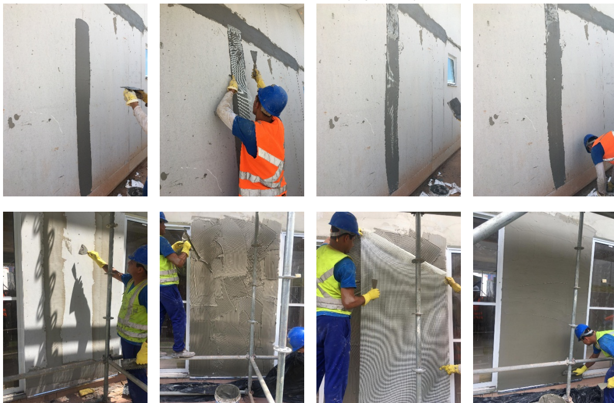
Figura 07 – Tratamento das juntas entre placas cimentícias e tratamento da fachada.
