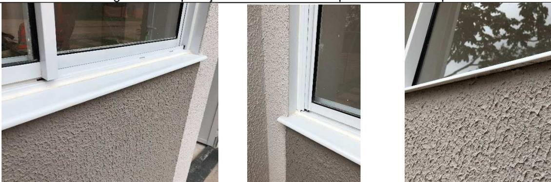
Figura 22 - Detalhe das esquadrias metálicas (peitoral e selagem em PU).
