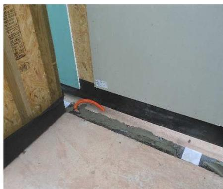
Figura 09 – Niveladores plásticos e argamassa.
