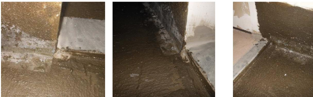
Figura 06– Impermeabilização da cozinha e área de serviço com argamassa polimérica flexível de base acrílica (sobrado).
