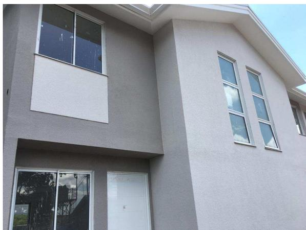
Figura 32 – Pintura texturizada acrílica sobre selante acrílico.
