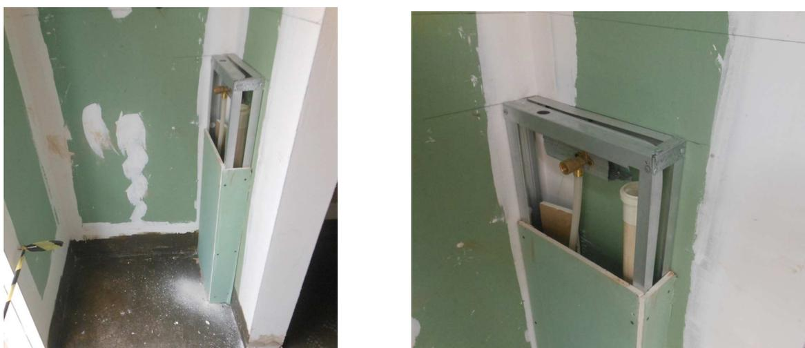
Figura 23 – Detalhe das tubulações sanitárias.
