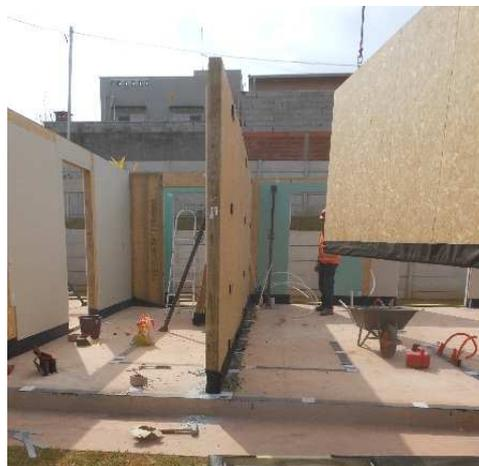
Figura 25 – Posicionamento dos painéis sobre impermeabilizante de base betuminosa e niveladores (interface radier e base das paredes).
