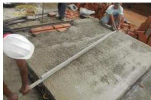
Figura 12 – Sarrafeamento da segunda camada de concreto.
