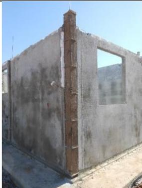
Figura 27 – Fôrma para concretagem entre painéis.
