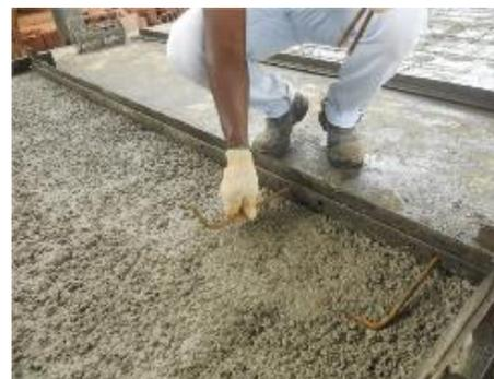
Figura 07 – Posicionamento das barras de soldagem.
