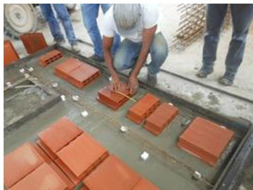
Figura 09 – Posicionamento das lajotas cerâmicas.
