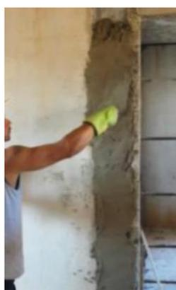
Figura 29 – Acabamento em camada de argamassa de revestimento.
