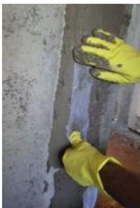
Figura 28 – Fixação da tela de poliéster sobre argamassa colante tipo ACI.
