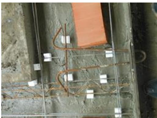
Figura 08 – Posicionamento das alças de içamento.
