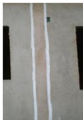
Figura 30 – Aplicação de emulsão acrílica na região de juntas entre painéis.
