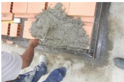
Figura 11 – Lançamento da segunda camada de concreto.
