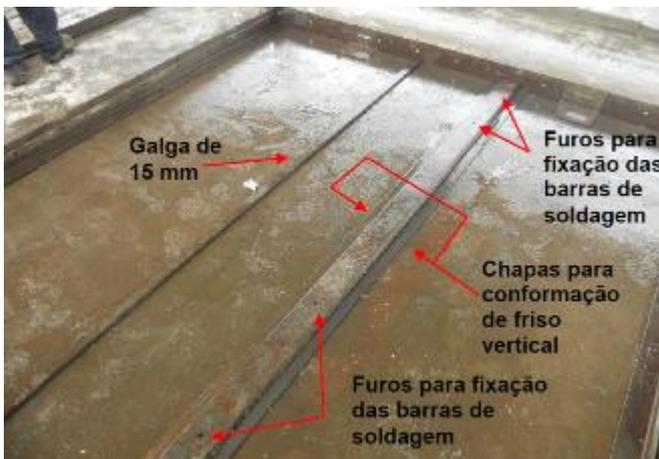
Figura 04 – Posicionamento da galga e do conjunto formado por chapas metálicas retas e chapas metálicas dobradas e chapas metálicas para conformação dos frisos verticais.
