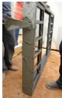
Figura 33 – Aplicação de argamassa colante no marco da janela de aço.
