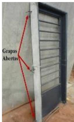
Figura 32 – Marco de porta de aço preenchido com argamassa e grapas para fixação no painel de parede.
