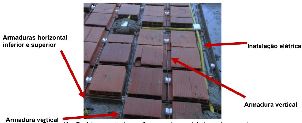
Figura 10 – Posicionamento das malhas superiores e inferiores das armaduras.
