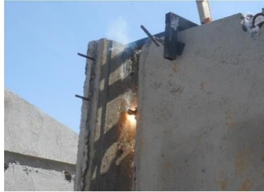
Figura 21 – Soldagem entre painéis.
