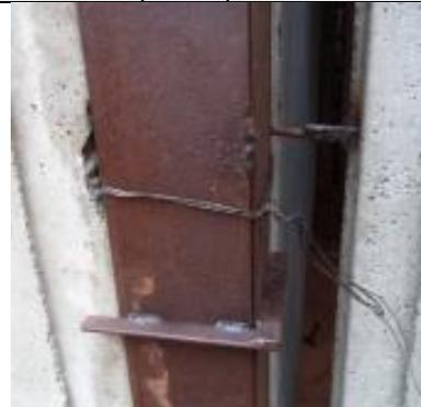
Após a concretagem entre os painéis, o tratamento das juntas é realizado com uso de tela de poliéster fixada com argamassa colante tipo ACI (Figura 28). O acabamento é realizado com a aplicação de camada de argamassa de revestimento (traço em volume 1:4, cimento: areia fina, com aditivo adesivo) e aplicação posterior de emulsão acrílica na região da junta (Figuras 29 e 30).
