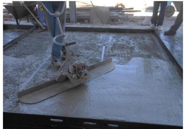
Figura 05 – Adensamento da primeira camada de concreto com régua vibratória.
