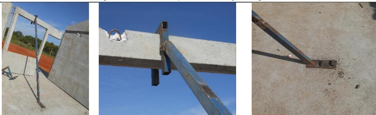
Figura 19 – Escora metálica (detalhes das fixações superior e inferior).
