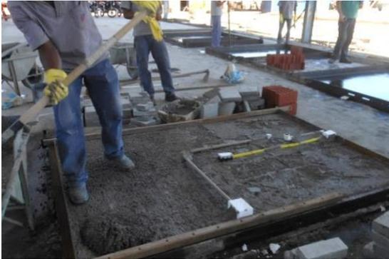
Figura 13 – Posicionamento das tubulações hidráulicas e lançamento da terceira camada de concreto ( $f_{ck}$  10 MPa) em painel de parede hidráulica.
