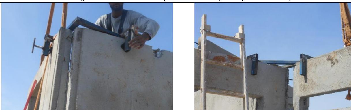
Figura 20 – Dispositivos metálicos de fixação entre painéis.
