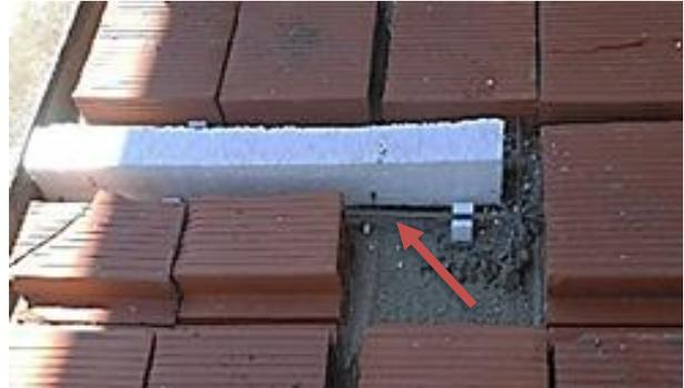
Figura 14 – Nicho com reforço para instalação de tubulação hidráulica (painel de parede hidráulica).
