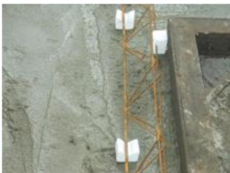
Figura 06 – Posicionamento das treliças metálicas e barras de aço retas (vergas e contra vergas).
