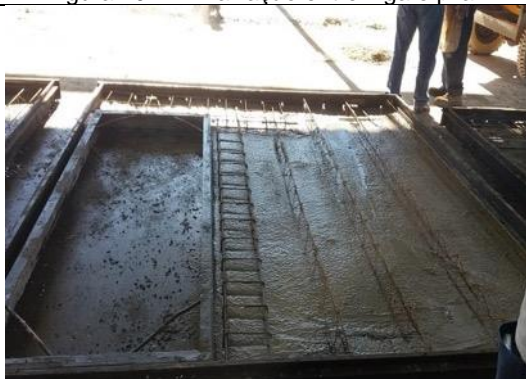
Figura 21 – Posicionamento das treliças.
