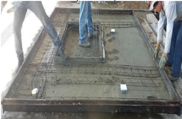
Figura 17 – Posicionamento das armaduras dos pilaretes.
