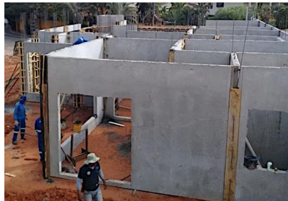
Figura 56 – Forma em madeira para concretagem da união entre painéis.
