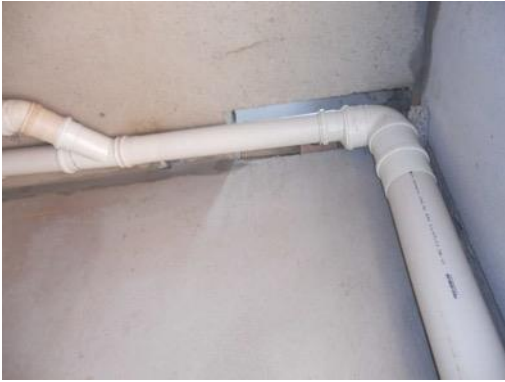
Figura 29 – Ligação das tubulações hidráulicas – shafts e forro.
