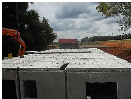
Figura 60 – Arranques utilizados na fixação das lajes com os painéis..
