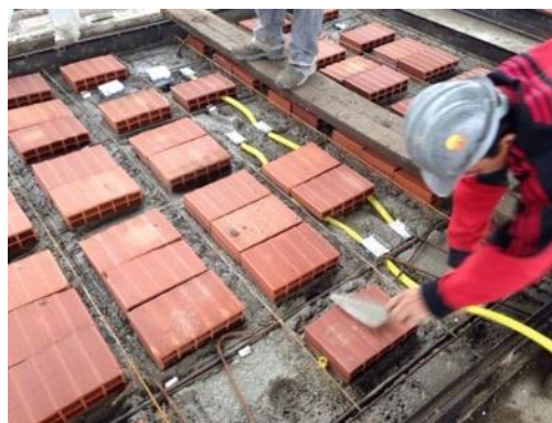
Figura 24 – Posicionamento das instalações elétricas.
