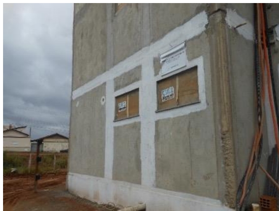
Figura 80 – Barrado de emulsão acrílica aplicado na face externa dos painéis.
