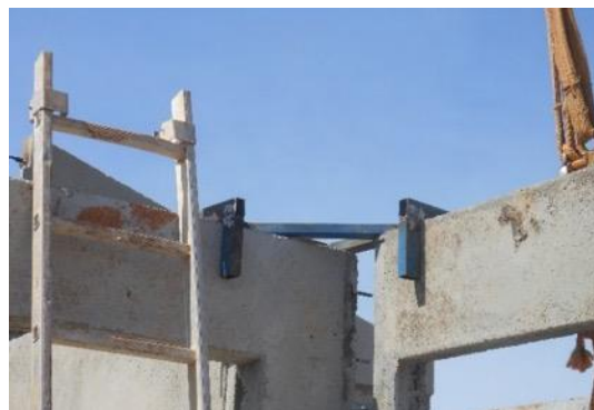
Figura 44 – Dispositivos metálicos de fixação entre painéis.
