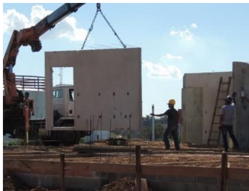
Figura 38 – Içamento dos painéis.
