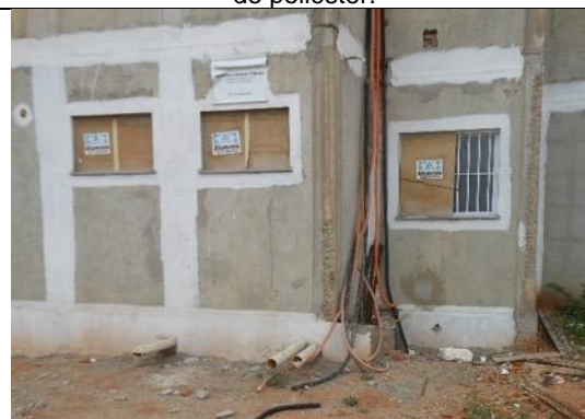
Figura 64 – Emulsão acrílica na região de juntas entre painéis.
