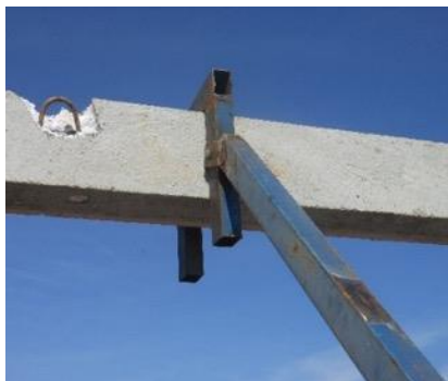
Figura 43 – Escoramento metálico do painel.
