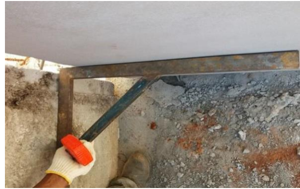
Figura 50 – Esquadros dos painéis.
