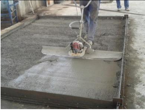
Figura 15 – Adensamento, com régua vibratória, da primeira camada de concreto.
