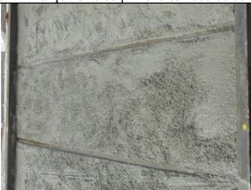
Figura 13 – Vão após a retirada da galga metálica.
