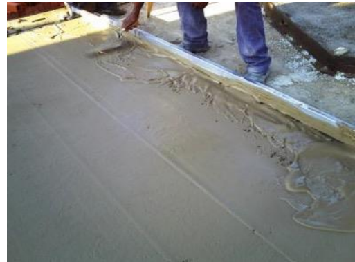
Figura 31 – Sarrafeamento da argamassa de acabamento.
