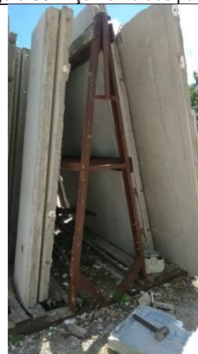
Figura 40 – Transporte e estocagem dos painéis na posição vertical.
