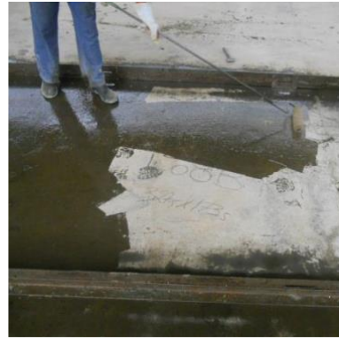
Figura 08 – Aplicação de desmoldante - rolo de espuma.
