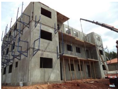
Figura 45 – Uso de canelões para a fixação dos painéis perimetrais.
