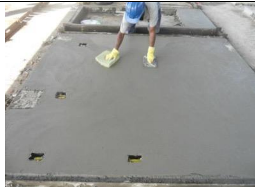
Figura 33 – Fim do desempeno do painel e início do feltro.
