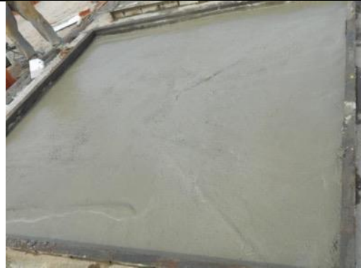
Figura 16 – Primeira camada de concreto após adensamento.
