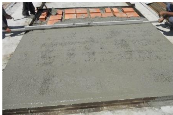
Figura 26 – Sarrafeamento da segunda camada de concreto.
