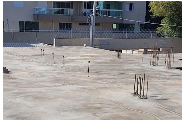
Figura 57 – Armadura dos pilares e respectivos traspasse.
