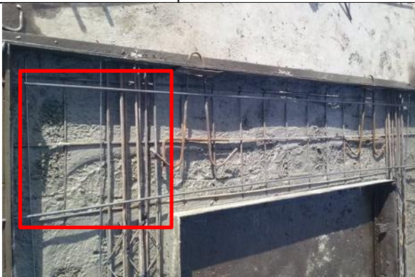
Figura 19 – Amarração entre viga e pilar.
