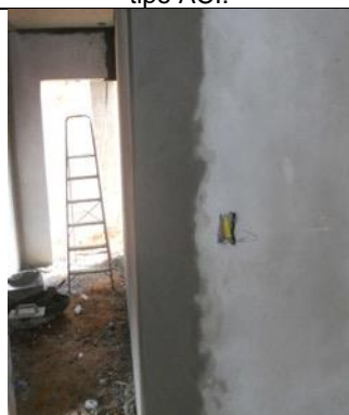
Figura 63 – Reboco sobre tratamento das juntas
