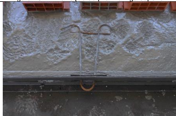
Figura 22 – Alças de içamento.
