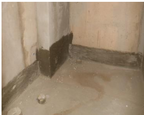
Figura 81 – Impermeabilização de áreas molhadas.
