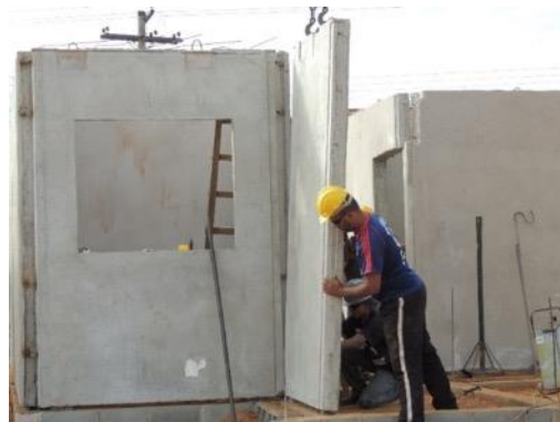
Figura 42 – Assentamento do painel.
