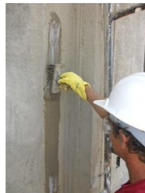
Figura 62 – Camada de argamassa ACI – fixação da tela de poliéster.
