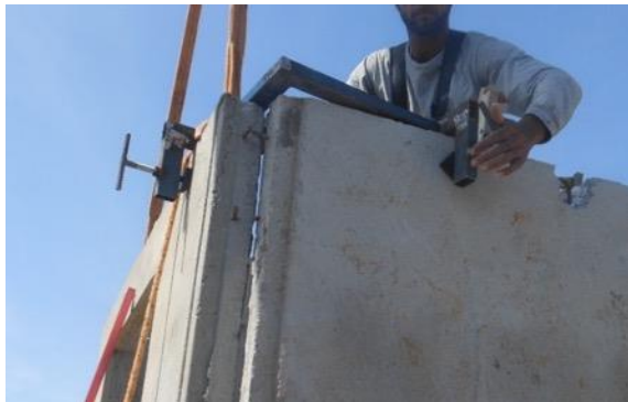
Figura 44 – Dispositivos metálicos de fixação entre painéis.
