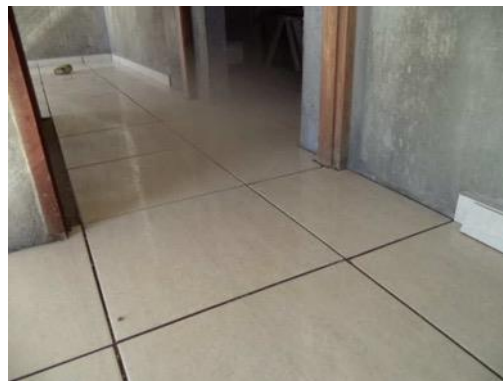
Figura 82 – Revestimento cerâmico - piso.
