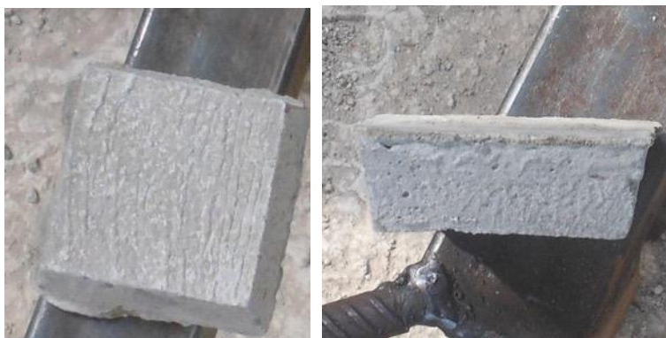
Figura 41 – Calço de argamassa.
