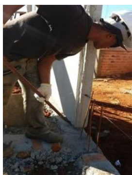
Figura 47 - Alinhamento do painel como auxílio de alavanca.
