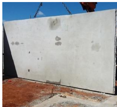
Figura 46 – Painéis presos pela alça de içamento.
