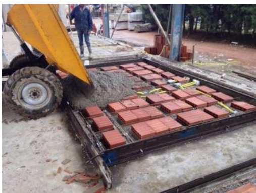
Figura 25 – Lançamento da segunda camada de concreto.
