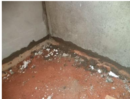
Figura 66 – Preenchimento do vão entre painel e fundação com argamassa.
