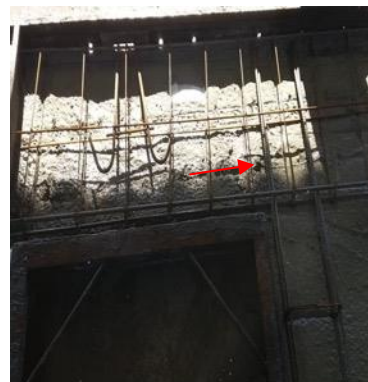
Figura 20 – Amarração do pilar na viga superior.
