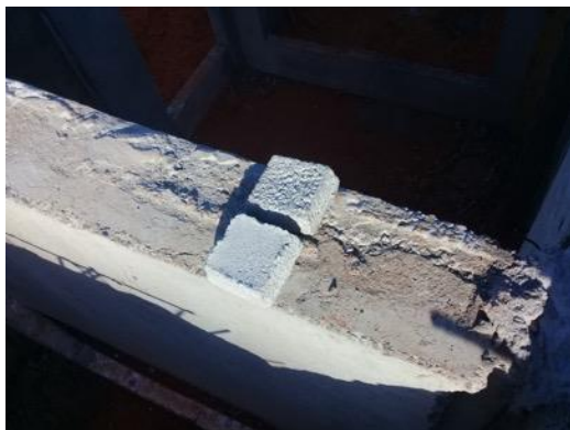
Figura 59 – Calços de apoio das lajes.
