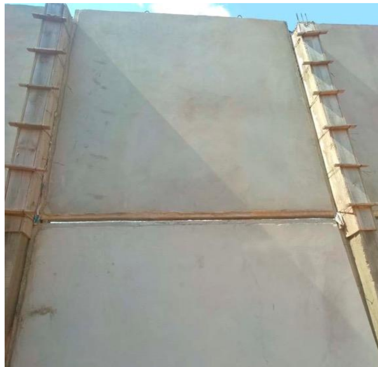
Figura 72 – Painéis de paredes sobrepostos.
