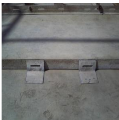
Figura 05 – Chapas auxiliares para as alças de içamento.
