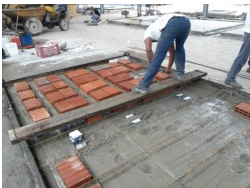
Figura 23 – Posicionamento das lajotas cerâmicas.
