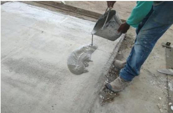
Figura 30 – Aplicação da argamassa de acabamento.
