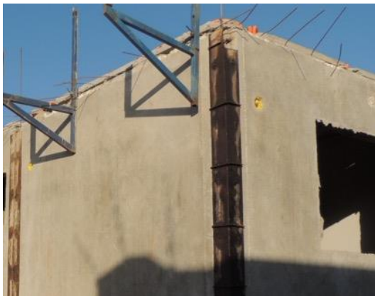
Figura 55 – Forma metálica para concretagem da união entre painéis.
