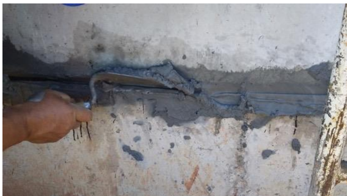
Figura 73 – Argamassa de vedação entre fundação e parte inferior do painel de parede.
