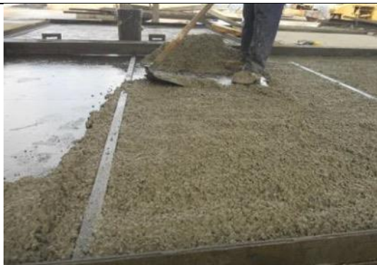
Figura 11 - Lançamento da primeira camada de concreto.
