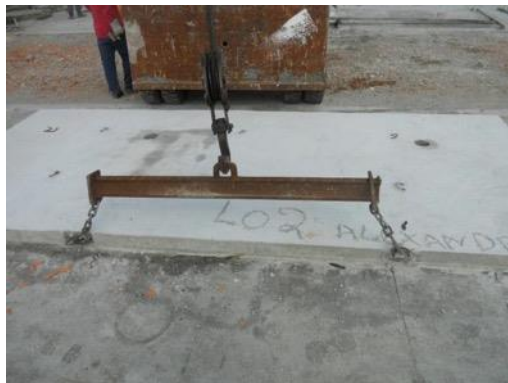
Figura 37 – Dispositivo de içamento e transporte.
