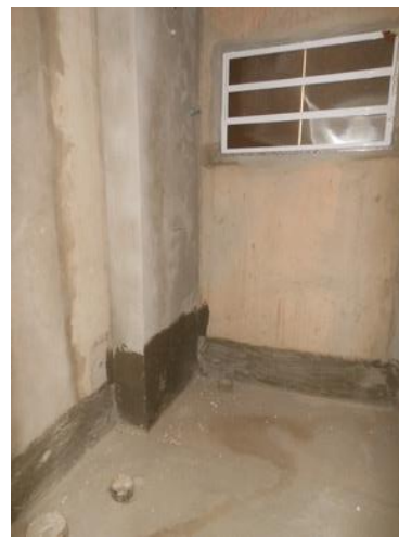
Figura 77 – Shaft de alvenaria de blocos cerâmicos.
