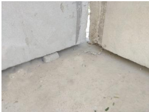
Figura 65 – painel posicionado sobre calços de argamassa.
