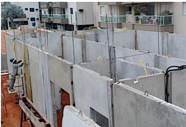
Figura 58 – Conformação dos pilares armados.
