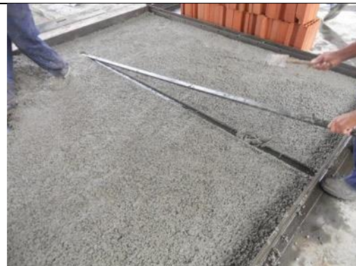
Figura 12 – Retirada da galga metálica.
