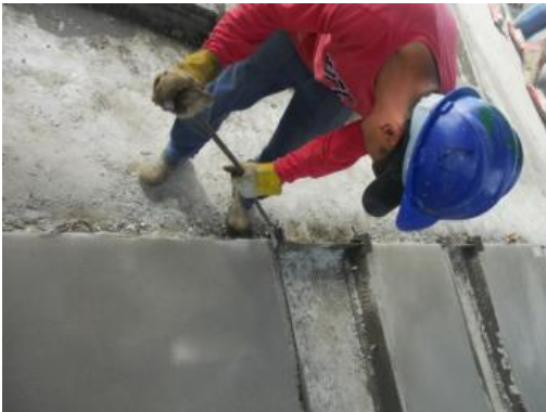
Figura 35 – Desmoldagem dos painéis.
