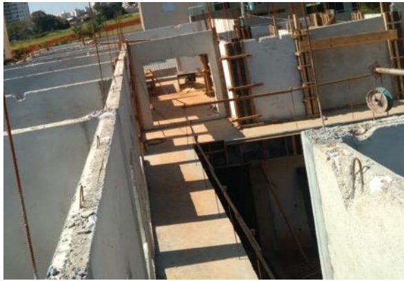
Figura 57 – Armadura dos pilares e respectivos traspasse.
