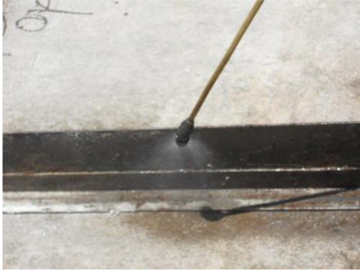
Figura 07 – Aplicação de desmoldante - pulverizador manual.
