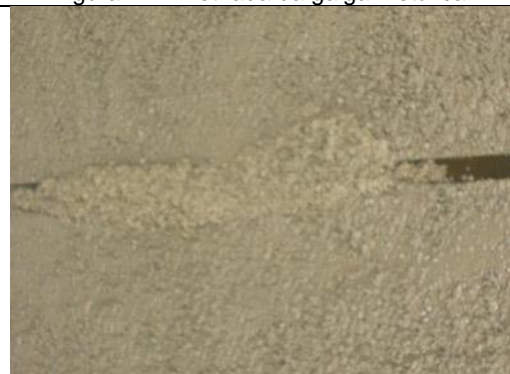
Figura 14 – Preenchimento do vão com concreto.
