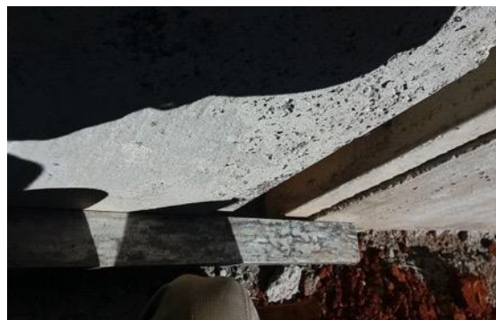
Figura 48 – Alinhamento do painel utilizando régua como conferência.
