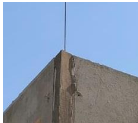
Figura 58 – Conformação dos pilares armados.
