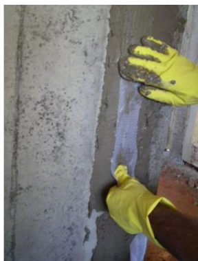
Figura 61 – Tela de poliéster sobre argamassa colante tipo ACI.
