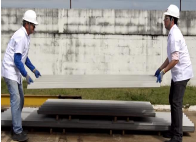
Figura 16 – Descarga e transporte na obra das telhas onduladas de fibrocimento sem amianto – tipo pequenas ondas (PO) de 4 mm de espessura (imagens cedidas pela Brasilit)
