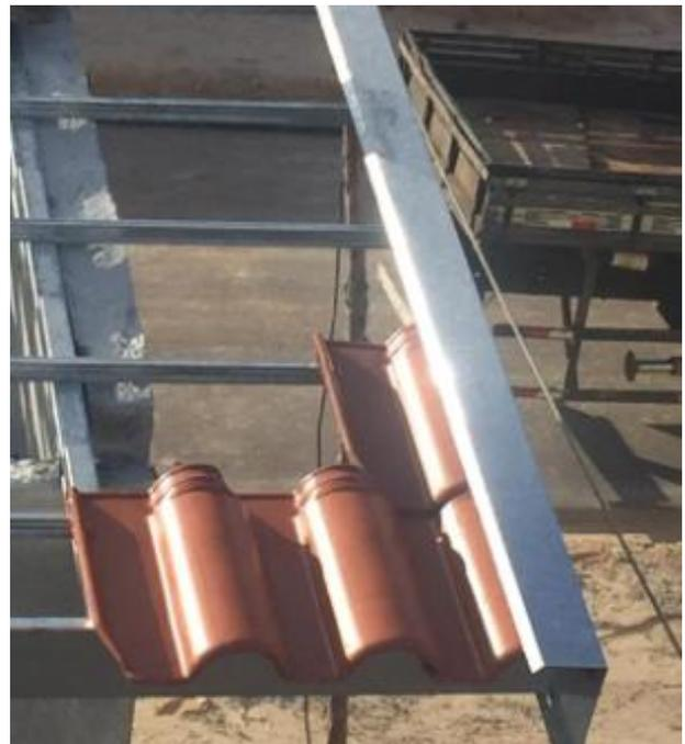
Encaixe da quarta telha, garantindo o recobrimento lateral mínimo de 45mm
