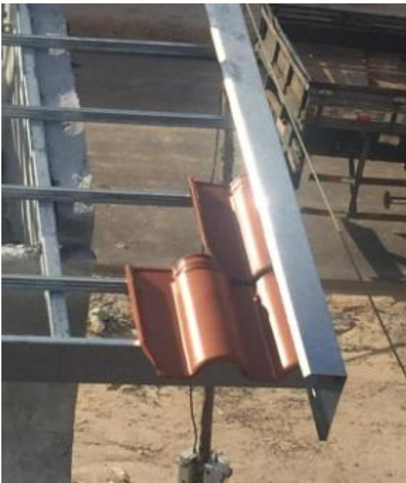
Encaixe da terceira telha, garantindo o recobrimento longitudinal mínimo de 65mm
