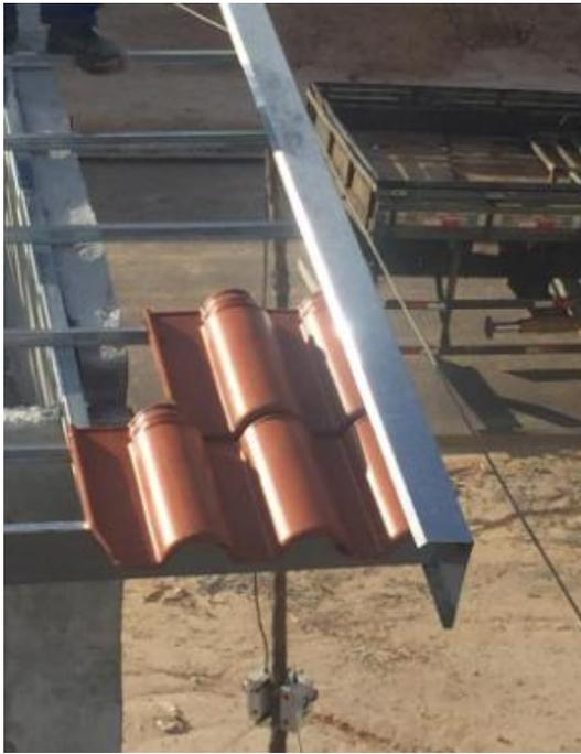
Encaixe da quinta telha, garantindo o recobrimento longitudinal mínimo de 65mm
