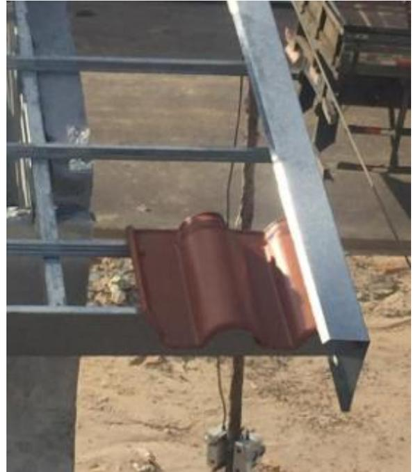
Encaixe da segunda telha, garantindo o recobrimento lateral mínimo de 45mm
