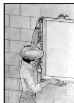
Figura 29 – Posicionamento do Quadro (Imagem Cedida Pela AFEAL)
