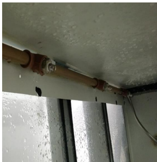
Figura 11 – Detalhe da Aspersão do Jato no Ensaio de Determinação da Estanqueidade à Água
