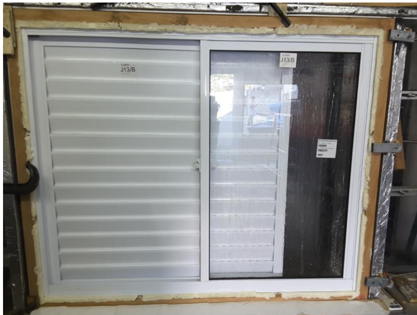
Figura 10 – Execução do Ensaio de Estanqueidade à Água
