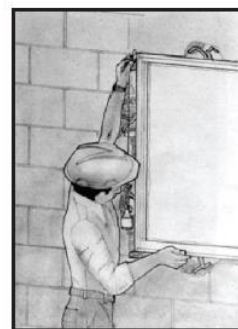
Figura 29 – Posicionamento do Quadro (Imagem Cedida Pela AFEAL)
