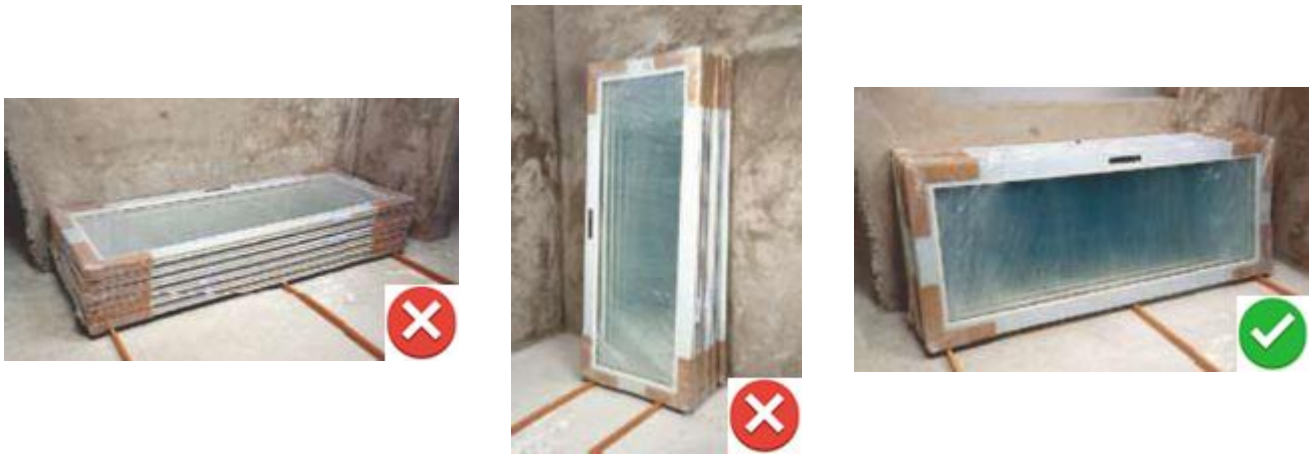
Figura 27 – Armazenamento de folhas de esquadrias de correr de perfis em PVC rígido. Imagem cedida pela TIGRE LTDA.
