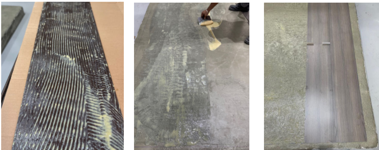
Figura 6 – Instalação do piso decorativo de alta pressão (HPL, HPDL) por colagem.
