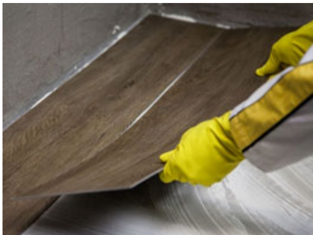
Figura 7 – Instalação do piso laminado vinílico colado
