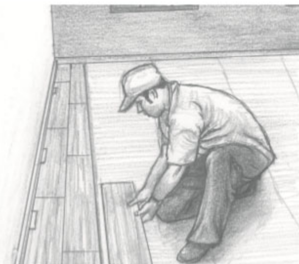
Figura 3 – Instalação do piso laminado melamínico flutuante por encaixe.
