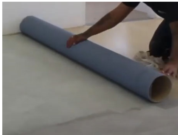
Figura 8 – Instalação do piso laminado vinílico em manta
