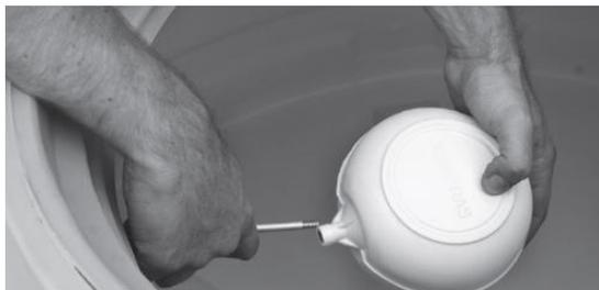
Figura 12 - Ilustração da instalação da boia e sua haste no interior do reservatório
