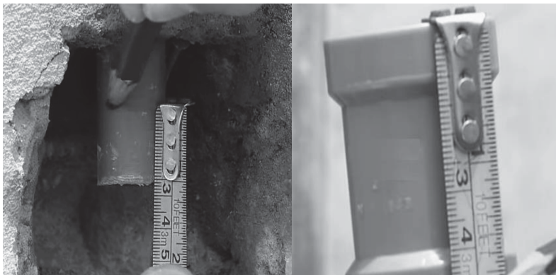
Figura 32 – Marcação da metade do comprimento da Luva de correr na tubulação antiga
