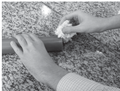
Figura 12 - Superfície sendo limpa com solução apropriada
