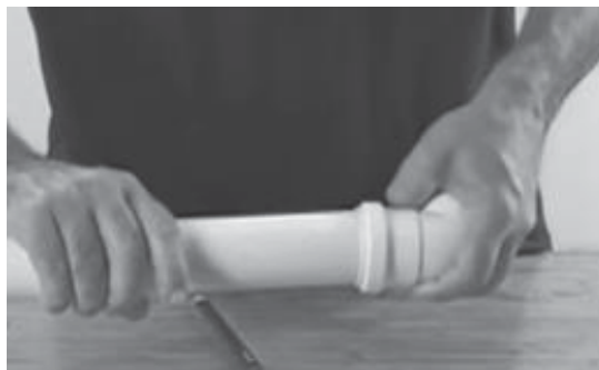
Figura 22 - Encaixe do tubo na bolsa
