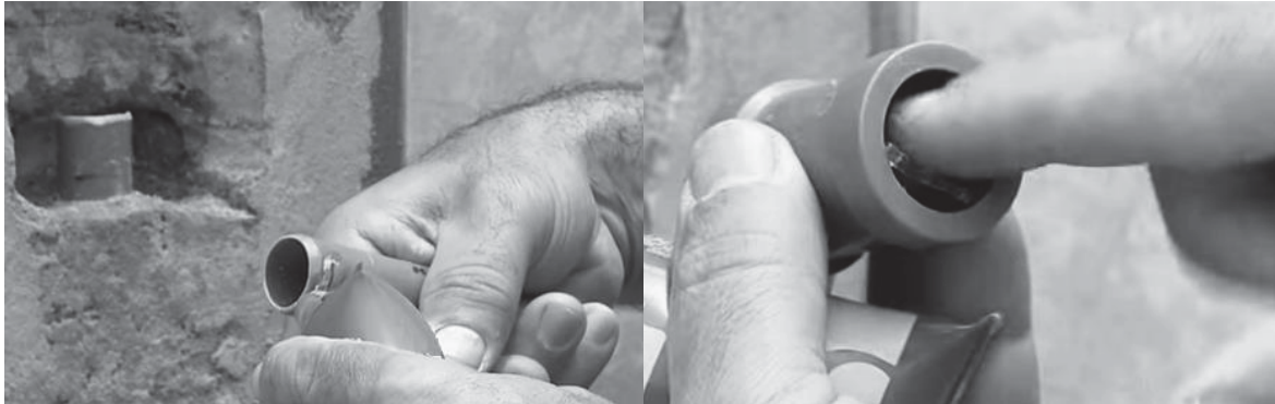
Figura 33 – Pasta lubrificante sendo aplicada no novo trecho e no anel elástico o-ring da luva de correr
