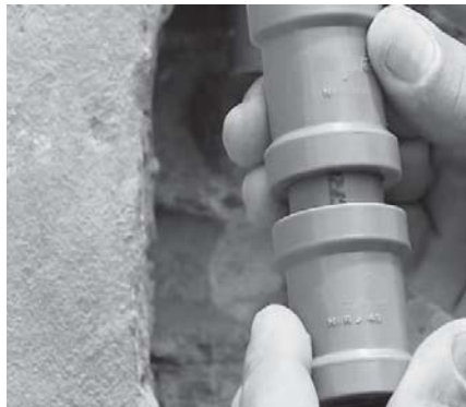
Figura 34 – Luvas de correr colocadas no novo trecho
