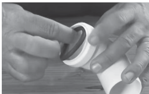
Figura 20 - Posicionamento do anel em seu alojamento ("virola")
