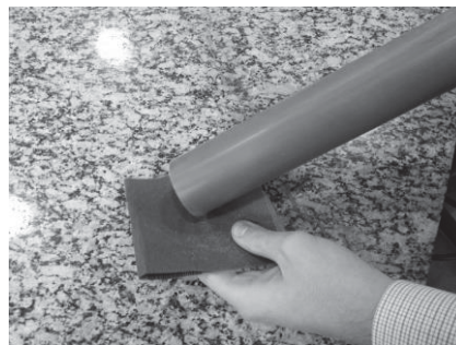
Figura 11 – Lixamento da extremidade do tubo
