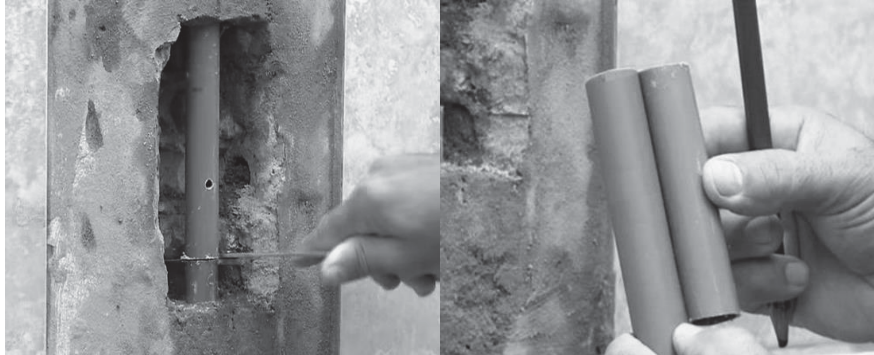
Figura 31 – Substituição do segmento danificado
