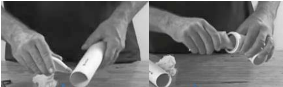
Figura 21 - Aplicação da pasta sobre a superfície do tubo e anel elástico
