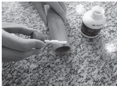
Figura 13 - Adesivo sendo aplicado na superfície a ser soldada
