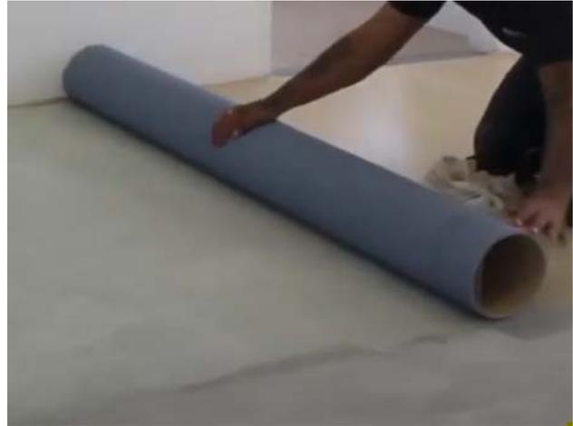
**Figura 8 – Instalação do piso laminado vinílico em manta**
