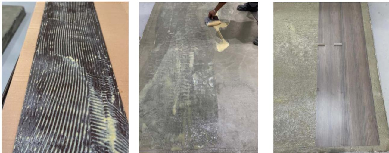
**Figura 6 – Instalação do piso decorativo de alta pressão (HPL, HPDL) por colagem.**
