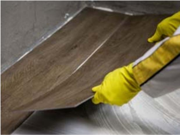
**Figura 7 – Instalação do piso laminado vinílico colado**
