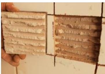
Corte seccionando a argamassa colante
