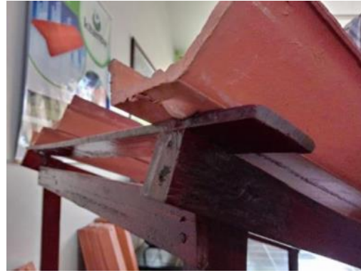
Figura 5 - Demonstração do encaixe do pino no ripamento
