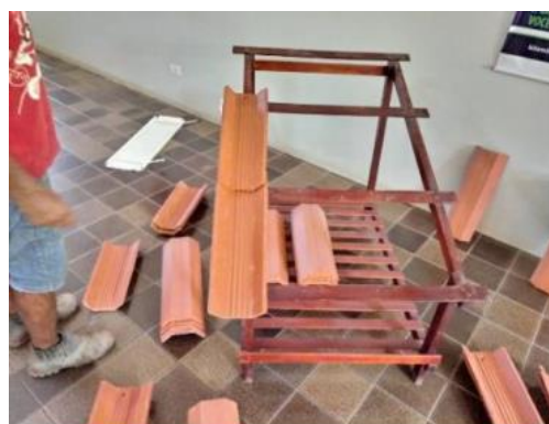
Figura 3 - Colocação da segunda telha, garantindo o recobrimento longitudinal mínimo de 75mm
