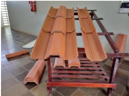
Figura 6 - Colocação da telha (posição da capa)
