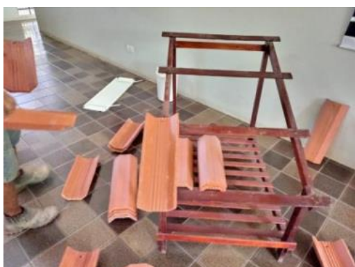
Figura 2 - Colocação da primeira telha (posição canal)
