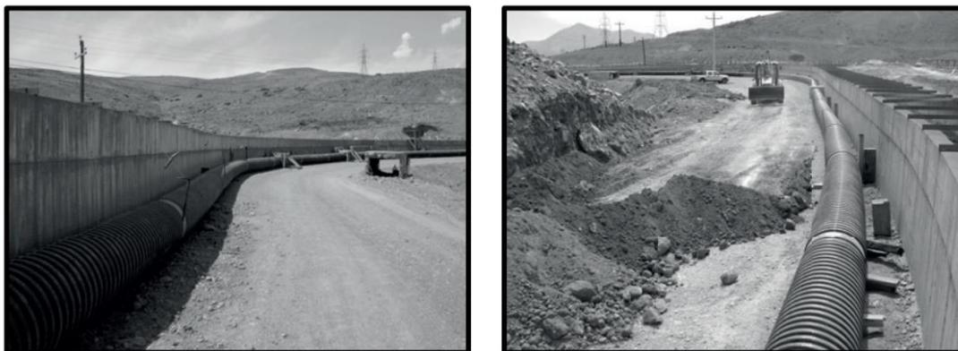
**Figura 16 – Instalações curvilíneas (figura extraída do Manual de Bolso para instalações de tubulações corrugadas Tigre-ADS).**
