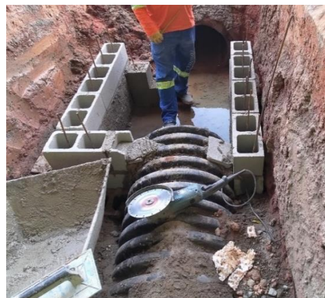
(b) Tubulação na caixa de inspeção (Guarulhos/SP)
