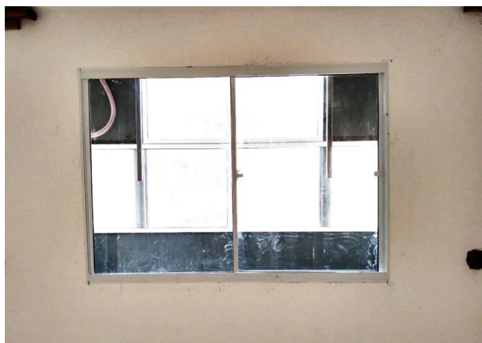
Figura 18 – Esquadria in loco - análise com câmara de estanqueidade
