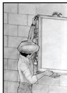
Figura 29 – Posicionamento do Quadro (Imagem Cedida Pela AFEAL)
