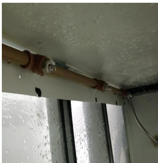
Figura 11 – Detalhe da Aspersão do Jato no Ensaio de Determinação da Estanqueidade à Água
