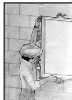
Figura 29 – Posicionamento do Quadro (Imagem Cedida Pela AFEAL)
