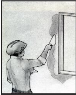
Figura 38 – Acabamento de Emboço Interno (Imagem Cedida Pela AFEAL)
