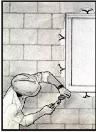
Figura 32 – Posicionamento do Contramarco (Imagem Cedida Pela AFEAL)
