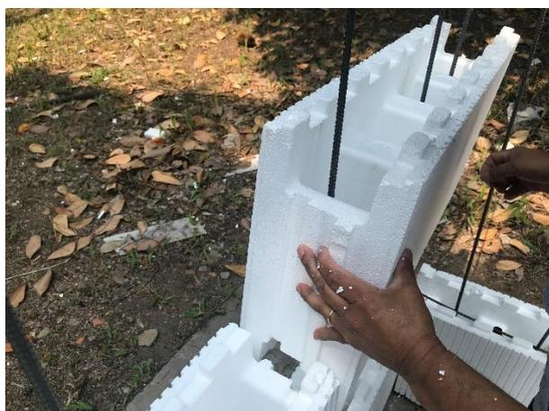
**Figura 11 – Encaixe da segunda fiada**
