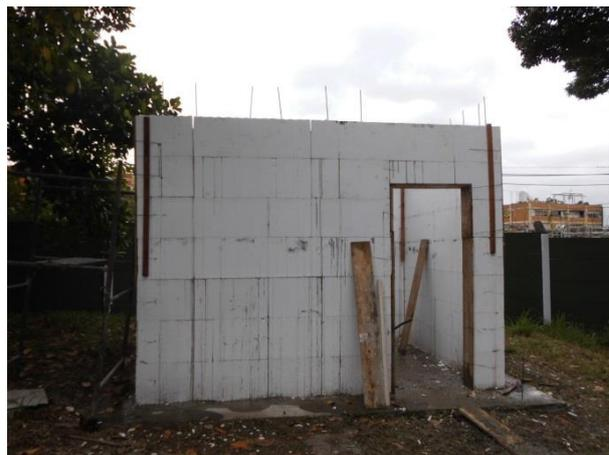
**Figura 16 – Paredes com os blocos preenchidos com concreto**
