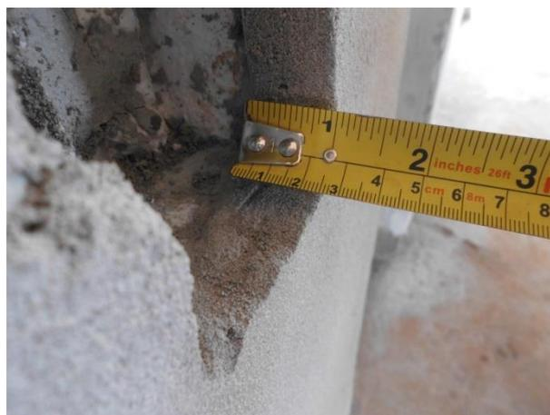
Figura 26 – Revestimento com 25 mm de espessura
