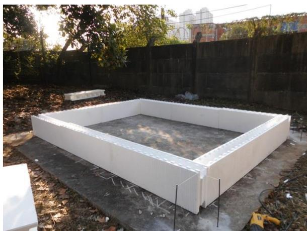
Figura 1 – Posicionamento da primeira fiada
