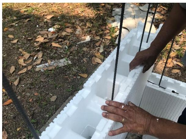
**Figura 12 – Encaixe da segunda fiada**
