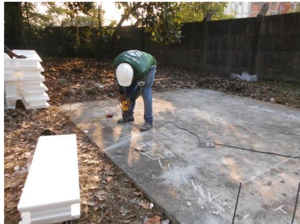
**Figura 8 – Chumbamento da armadura das paredes à fundação**
