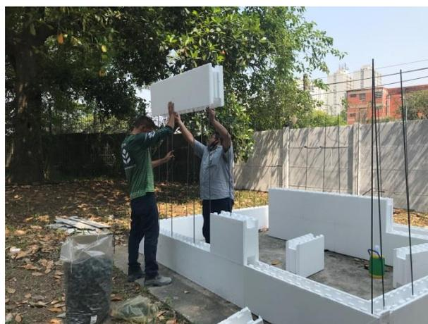
Figura 2 – Colocação dos blocos da segunda fiada
