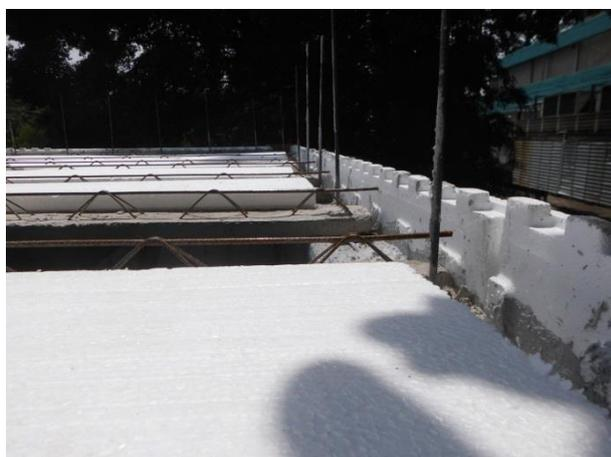
**Figura 17 – Execução da laje**
