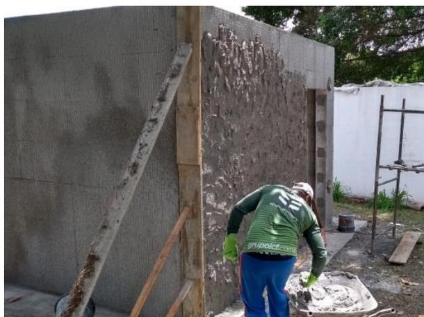
Figura 25 – Revestimento das paredes
