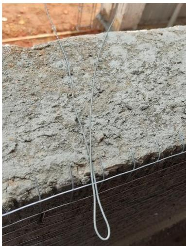
**Figura 23 – Conector das telas do revestimento**
