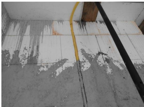
**Figura 19 – Eletroduto embutido em rebaixo**
