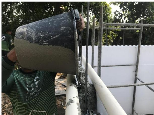
**Figura 15 – Lançamento do concreto**
