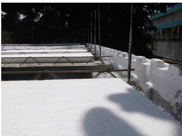
**Figura 17 – Execução da laje**
