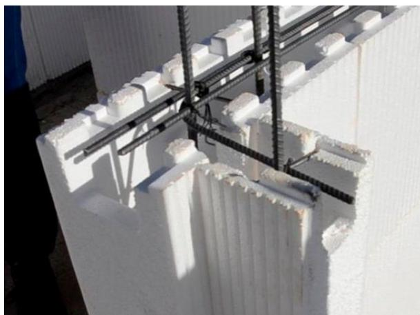
Figura 4 – Ligação entre paredes a 90 graus
