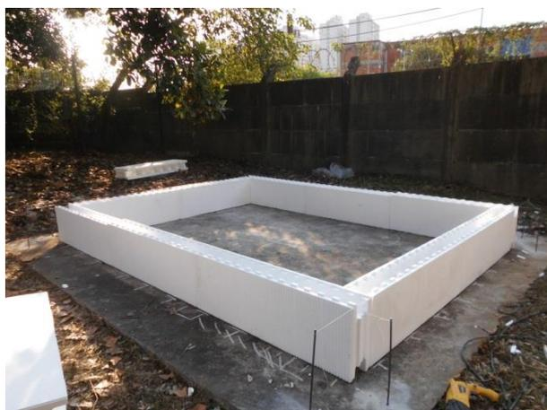
Figura 1 – Posicionamento da primeira fiada
