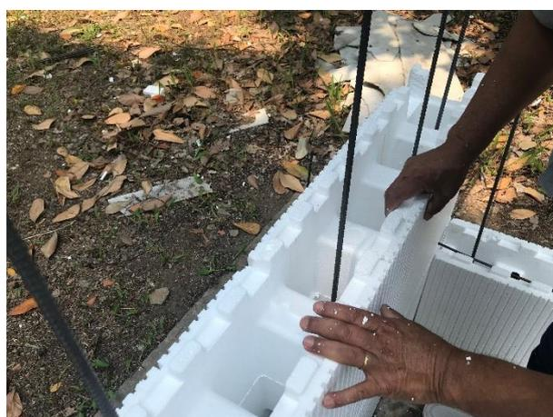
**Figura 12 – Encaixe da segunda fiada**
