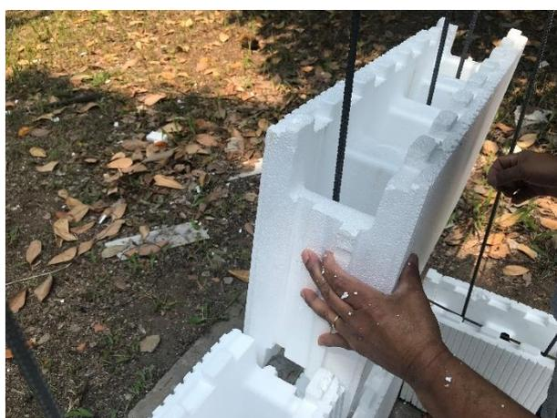
**Figura 11 – Encaixe da segunda fiada**
