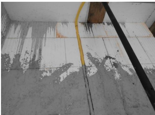
**Figura 19 – Eletroduto embutido em rebaixo**
