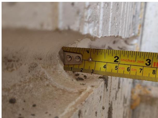
**Figura 20 – Rebaixo no EPS para embutimento de tubulação**
