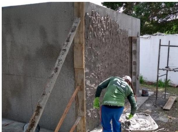
Figura 25 – Revestimento das paredes
