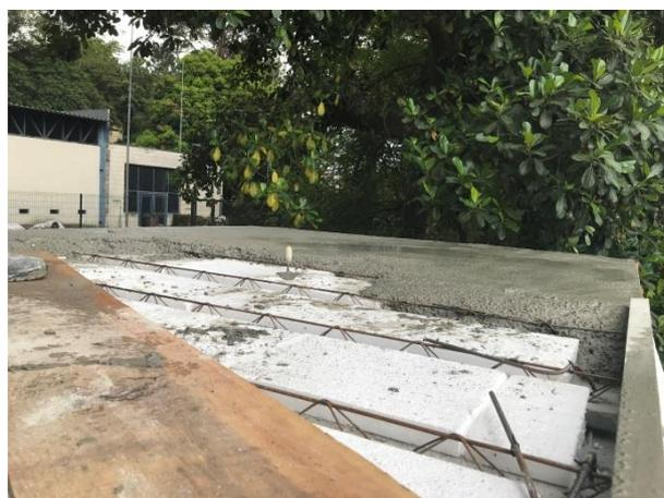
**Figura 18 – Concretagem da laje**
