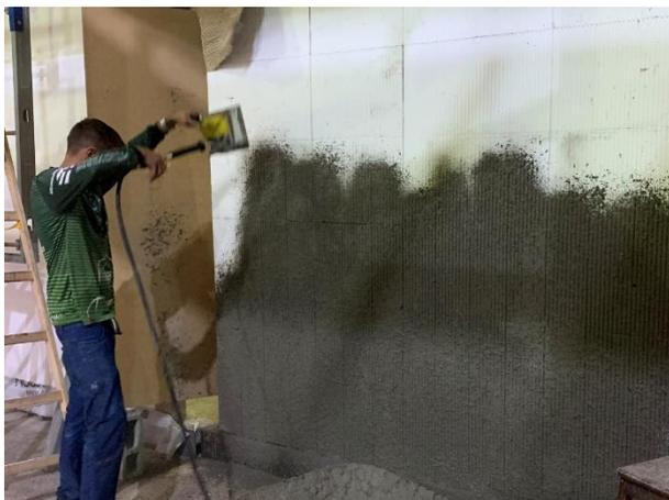
**Figura 21 – Chapisco da parede**
