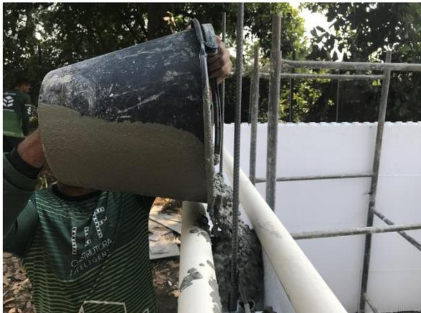
**Figura 15 – Lançamento do concreto**
