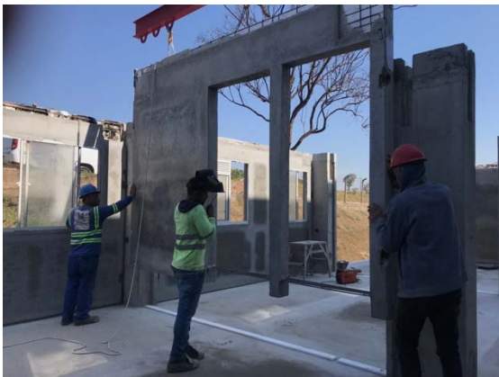
Figura 03 – Posicionamento do painel de vedação sobre lâmina de EPS.
