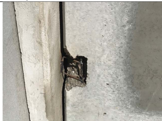
Figura 04 – Ligação entre painel de vedação e pilar.
