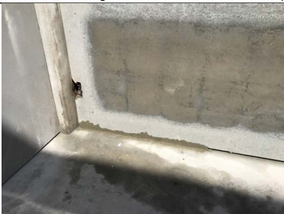
Figura 04 – Ligação entre painel de vedação e pilar.
