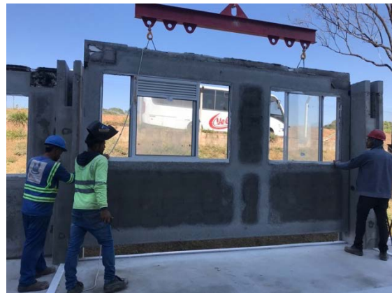
Figura 03 – Posicionamento do painel de vedação sobre lâmina de EPS.
