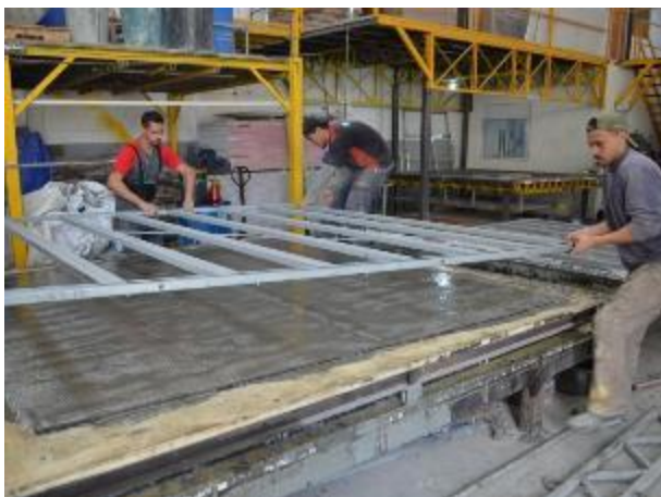
Figura 19 – Colocação do quadro de aço sobre a mistura (massa) fresca.
