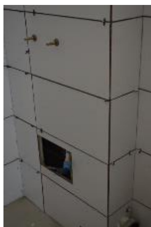
Figura 25 – Execução do revestimento interno de placas cerâmicas no banheiro.
