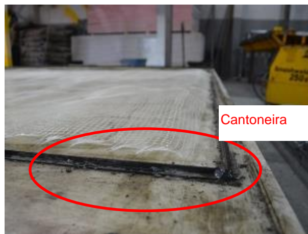
Figura 14 – Tela de fibra de vidro da face inferior da chapa cimentícia.
