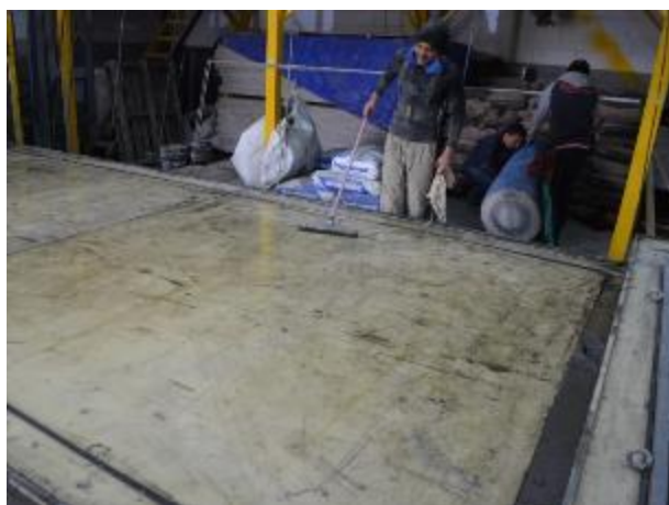
Figura 13 – Limpeza e aplicação de desmoldante no molde.
