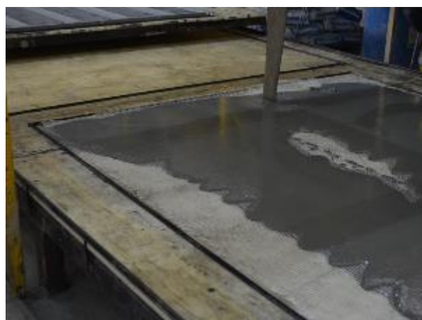
Figura 16 – Lançamento da mistura da chapa cimentícia à forma.
