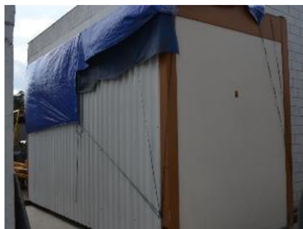
Figura 26 – Módulo pré-fabricado (unidade habitacional pronta), em estoque.
