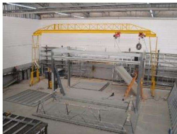
Figura 12 – Montagem da estrutural central.
