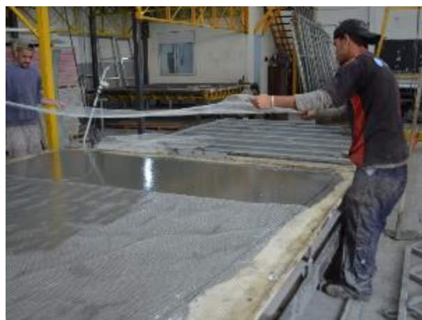
Figura 18 – Colocação da tela de fibra de vidro da face superior.
