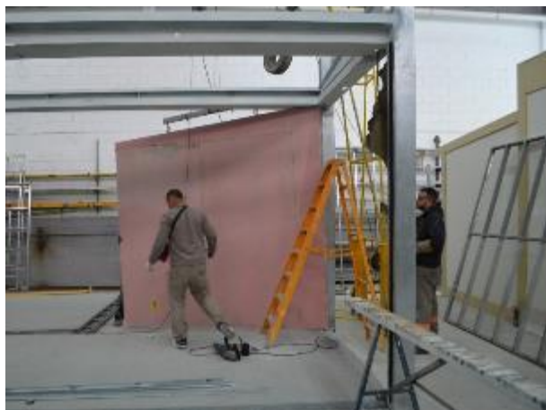
Figura 23 – Montagem dos painéis de parede internos.
