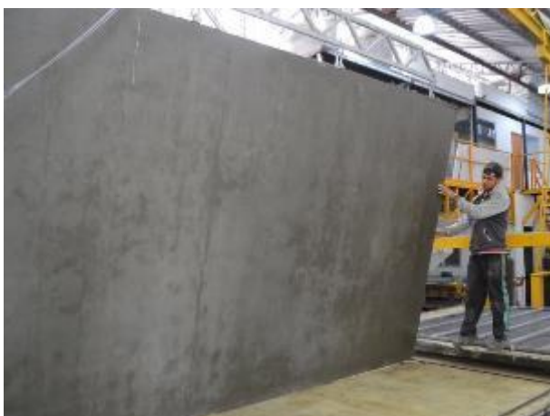
Figura 21 – Içamento do painel de parede.
