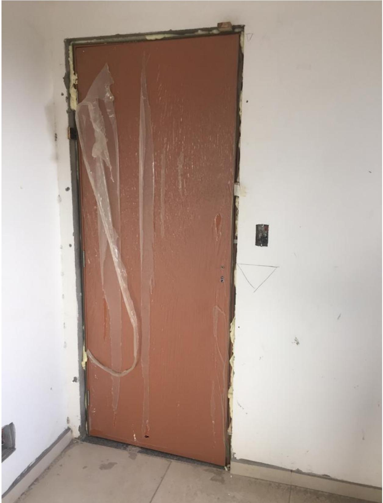
**Figura 15** – Fixação de porta com espuma expansível de PUR
