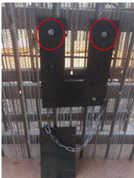
**Figura 11** - Base para suporte de caixa elétrica Coffor
