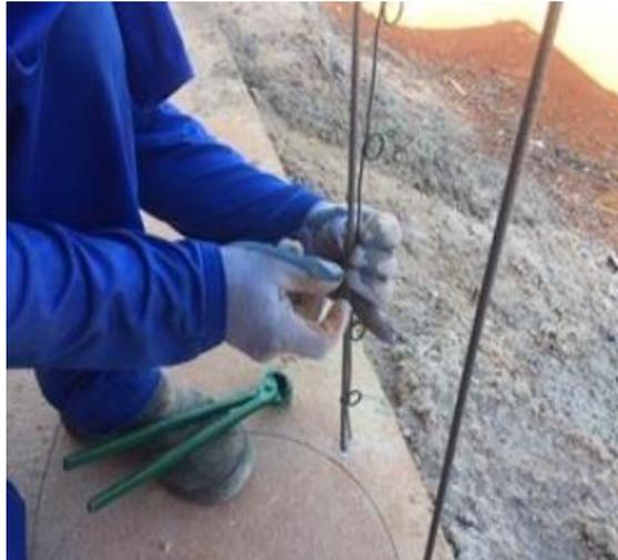
**Figura 21** – Posicionamento das esperas para as armaduras horizontais
