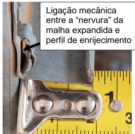
**Figura 6** – Detalhe da ligação entre os painéis de face e o perfil de enrijecimento
