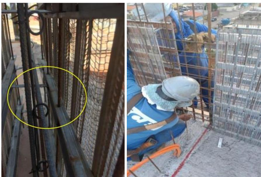
**Figura 23** – Armadura horizontal da parede posicionada (esquerda) e armação de pilar (direita)
