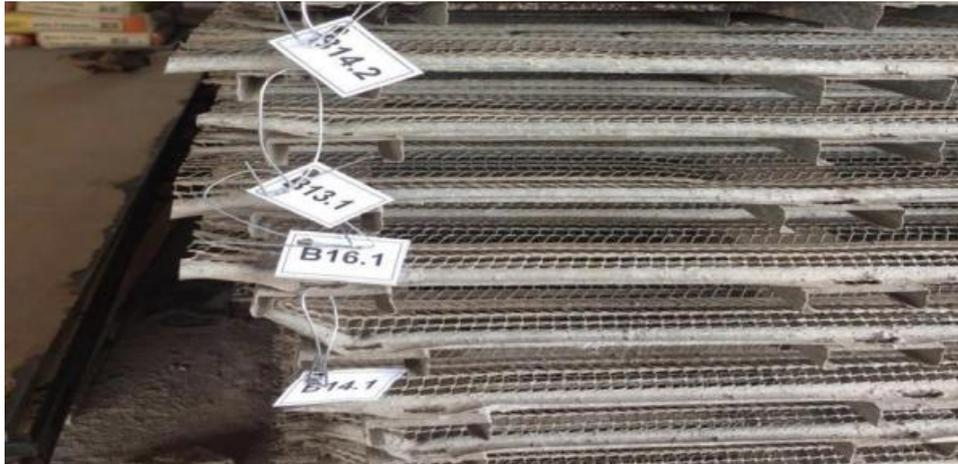
**Figura 18** – Painéis cortados e identificados conforme projeto de montagem de formas Coffor
