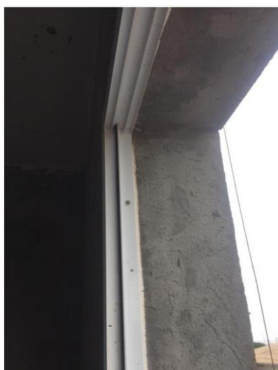
Figura 14 - Fixação das janelas com parafusos na face lateral
