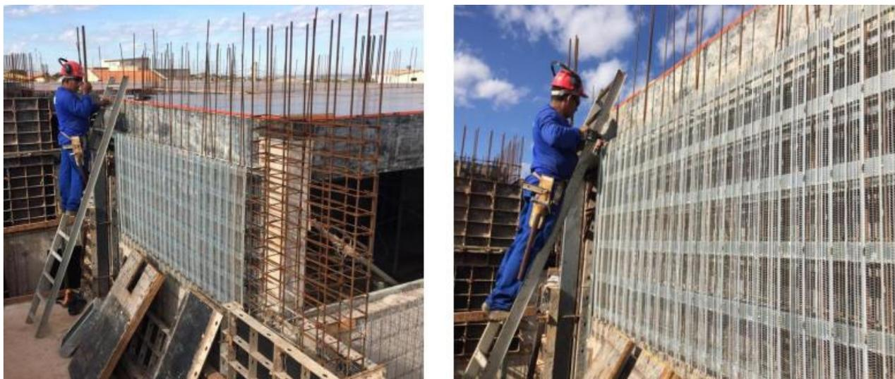
**Figura 31** - Posicionamento das armaduras horizontais no segundo trecho das paredes
