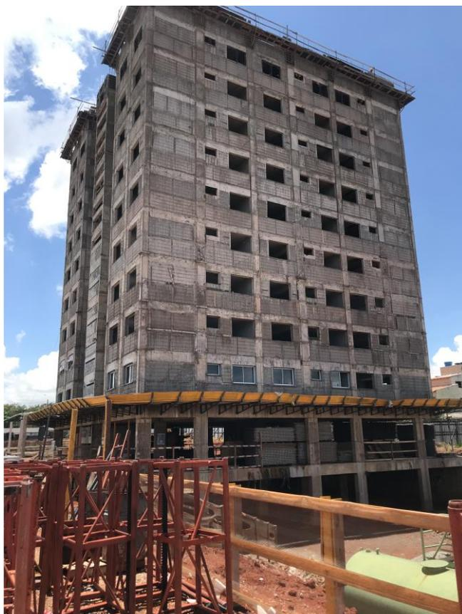
**Figura 1** – Edificação multifamiliar de múltiplos pavimentos em execução com o sistema Coffor.
