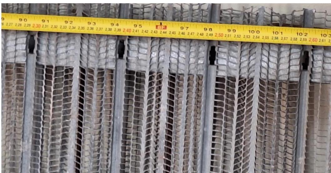
**Figura 5** – Forma incorporada Coffor com detalhe para a distância entre “nervuras” do painel de face
