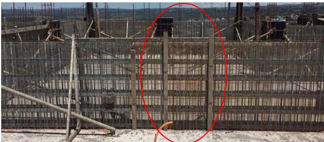
**Figura 25** - Formas Coffor posicionadas com destaque na interface entre trechos de forma distintos
