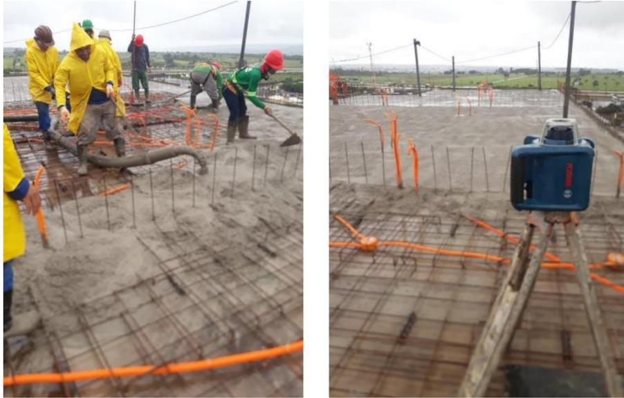
**Figura 34** – Lançamento do concreto com bomba de concreto e mangueira
