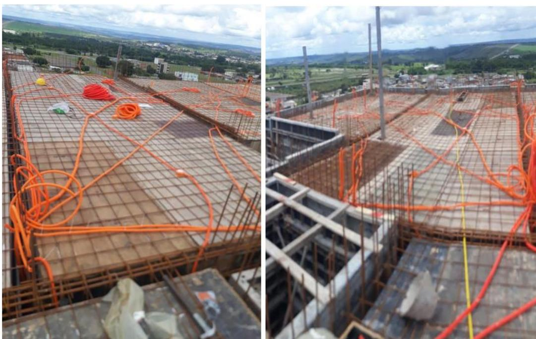
**Figura 33** - Posicionamento das instalações elétricas nas lajes
