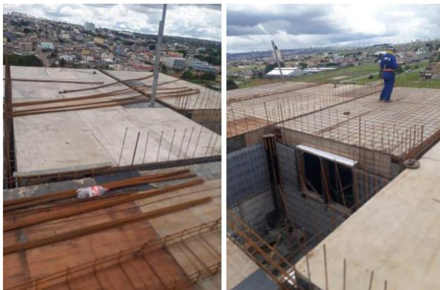
**Figura 32** – Armação das lajes e vigas
