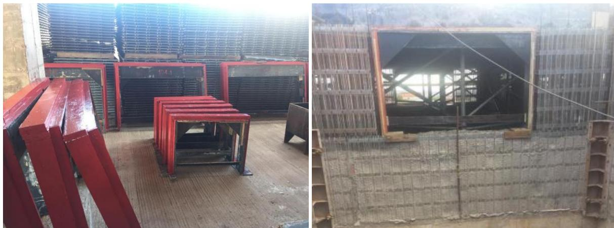
Figura 13 – Fechamento do vão de esquadrias com formas de madeira para concretagem
