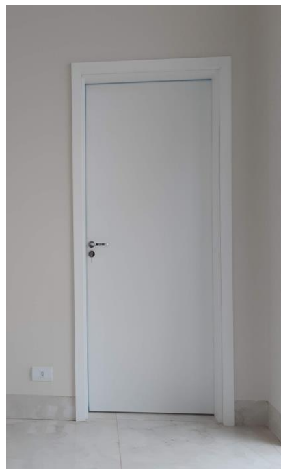
Figura 2 – Kit porta pronta com marco de “PVC Wood” instalado.
