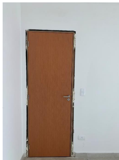
Figura 11 – Aplicação dos três pontos de espuma de poliuretano em cada montante, para fixação da porta ao vão.
