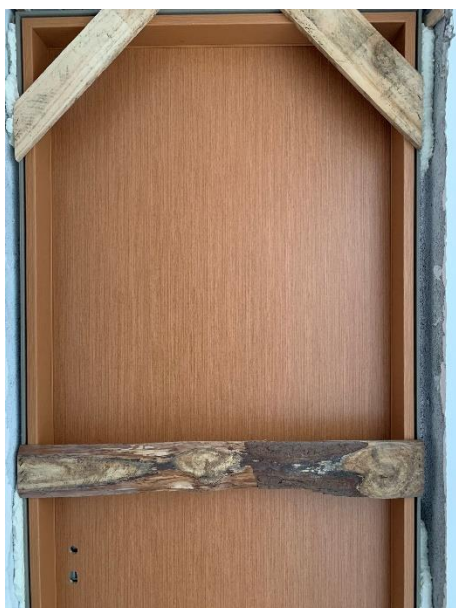
Figura 10 – Kit porta pronta com travas de madeira, posicionado no vão.
