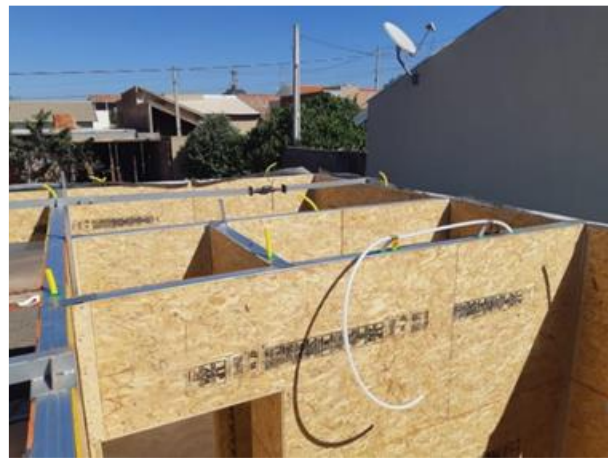
Figura 3 – Instalação dos painéis de parede em obra – local definitivo
