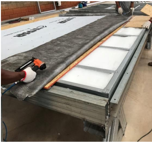
Figura 2 – Montagem dos painéis de parede na fábrica
