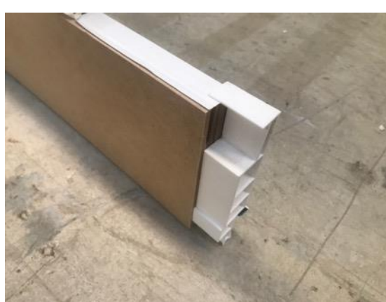
Figura 12 – Detalhe do amortecedor e peças plásticas na base do marco.
