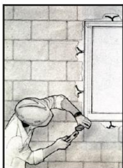
Figura 29 – Posicionamento do Contramarco (Imagem Cedida Pela AFEAL)
