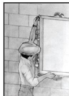
Figura 32 – Posicionamento do Quadro (Imagem Cedida Pela AFEAL)
