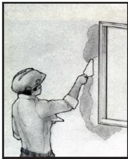
Figura 35 – Acabamento de Emboço Interno (Imagem Cedida Pela AFEAL)
