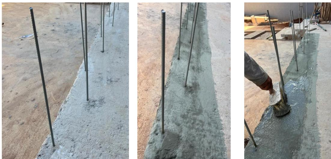
Figura 20 – Aplicação da impermeabilização da base das paredes
