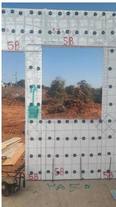
Figura 7 – Painel de EPS com espaçadores e tela de aço galvanizado
