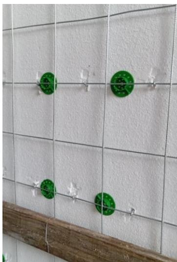
Figura 5 – Painel de EPS com espaçadores, tela de aço galvanizado e grampo tipo “J”
