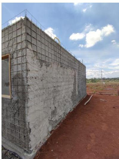
Figura 26 – Primeira camada de revestimento
