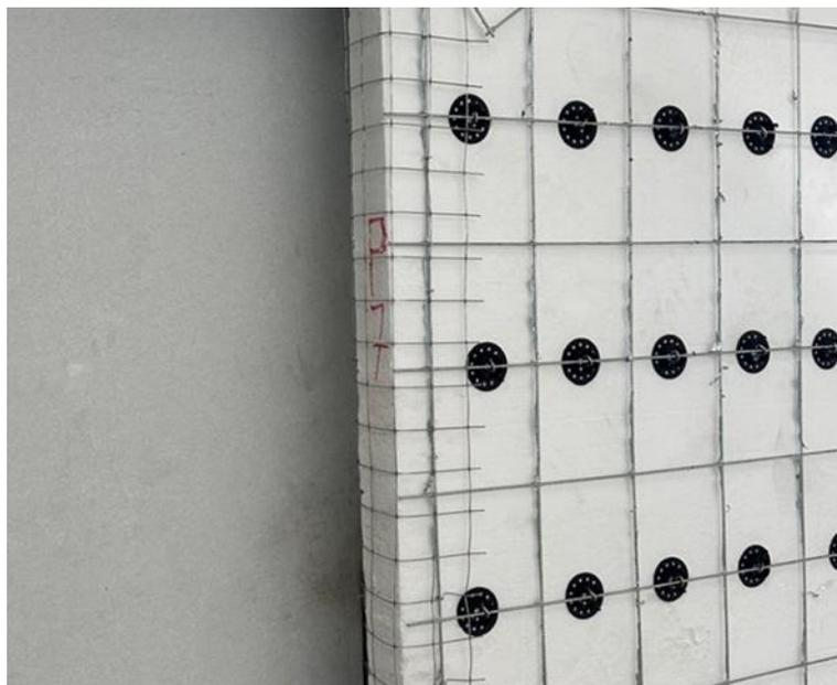
Figura 6 – Ilustração da tela de aço galvanizado tipo “U” instalada no vão da esquadria
